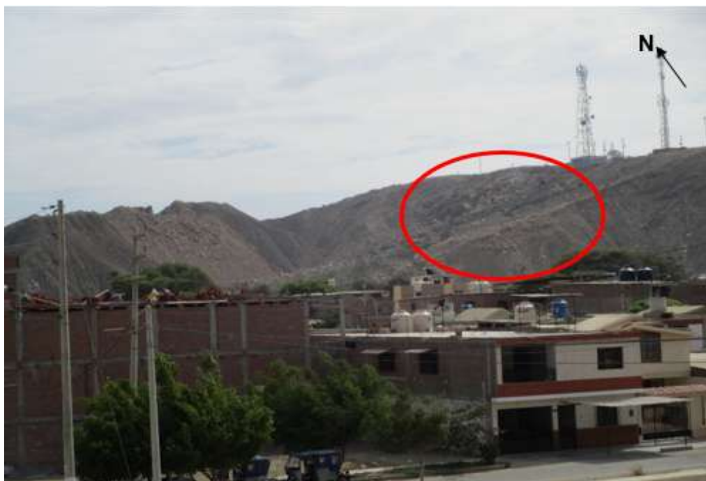
Foto 23: Caída de rocas en el sector urbano oeste
