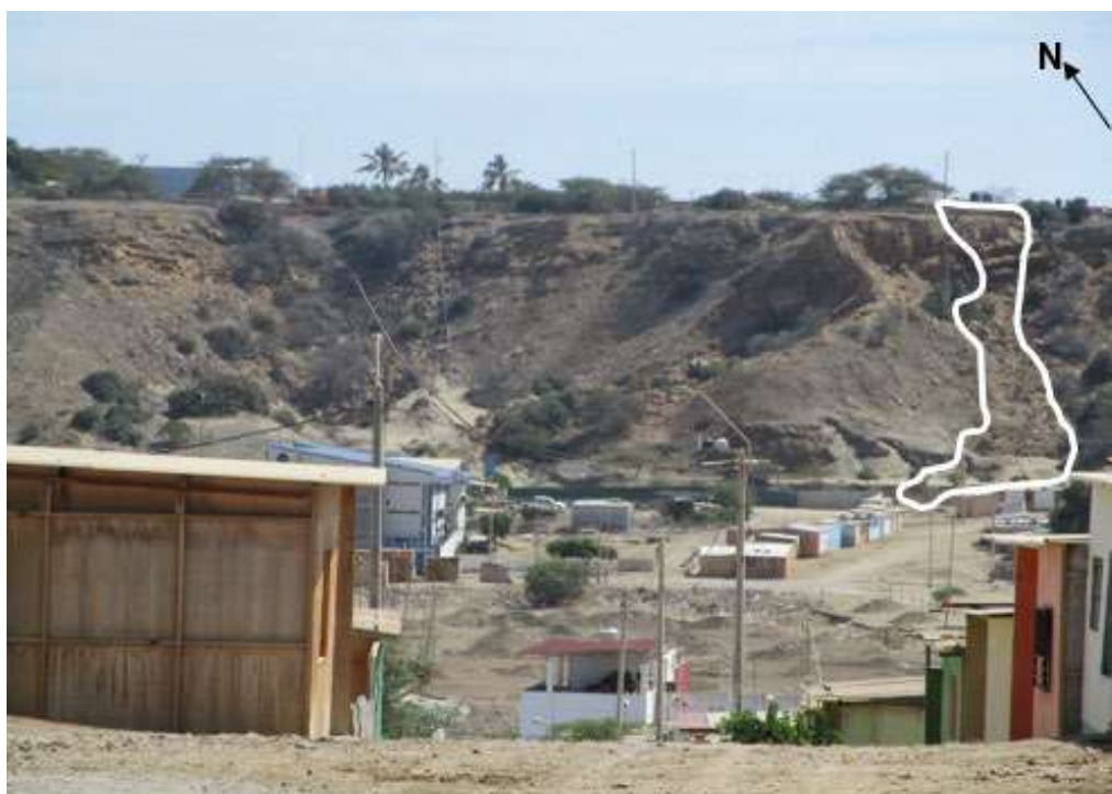
Foto 24: Flujo de detritos, zona de tablazo
