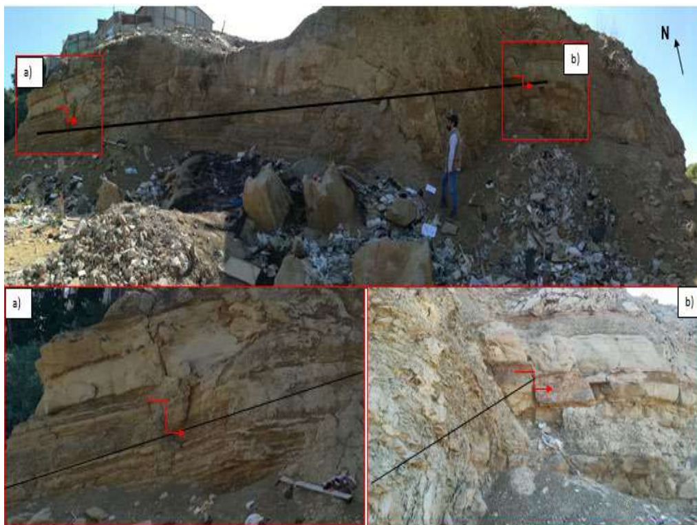
Foto 18: Zona de bloques de areniscas desplazados por la actividad de la falla El Acholao, en la parte superior de estos estratos se ubica el AA.HH. Los Robles
