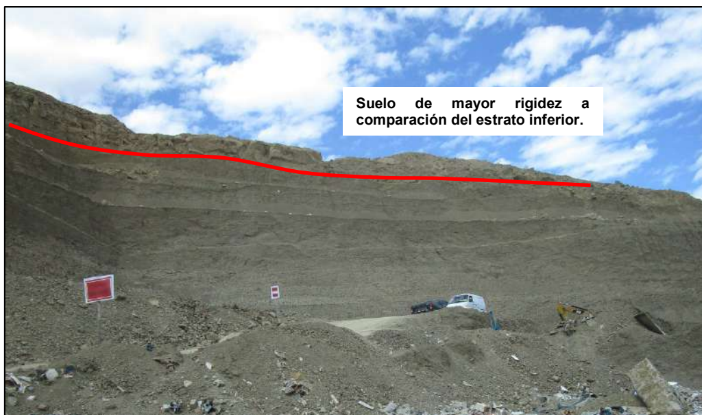
Figura 19. Secuencia litológica de un corte identificado próximo al ensayo LS05 (Sector 9, cercado).
