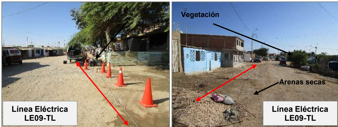
Figura21. Vista de la línea eléctrica LE05-TL, LE07-TL, LE08-TL y LE09-TL.
