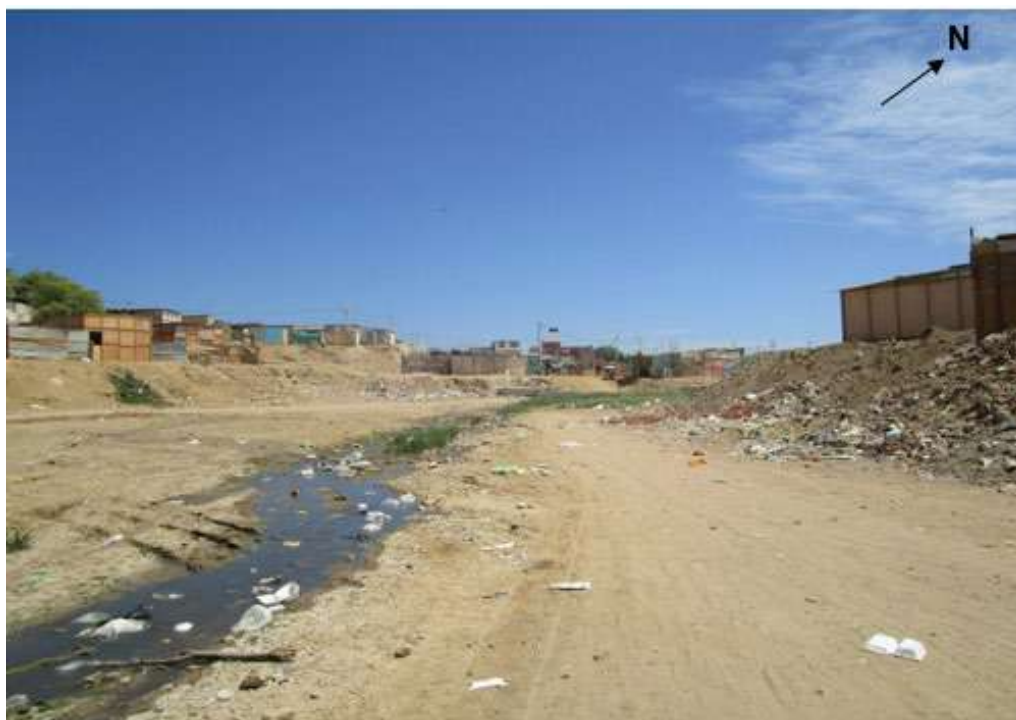
Foto 30: Colapso de red de desagüe en el AA.HH. Ampliación San Sebastián
