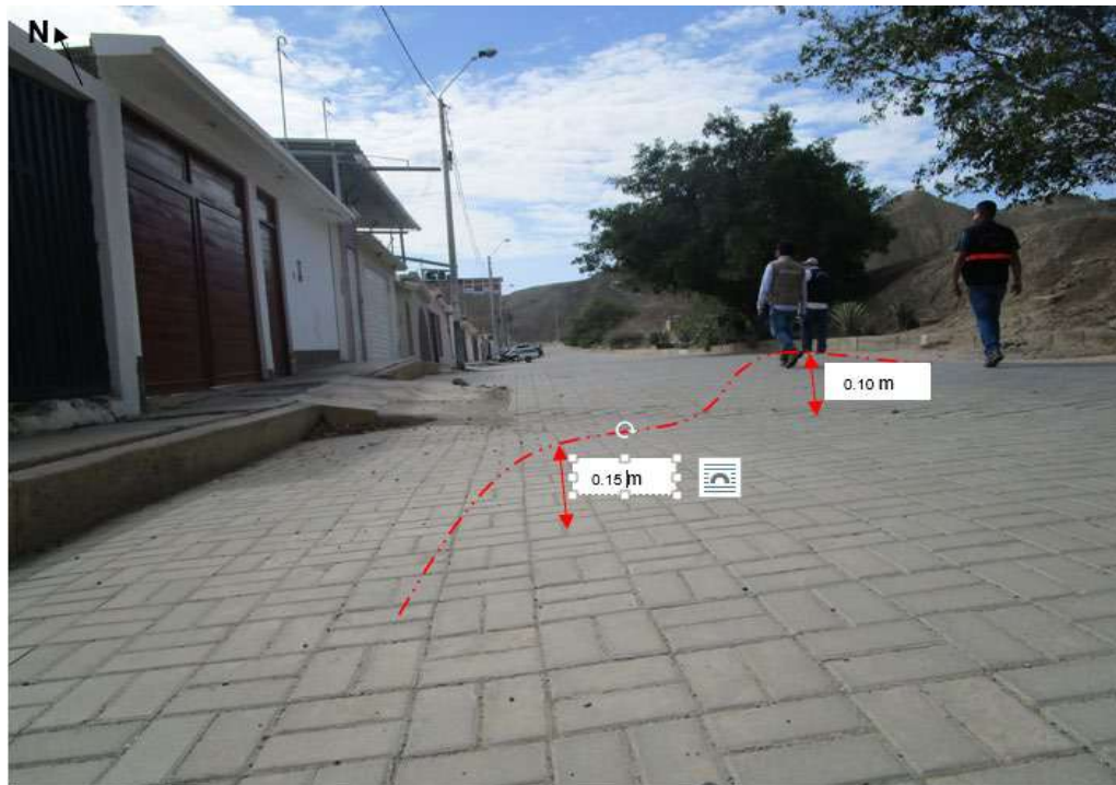
Foto 31: El adoquin de la calzada presenta ondulamientos con desniveles entre 0.10 y 0.15 m.
