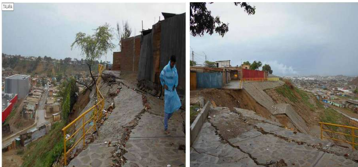
Figura 02: Infraestructura dañada, Fuente: Diario El Regional Piura
