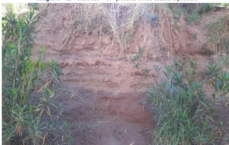
Imagen N° 12: Pendientes >37° presente en los taludes expuestos.
