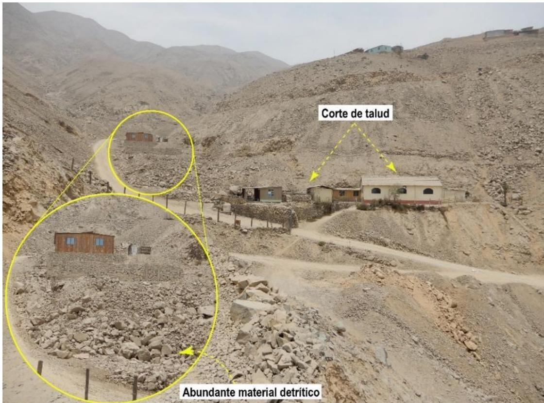
**Figura 9.** Se aprecia abundante material detrítico suelto en el cauce de la quebrada; así como cortes de talud para la construcción de nuevas viviendas en el mismo cauce.
