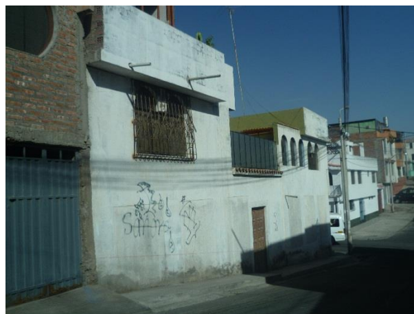
Figura 19. Edificación de albañilería con presencia de humedad del sector 04
