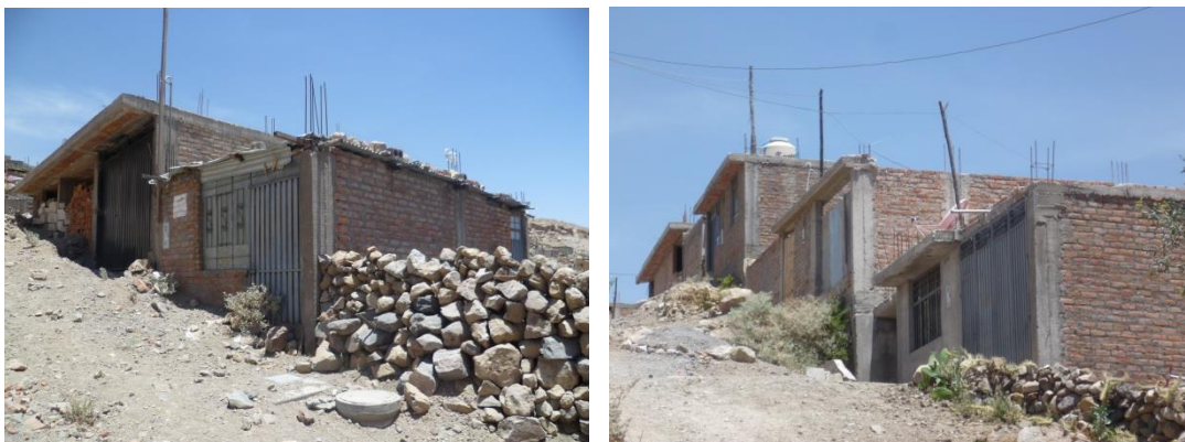
Figura 41. Viviendas de mampostería confinada sobre pendiente pronunciada
