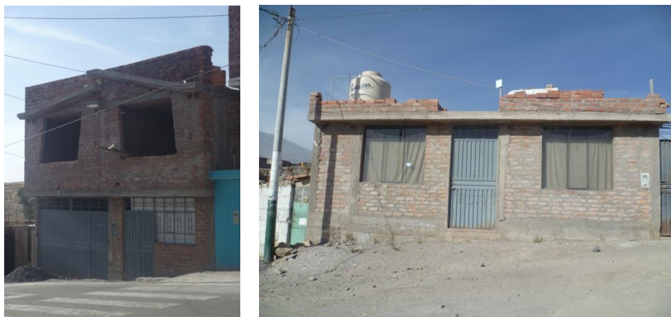
Figura 36. Edificaciones típicas del sector 11
