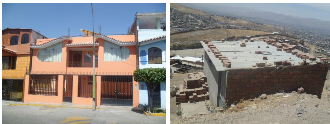
Figura 22. Viviendas de mampostería confinada con unidades de arcilla, manzana 135
