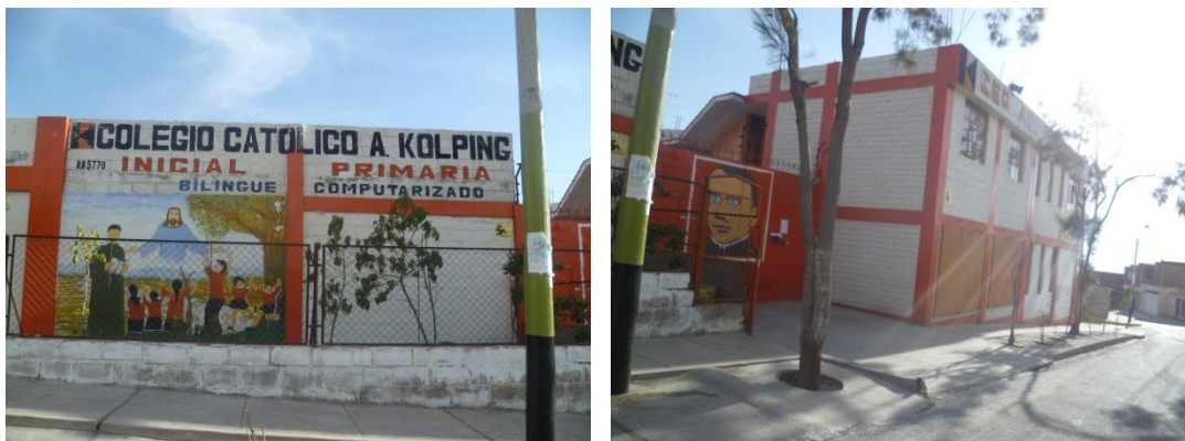
Figura 81. Colegio Católico A. Kolping, manzana 1108
