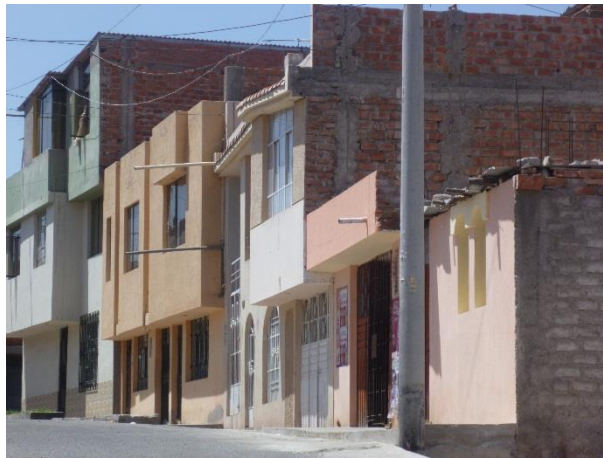
Figura 20. Edificaciones características del Sector 05
