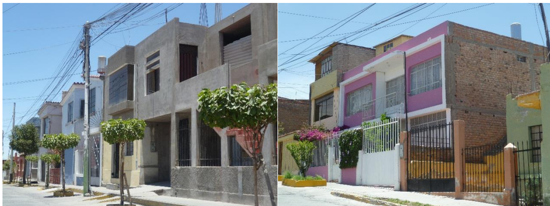
Figura 16. Edificaciones características del Sector 03
