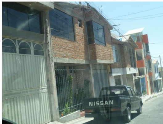
Figura 15. Edificaciones del Sector 02, de dos pisos en algunos casos sin tarrajeo.
