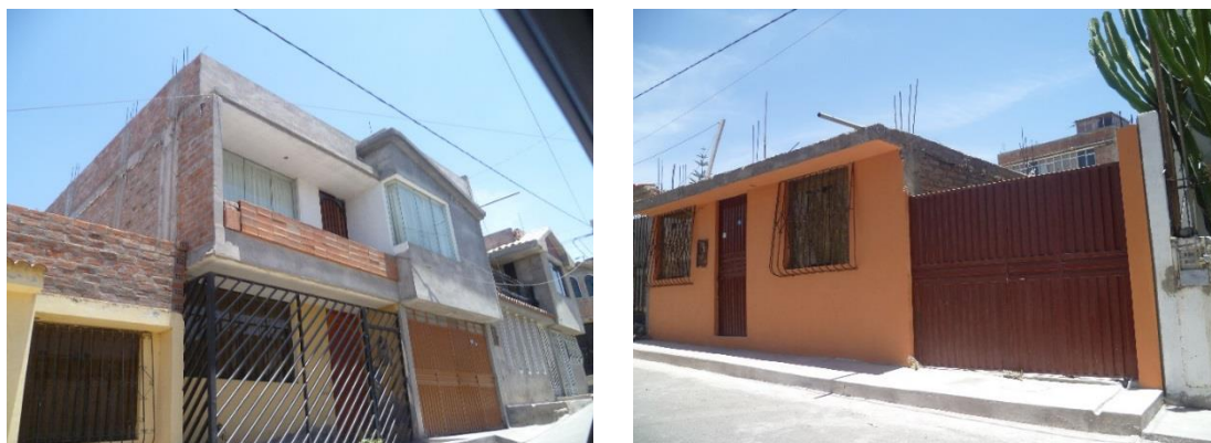
Figura 26. Viviendas típicas del Sector 07.
