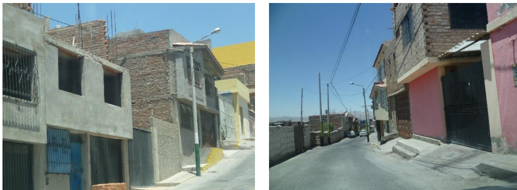
Figura 12. Viviendas típicas del Sector 01
