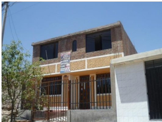
Figura 15. Edificaciones del Sector 02, de dos pisos en algunos casos sin tarrajeo.
