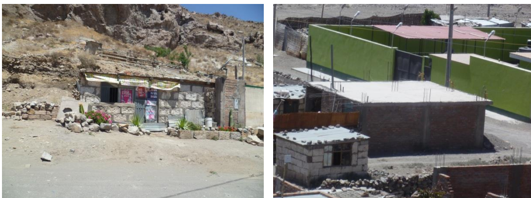
Figura 38. Edificaciones características del Sector 12
