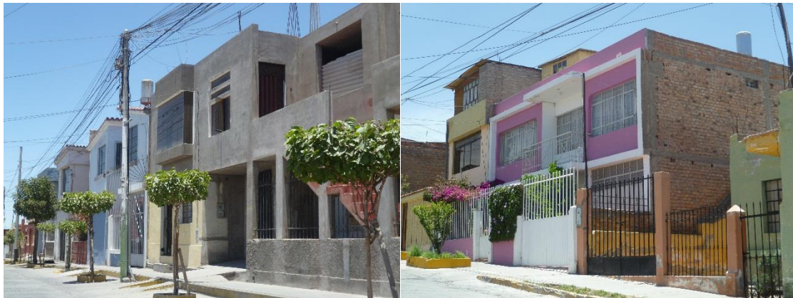
Figura 18. Edificaciones características del Sector 04
