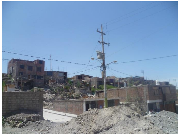
Figura 31. Viviendas ubicadas en laderas al Sureste
