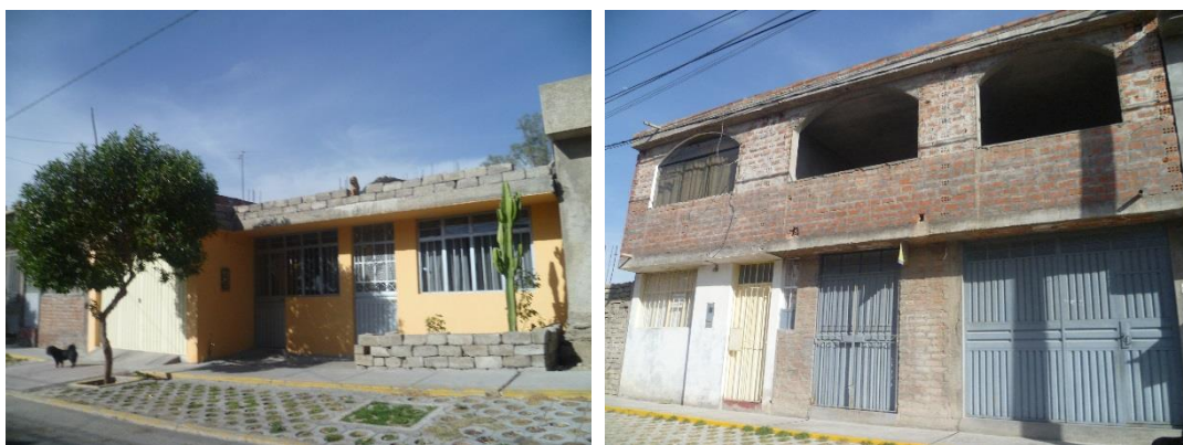
Figura 32. Edificaciones características del Sector 09
