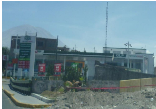
Figura 42. Vista del grifo en el Sector 01.
