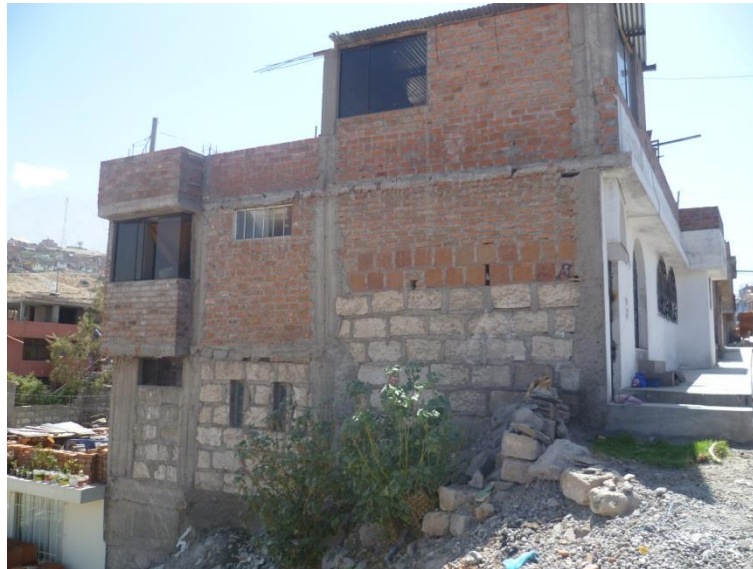
Figura 25. Vivienda con diferentes tipos de unidades de mampostería
