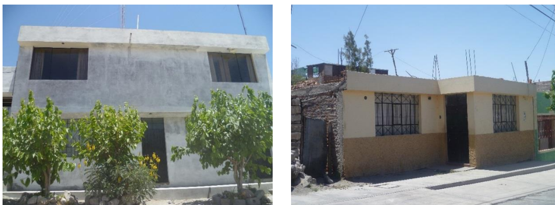
Figura 28. Edificaciones del sector 8, de dos pisos y viviendas ubicadas en ladera.
