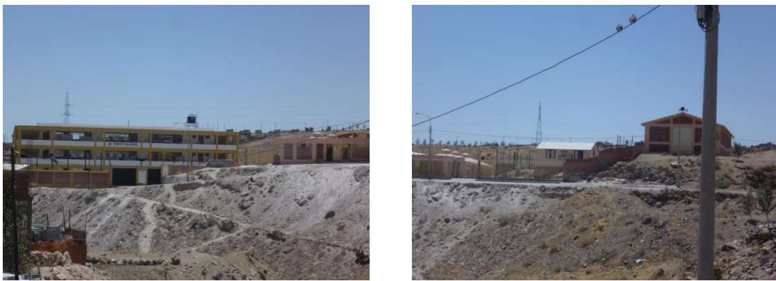
Figura 86. Edificaciones esenciales en la manzana 944 del sector 13
