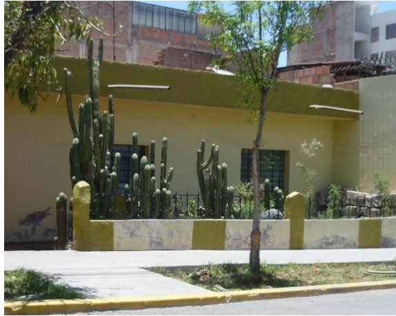
Figura 14. Vivienda con presencia de humedad del Sector 01
