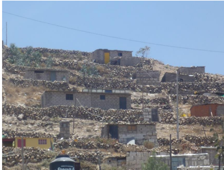
Figura 24. Viviendas con unidades de sillar en ladera de los cerros
