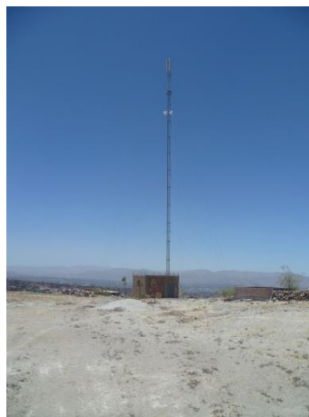
Figura 85. Antena en la manzana 975 del sector 12
