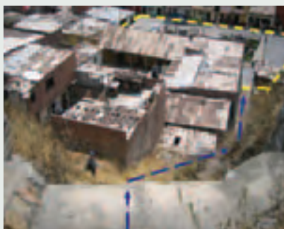
Ilustración 8. Riesgo subsistente para la población en el distrito de Matucana A pesar de la construcción de los diques en las laderas, ante el desarrollo de un huaico (identificado en azul), la Plaza de Armas de Matucana (identificada en amarillo) es altamente vulnerable, debido a que ni la municipalidad ni la población organizada cumplen con mantener descolmatados los diques, lo que ocasiona la posibilidad de inundación de la localidad, así como pérdidas humanas y daños materiales. (Vista desde la quebrada de Chihuanpunco.)
