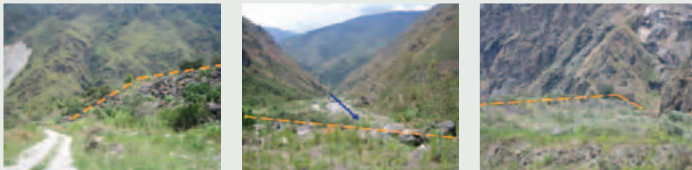
Ilustración 16. Dique de contención en el río Aobamba
