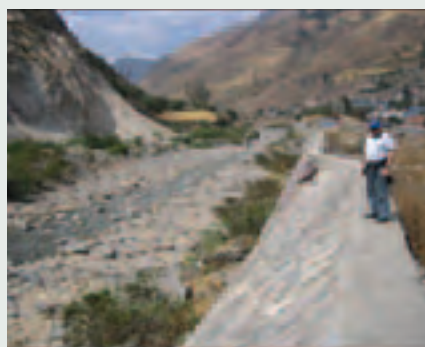
Ilustración 7. Obras de defensa de la margen izquierda del río Rímac, sector urbano de Matucana
