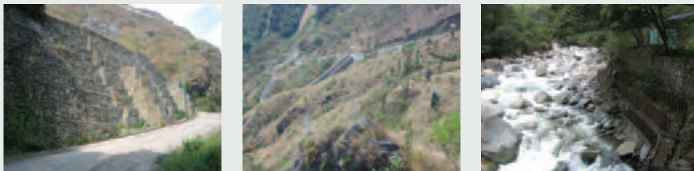
Ilustración 15. Obras de defensa en el río Aobamba
