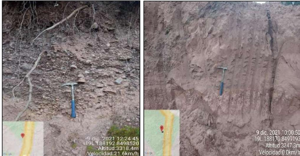
Foto 01 y 02. Gravas, arenas y limos de la formación San Sebastián en corte de talud.
