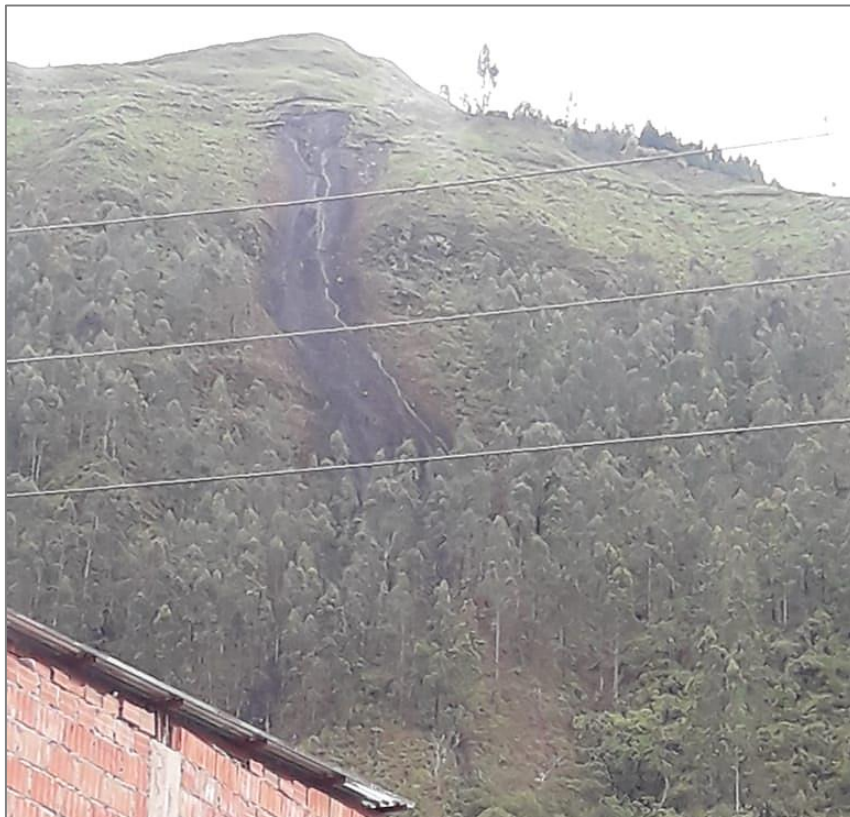
Fotografía 4. Vista de filtración de agua tipo manantial en la ladera noroeste del cerro San Valentín. Fuente: Ingemmet, 2020.
