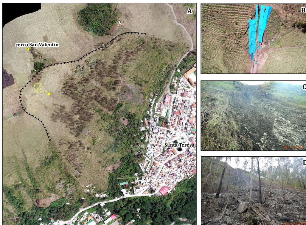
Figura 5. A) Vista al NO del poblado de Santa Teresa, se observa el mega deslizamiento antiguo demarcado con líneas negras y la reactivación con líneas de color amarillo. B) Reactivación del deslizamiento. C) Cuerpo del deslizamiento-Flujo. D) Afectación de terrenos de cultivo. Fuente: Ingemmet, 2020.
