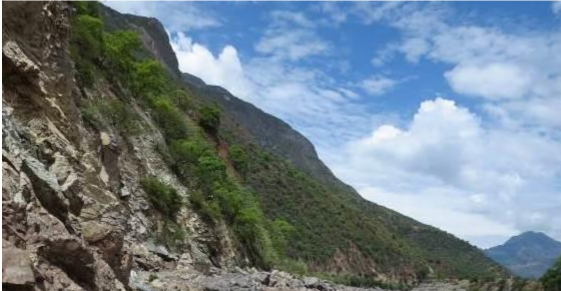
Fotografía 3 , Vista tomada con dirección noroeste, se observa ladera de montaña en roca sedimentaria que se caracteriza por tener pendiente del terreno muy fuerte ( 25^\circ a 45^\circ ), donde se generan procesos geológicos por movimientos en masa.
