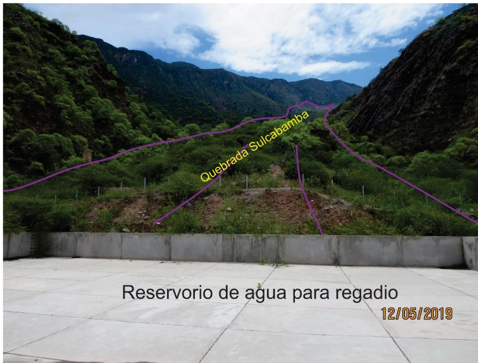
Figura 17 , Vista tomada aguas arriba de la quebrada Sulcabamba, se observa depósito de evento antiguo, y como se construye un reservorio de agua en área susceptible a la ocurrencia de procesos geológicos de tipo flujo de detritos (huaico).
