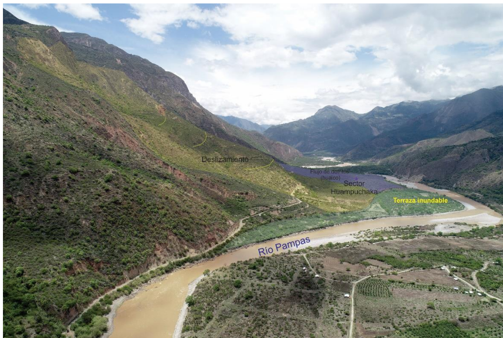
Figura 12. Vista tomada con dirección noroeste, se observa el sector Huampuchaka, es afectado por procesos geológicos de tipo: deslizamiento, flujo de detritos (huaico) e inundación fluvial
