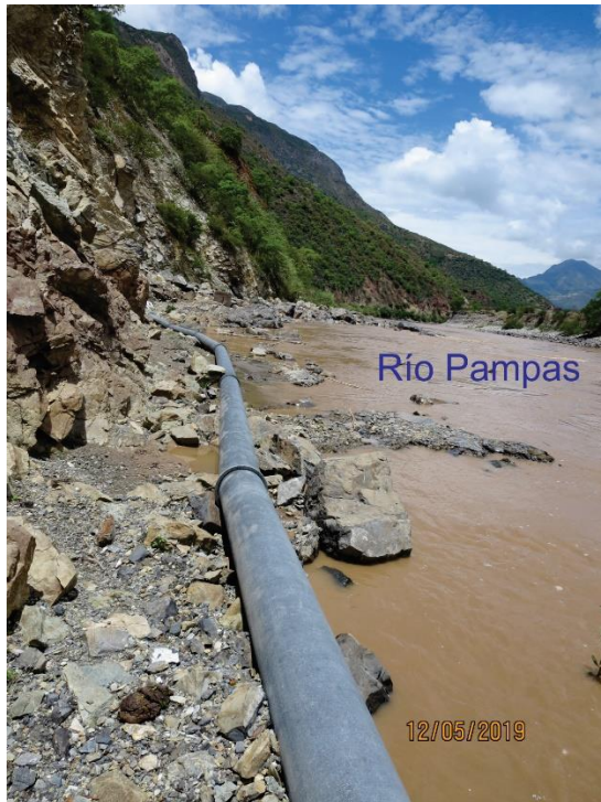
Figura 16 , vista de tuberías de conducción de agua de regadío afectado por caída de rocas.
