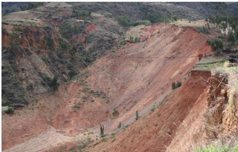
Fotografía 1: Vista lateral del deslizamiento de Allmay.
