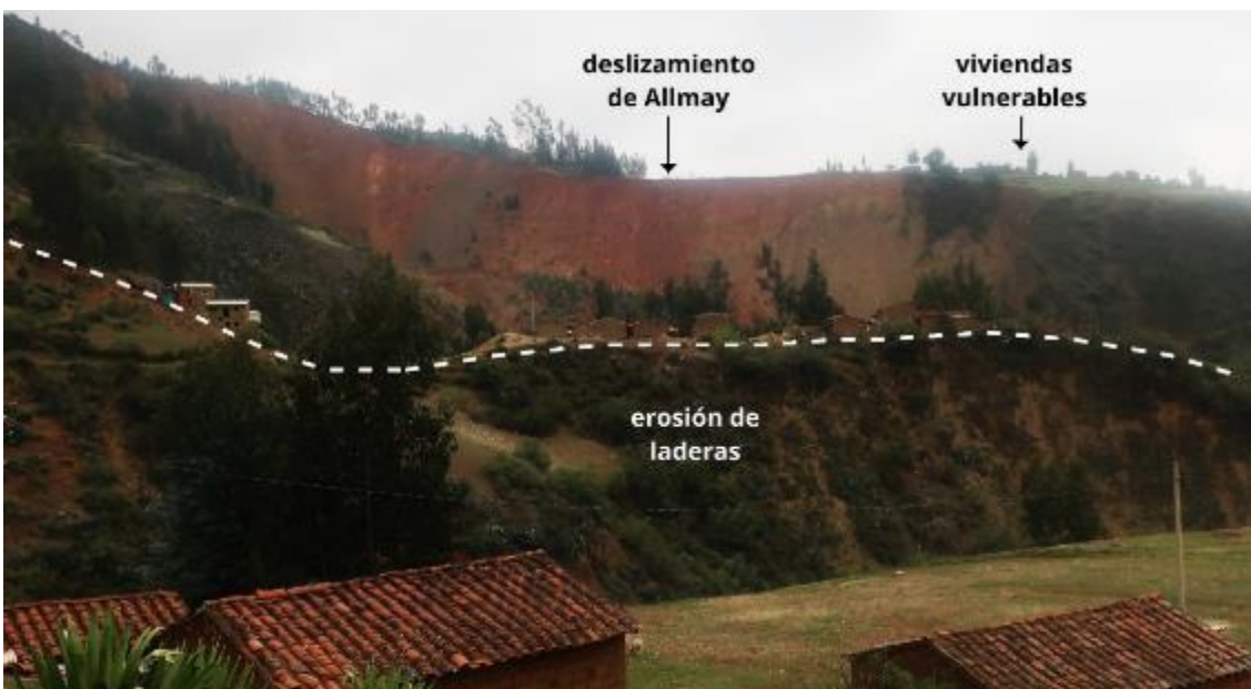
Figura 23: Se observan que la laderas situada a la margen izquierda de la quebrada Chacuasuran (delimitadas con líneas blancas) se presenta muy erosionada, frágil y muy susceptible a deslizarse, con pendientes muy escarpadas entre un rango de 45°-80°, sobre esta se asientan viviendas del sector Chillo, las cuales se encuentran muy vulnerables a sufrir daños en caso de que se genere la activación de un deslizamiento en esta ladera. Detrás se evidencia el gran deslizamiento de Allmay el cual presenta características geológicas similares y podría afectar las viviendas cercanas.
