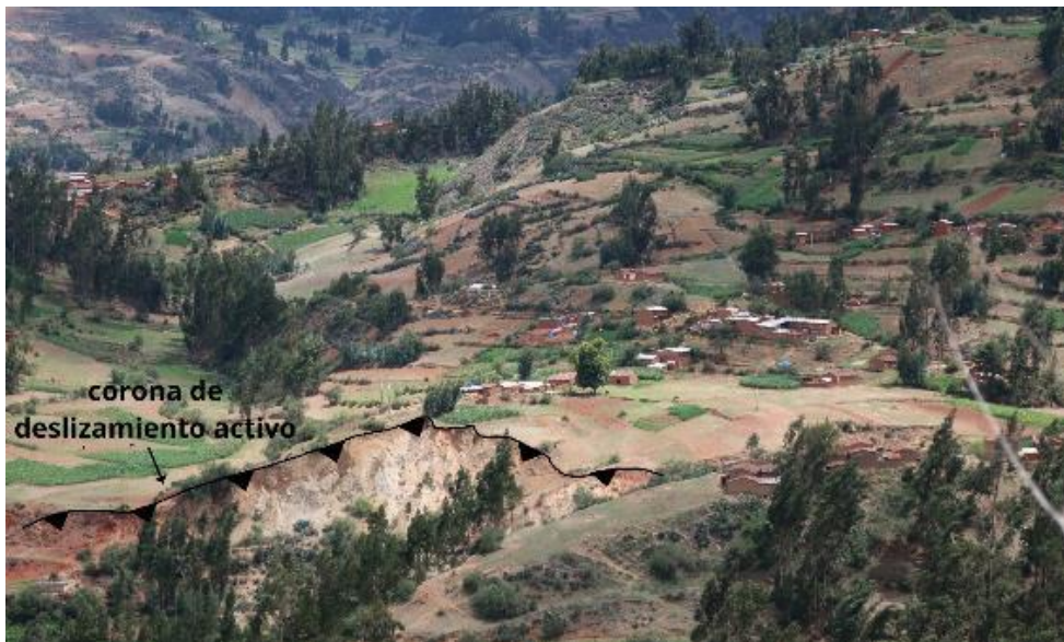
Figura 20: Se muestra la corona y cuerpo de un deslizamiento activo el cual se ha generado a 18 m de viviendas del centro poblado de Marca.
