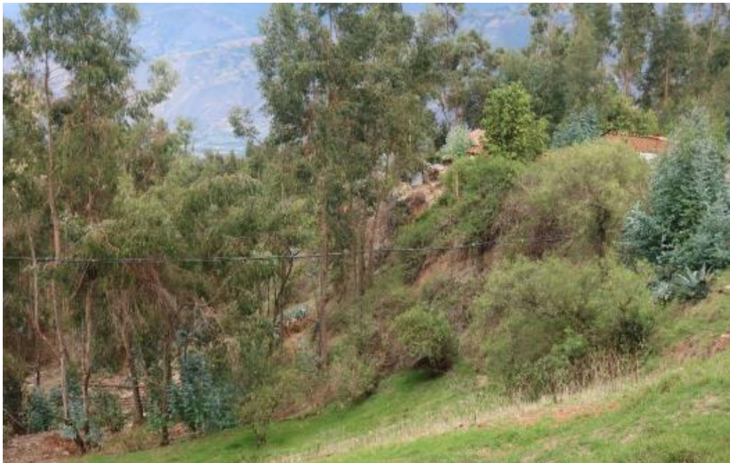
Fotografía 3: Se muestra viviendas situadas en el borde de un escarpe susceptible a deslizarse en el centro poblado de Allmay
