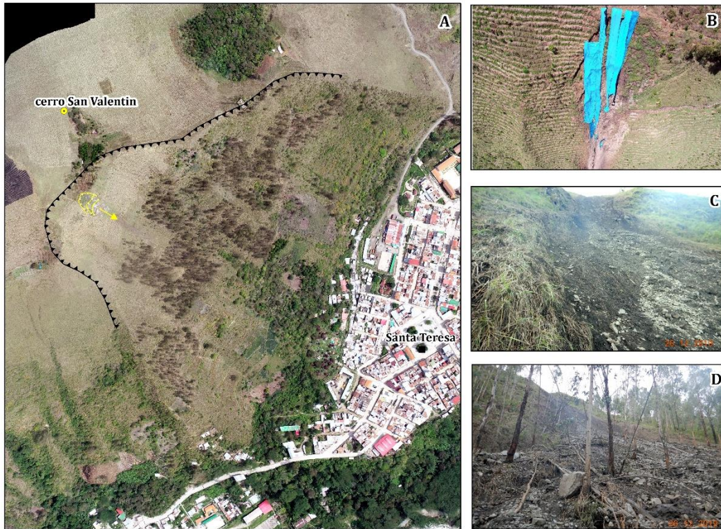
Figura 3. A) Vista al NO de la ciudad de Santa Teresa, se observa el megadeslizamiento antiguo demarcado con líneas negras y la reactivación con líneas de color amarillo. B) Reactivación del deslizamiento. C) Cuerpo del deslizamiento-Flujo. D) Afectación de terrenos de cultivo.
