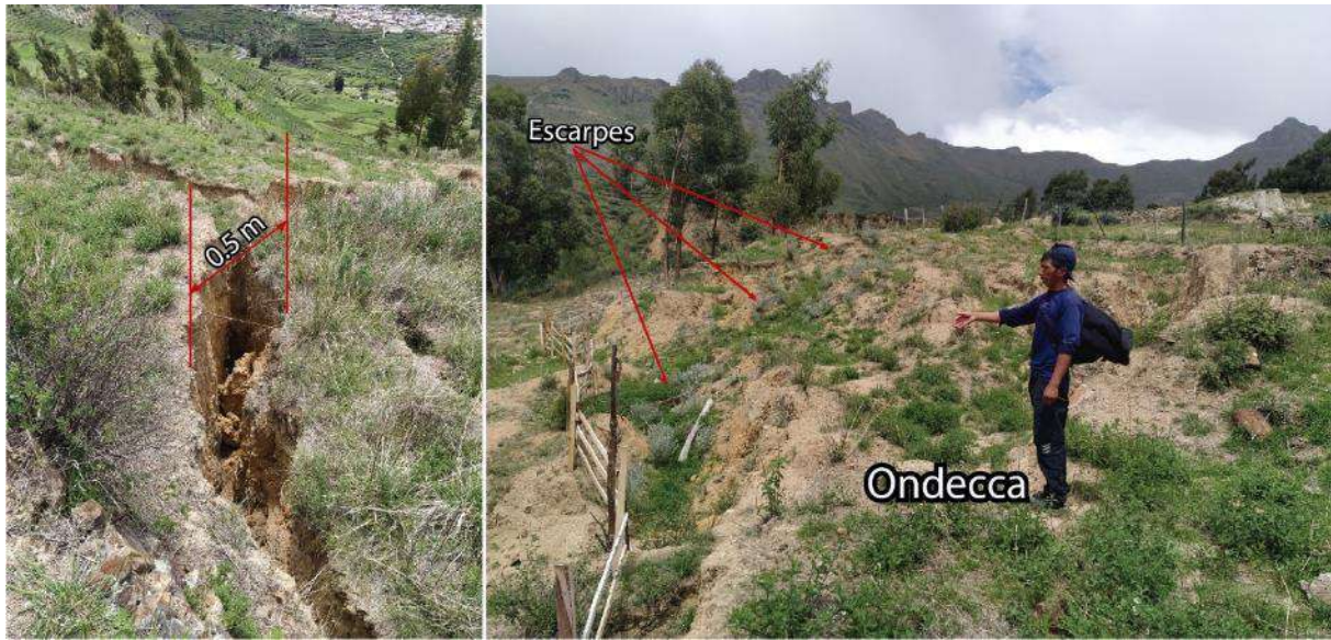
Figura 28. La imagen de la izquierda muestra grietas con aperturas de 0.5 m en el sector de Ondecca, mientras que la imagen de la derecha muestra múltiples escarpes del deslizamiento de Ondecca (Coordenadas UTM WGS 84, 18S, X: 613197.10 m; Y: 8408973.09 m).
