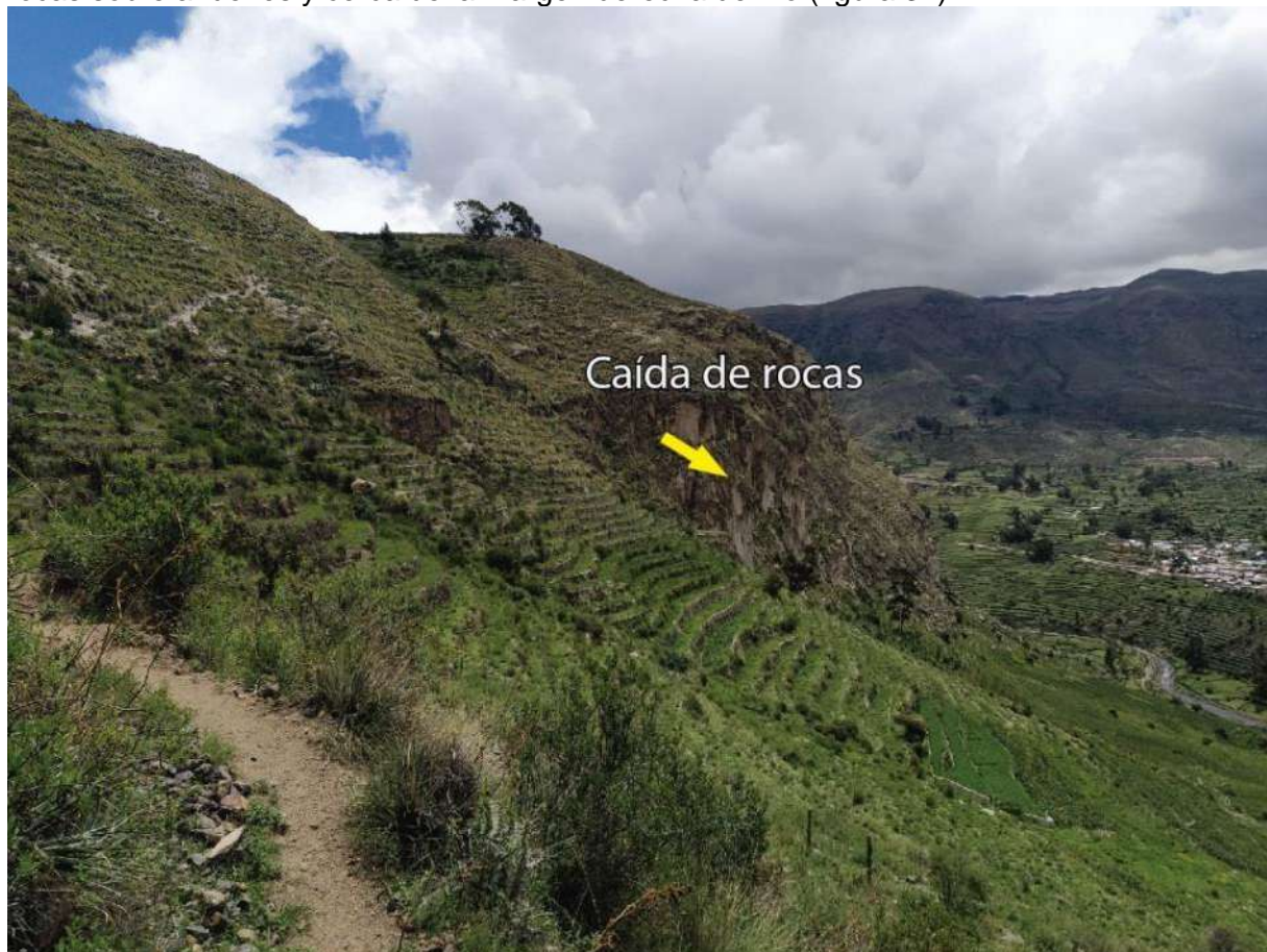
Figura 31. Caída de rocas en la ladera sur, sobre el depósito de deslizamiento de Jeyrucha Chimpa.
