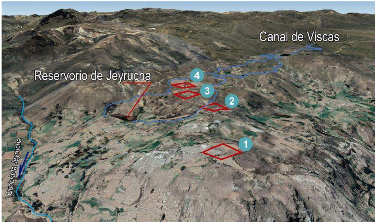
Figura 41. Ubicación de los polígonos posibles para la construcción de un nuevo reservorio de tierra, para el sector de Jeyrucha
