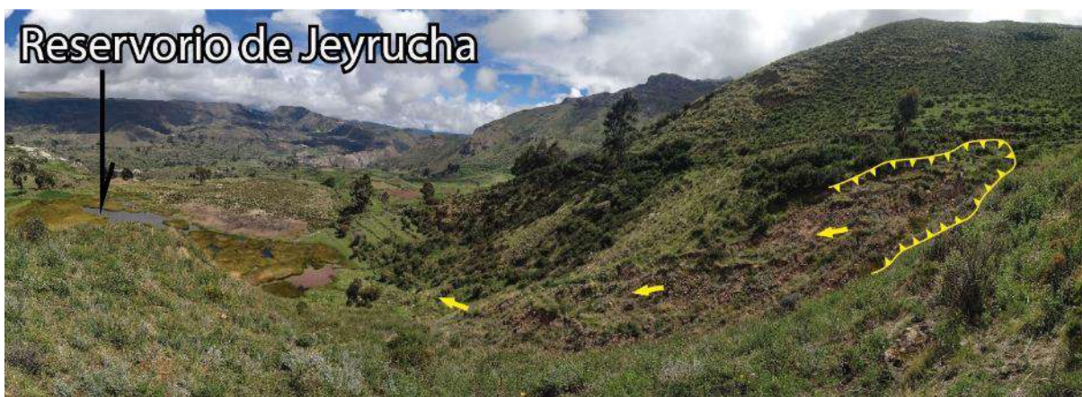
Figura 32. Deslizamiento rotacional ubicado al NE, del reservorio de Jeyrucha.
