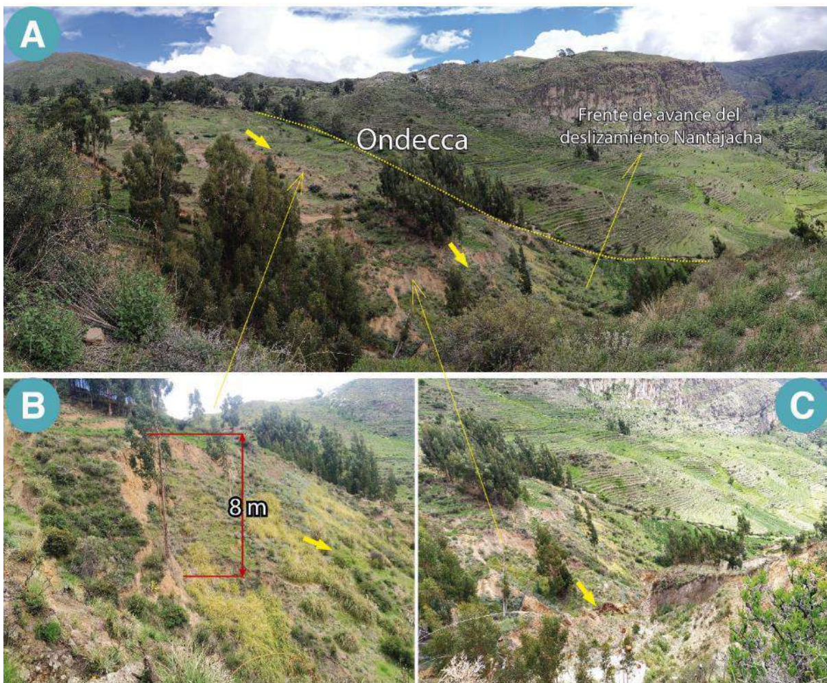
Figura 29. A) muestra el deslizamiento de Ondecca, B) muestra el escarpe de 8 m de deslizamiento y C) muestra escarpes secundarios en dirección a la quebrada Jeyrucha.
