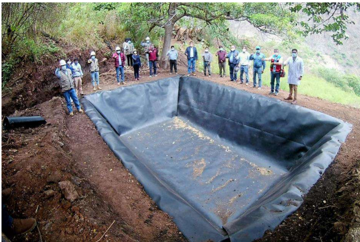
Fotografía 1. Modelo de reservorio impermeabilizado con geomembranas.
