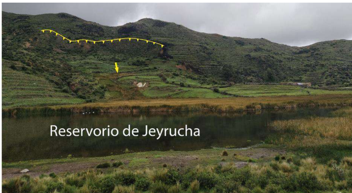
Figura 33. Deslizamientos rotacionales ubicados al Este del reservorio de Jeyrucha.
