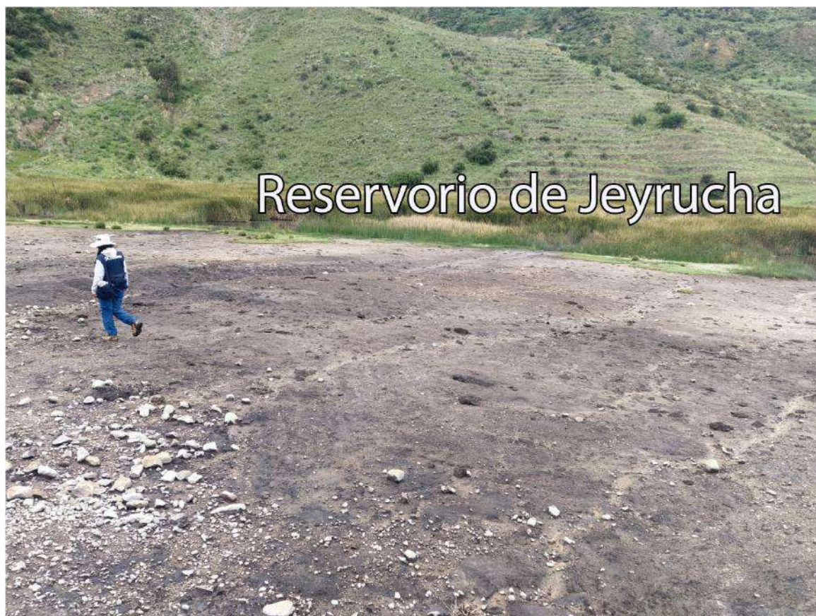
Figura 35. Grietas alrededor del reservorio de Jeyrucha.
