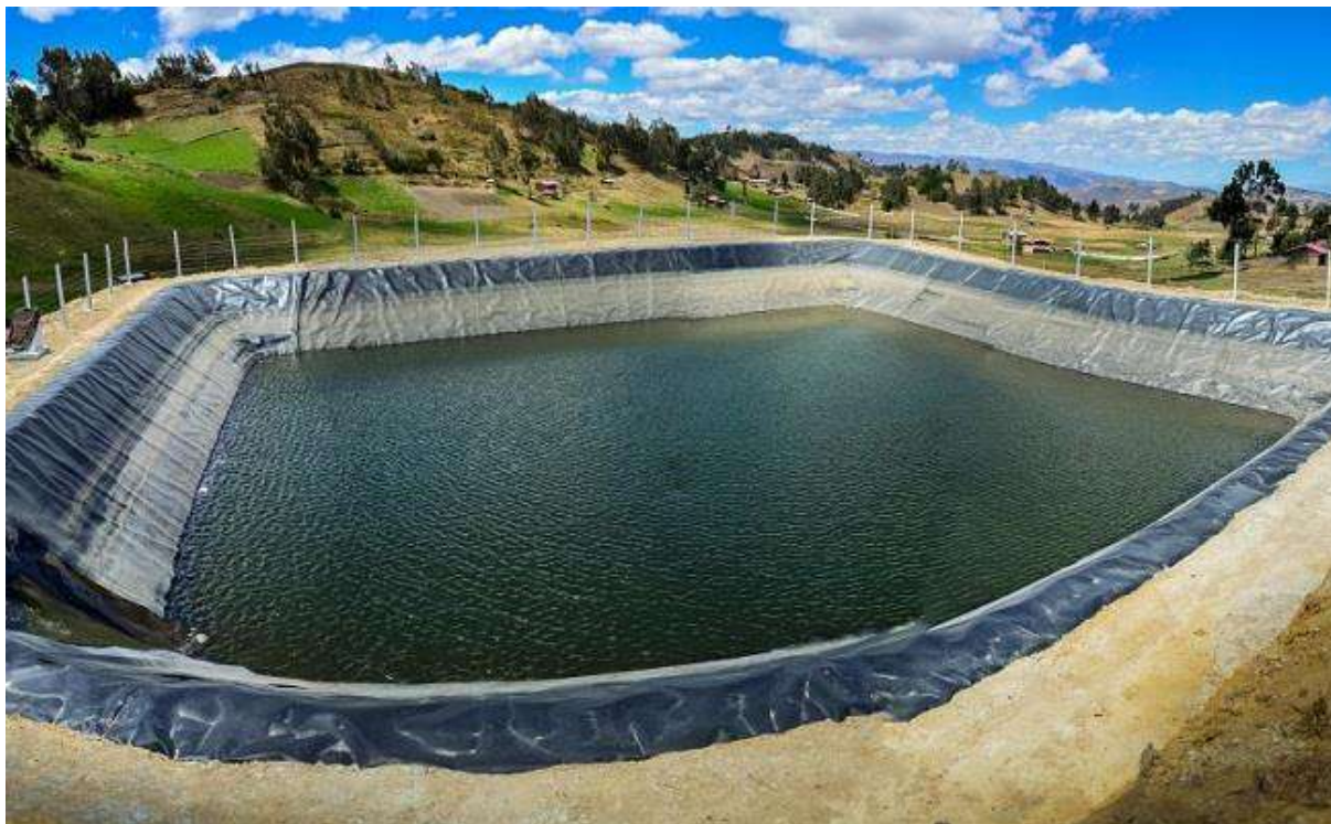
Fotografía 2. Modelo de reservorio impermeabilizado con geomembranas, en funcionamiento.
