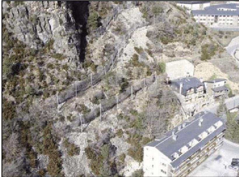
**Figura 27.** Ejemplo de mallas dinámicas para caída de rocas.
