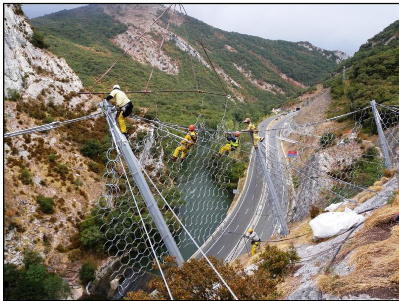
**Figura 28.** Ejemplo de mallas dinámicas para caída de rocas.
