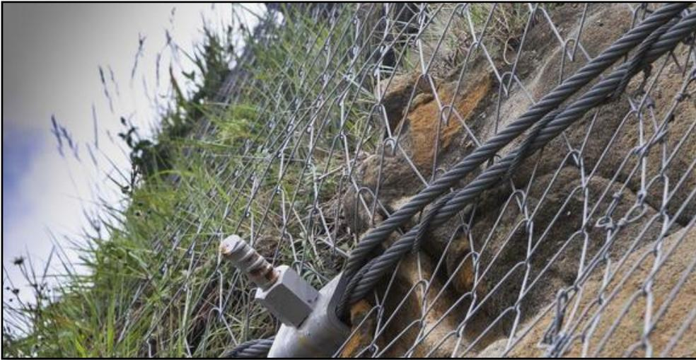
**Figura 26.** Ejemplo de control de caída de rocas utilizando mallas ancladas.
