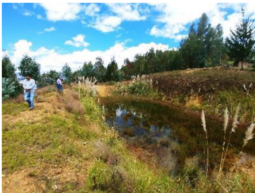
Foto 18: Reservorio sin revestimiento, sobre el área deslizada.
