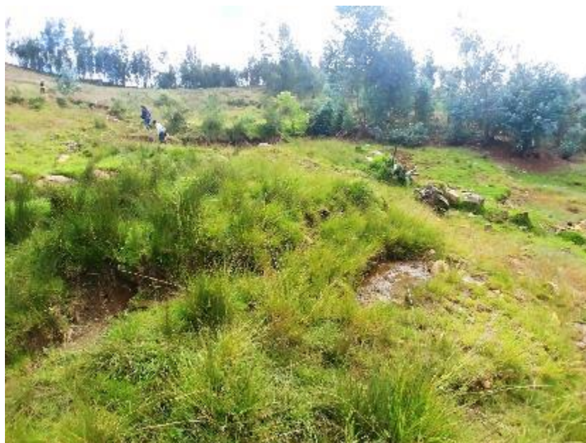
Foto 20: Surgencia de agua, nos indica saturación del terreno.
