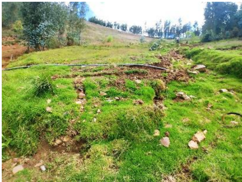
Foto 15: Grietas en la parte baja del cuerpo del deslizamiento.
