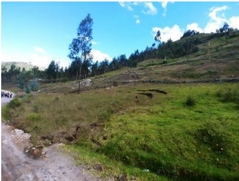
Foto 5: Agrietamientos afectan la trocha carrozable.
