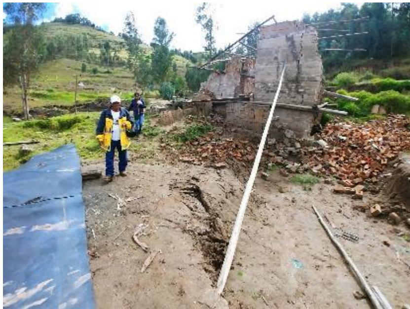
Foto 11: Zona de cabalgamiento debido a la subpresión de un suelo sobre saturado y por cambio brusco de pendiente de mayor a menor grado.
