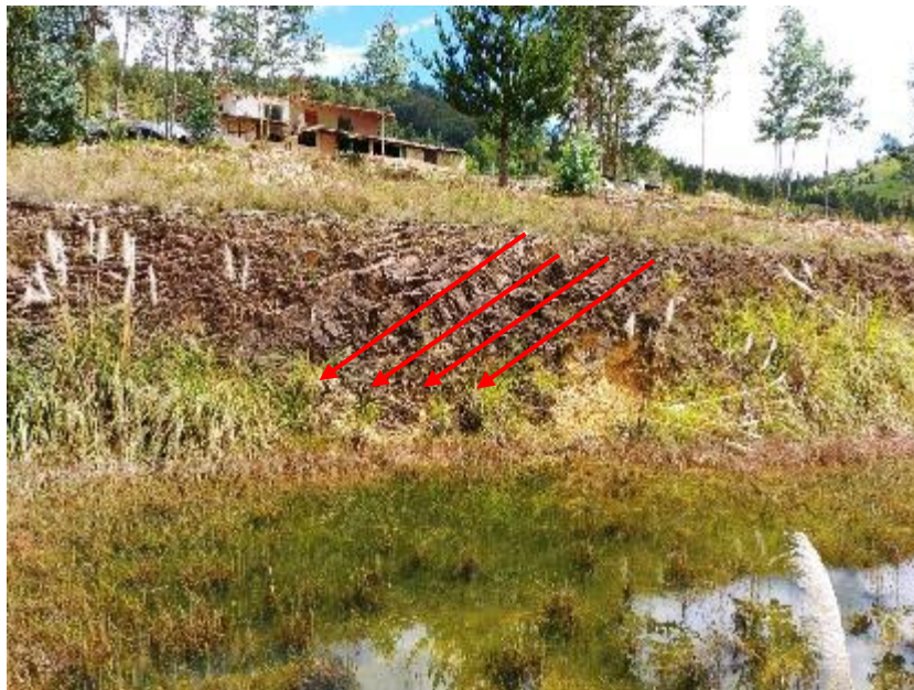
Foto 19: Orientación de los estratos hacia el cuerpo del deslizamiento.
