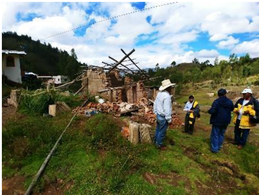
Foto 8: Destrucción de un horno debido al proceso de movimiento de masa.
