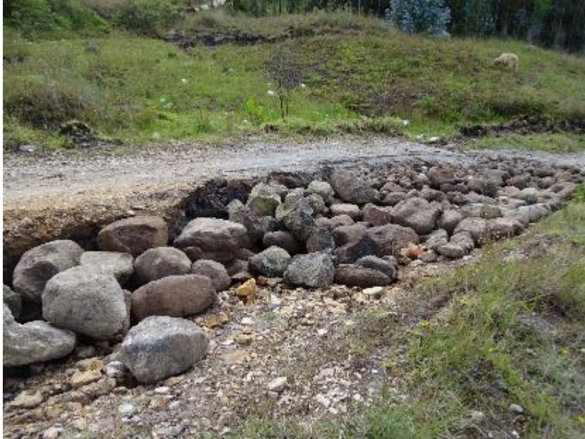
Foto 14: Escarpas en la zona de acceso a la ladrillera ha sido rellena con bloques rocosos.
