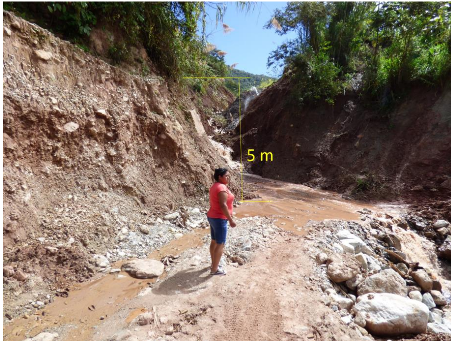
Figura 9: Muestra la quebrada Pucayacu, presenta la profundización de la quebrada por el flujo de detritos en la intersección con la vía que quedó intransitable.
