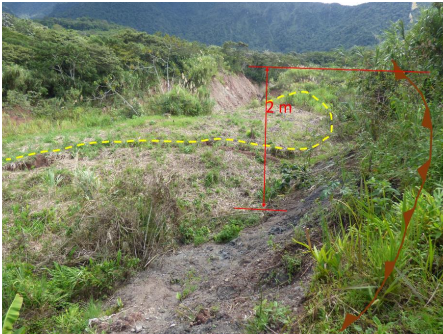
Figura 11: Margen izquierda de la quebrada Pucayacu, se aprecia escarpa secundaria con 2 m de salto y con grieta tensional.
