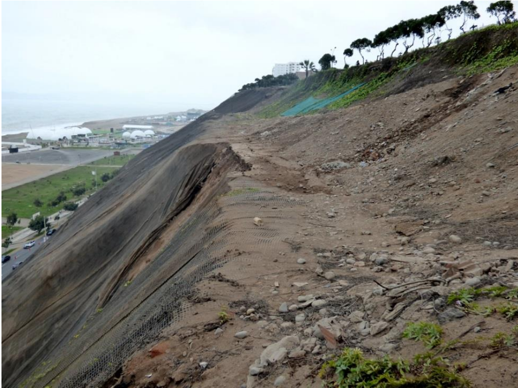
Fotografía 7.2: Vistas con dirección hacia el noroeste donde se puede ver la zona de arranque del derrumbe.
