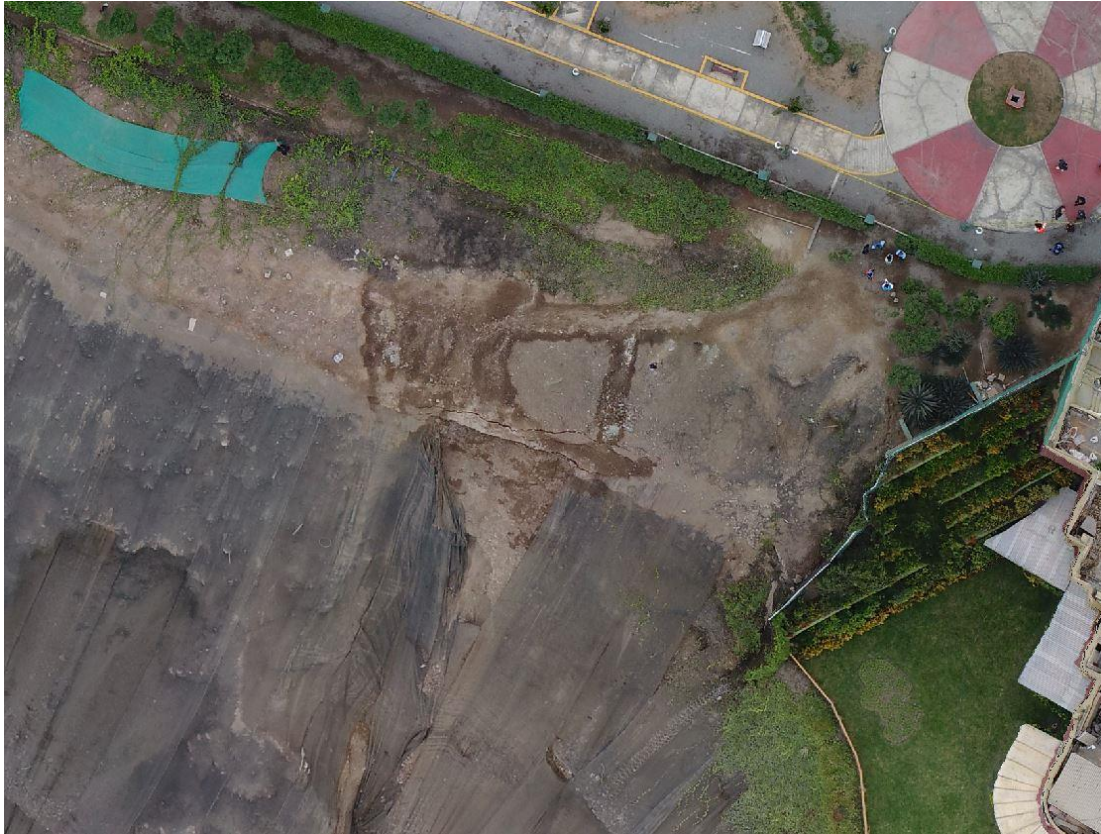
Fotografía 7.7: Ortofoto donde se puede ver las huellas de la escorrentía de agua con dirección hacia la zona derrumbada.
