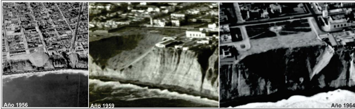
Figura 7.6: Imágenes antiguas donde es posible observar la secuencia de relleno de la hondonada que existía en el acantilado de la Costa Verde, sector malecón Castagnola. (Fuente: Archivos de Arquitecto Raúl Goyzueta – Historia Urbana de Magdalena del Mar).
