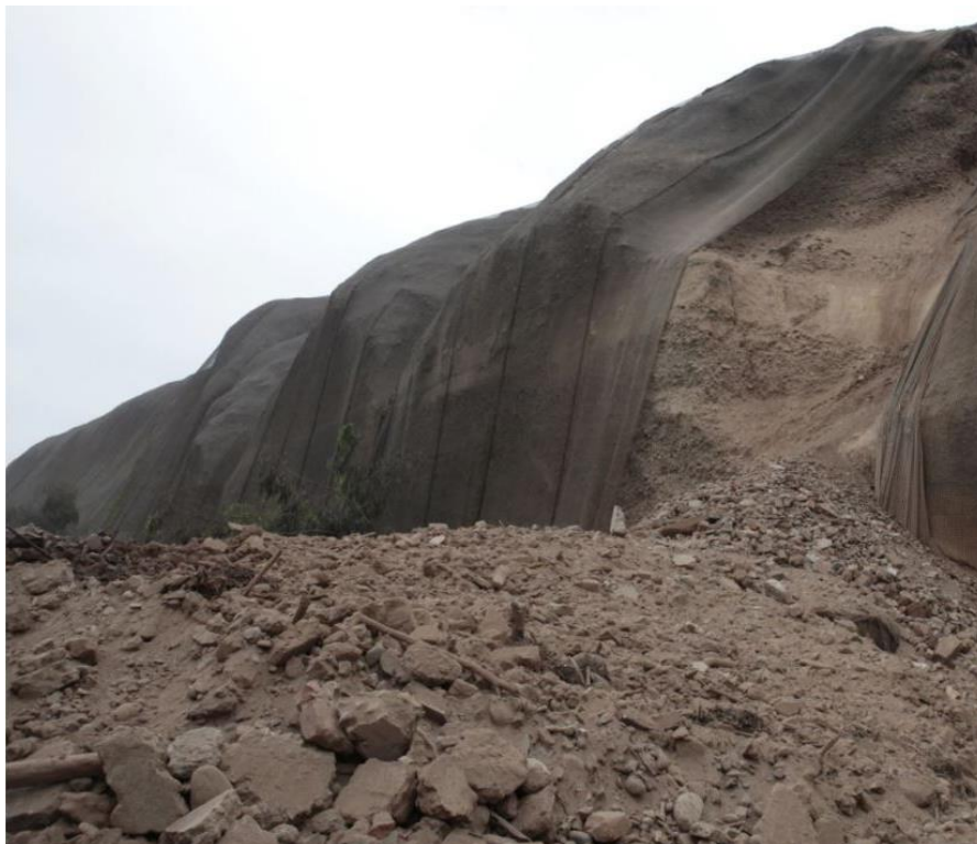
Fotografía 7.5: Imagen en la que se puede ver el depósito del derrumbe, conformado por material fino (limo y arena), bloques de concreto y ladrillos de construcción, así como restos de plantas (Fuente: Andina).
