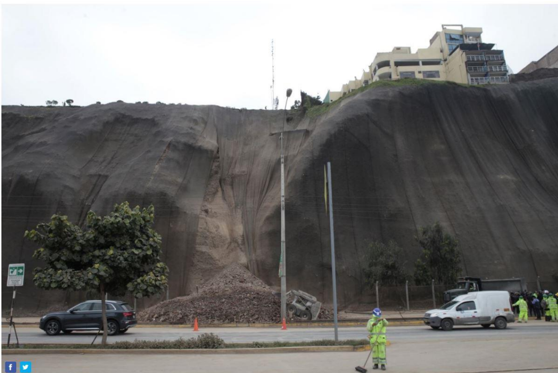
Fotografía 7.3: Imagen donde es posible ver el material acumulado en la vía Circuito de Playas de la Costa Verde a consecuencia del derrumbe arrancado en la parte alta del acantilado, donde todavía no se produce la caída de la geomalla que lo cubre. (Fuente: Andina)
