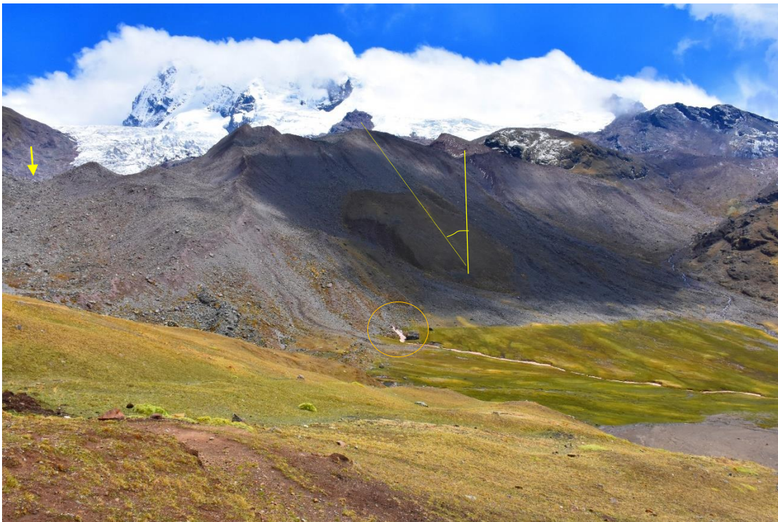
Figura 4. Se observa el conjunto de la morrena que contiene depósitos glaciáricos y a la vez forma el dique natural que almacena agua de la laguna Yawarqocha. Además, se observa los taludes exteriores con alto porcentaje de cobertura vegetal, indicador de relativa estabilidad. En flecha amarilla se muestra la cota más baja de coronación en el dique natural respecto al espejo de agua de la laguna. En círculo se observa el punto principal de desagüe (INAIGEM/ O. Vilca, 03/11/2020).
