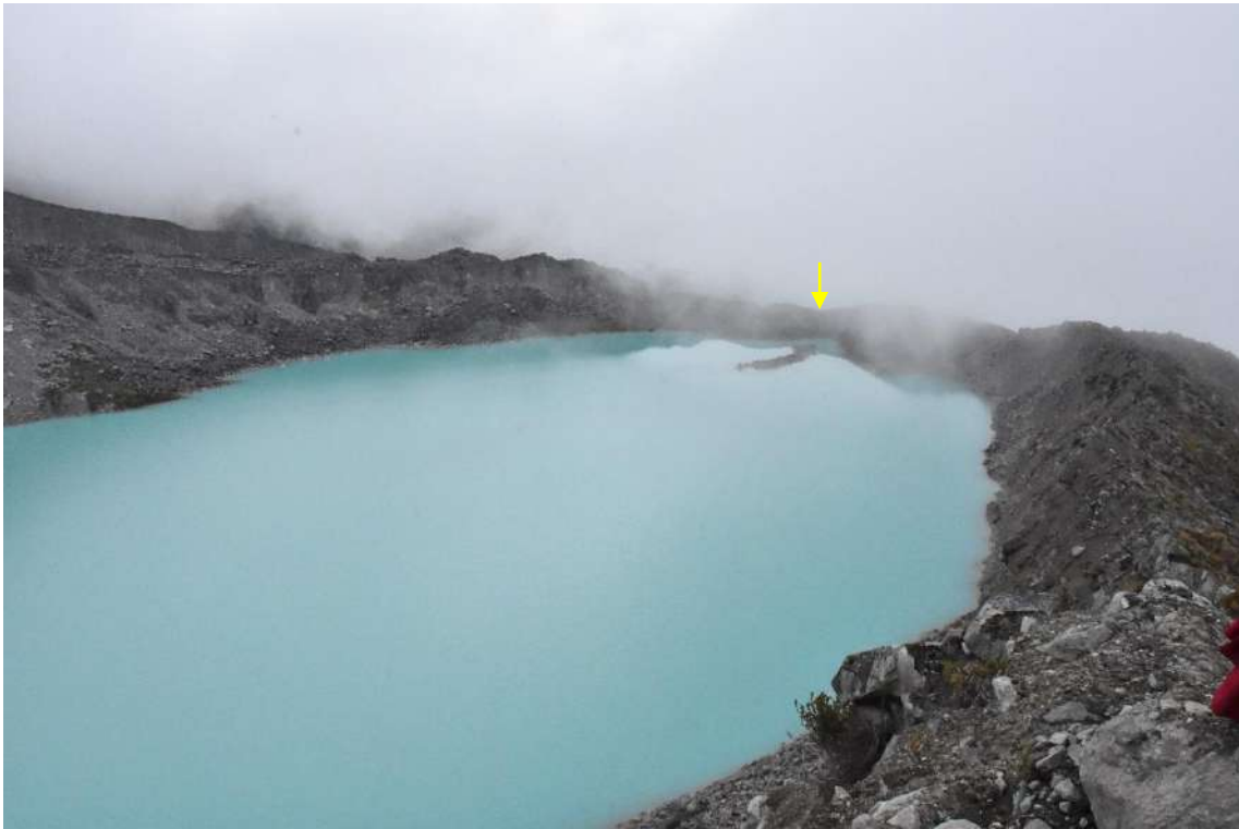
Figura 8. Zona frontal del dique natural, se observa el pequeño islote cercano a la cota de coronación (INAIGEM/ O. Vilca, 20/10/2020)
