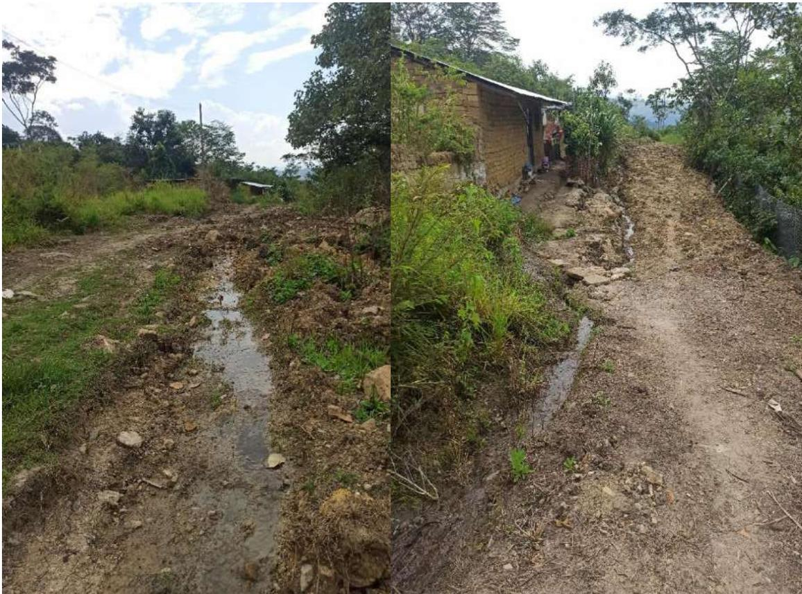
Fotografía 07. Sistema de drenaje precario, incrementa la infiltración y saturación del terreno en la parte alta del centro poblado de Jamalca.
