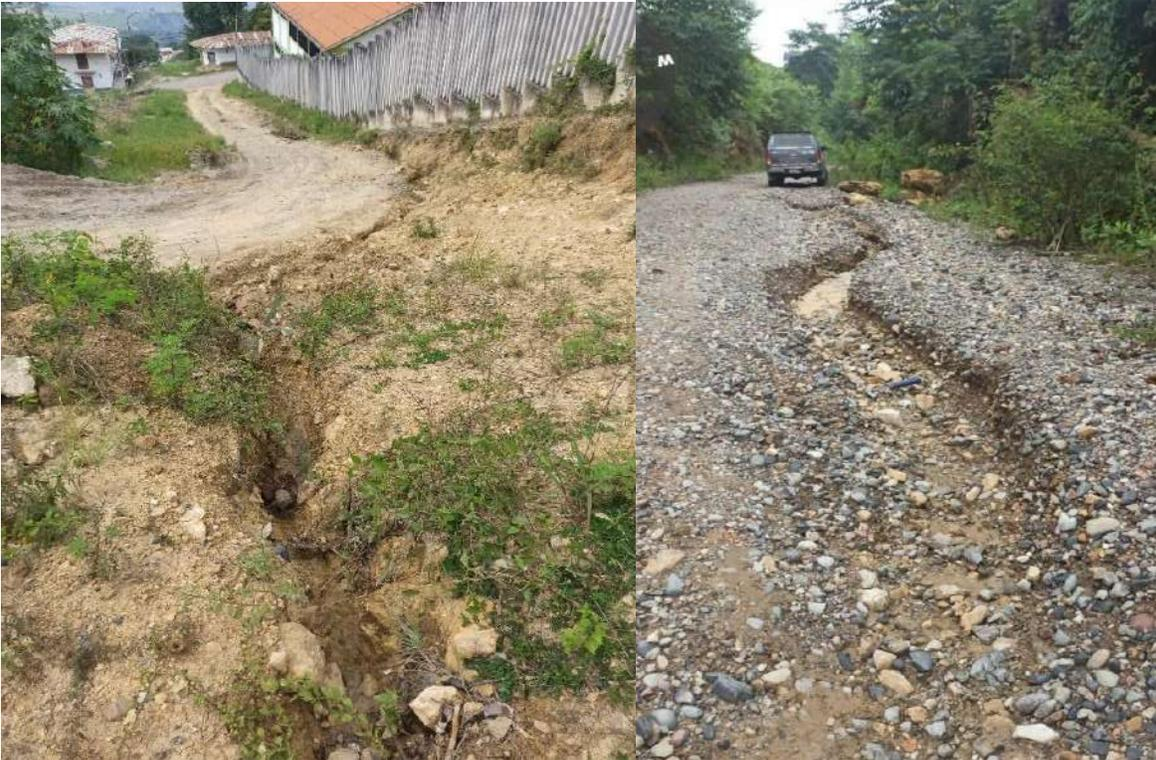
Fotografía 08. Canales naturales por erosión, debido a la falta de un sistema de drenaje.
