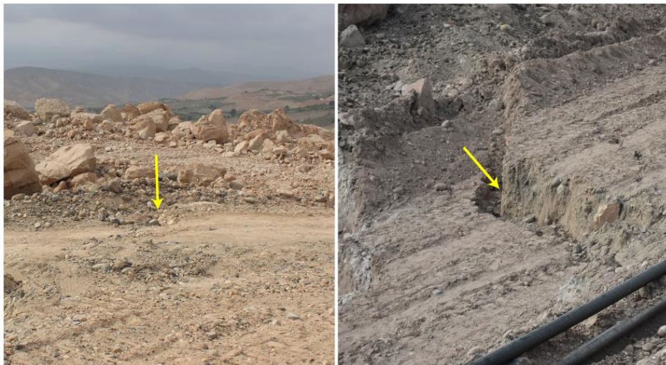
Figura 5. Agrietamientos sobre la masa desplazada del deslizamiento.
