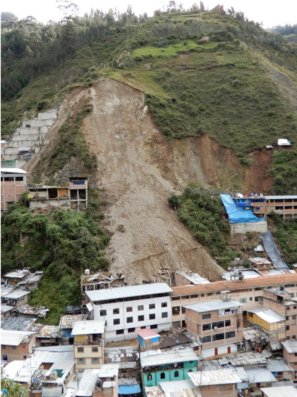
Fotografía 1. Vista panorámica del derrumbe que ocurrió el 15 de marzo del presente en el centro poblado de Retamas.
