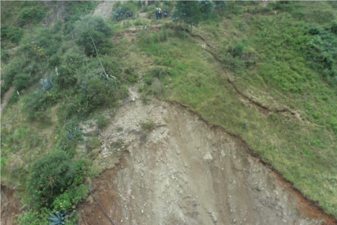
Fotografía 7. Vista panorámica de la grieta ubicada en el inmediato superior a la zona de arranque del derrumbe.
