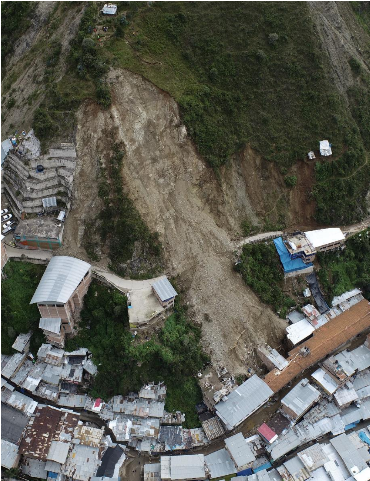
Fotografía 4- Vista panorámica del derrumbe donde se muestra la zona de arranque del derrumbe y el depósito tipo canchal.
