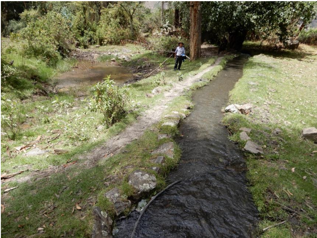
Fotografía 13. Canales de riego sin revestimiento en el cuerpo del deslizamiento de Lacsacocho
