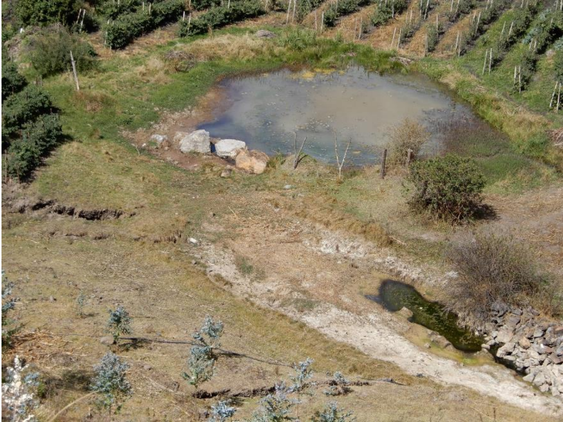
Fotografía 8. Ejemplo de oconales presente en el cuerpo del deslizamiento.
