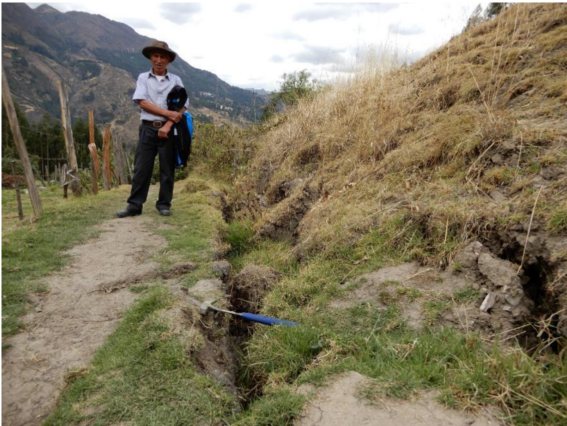
Fotografía 9. Grieta paralelo al eje del deslizamiento.
