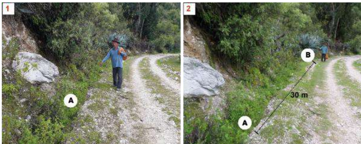
Figura 25. 1) Muestra el punto (A) lugar donde inicia la infiltración del agua que discurre por el canal de regadío no impermeabilizado. 2) Se muestra la distancia entre los puntos (A y B) trayecto en el cual ocurre infiltración del agua (se pierde gran cantidad de agua) que discurre por el canal de regadío, el cual es usado también como cuneta. Ubicado en el sector Pacha Tuna con coordenadas UTM (WGS 84): 602355.60 E; 8484631.84 S.
