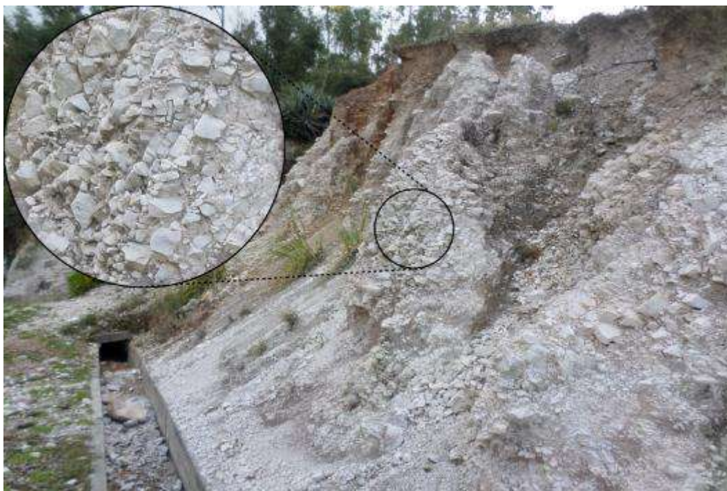
Figura 7. Afloramiento de roca intrusiva aplita muy fracturada y meteorizada.
