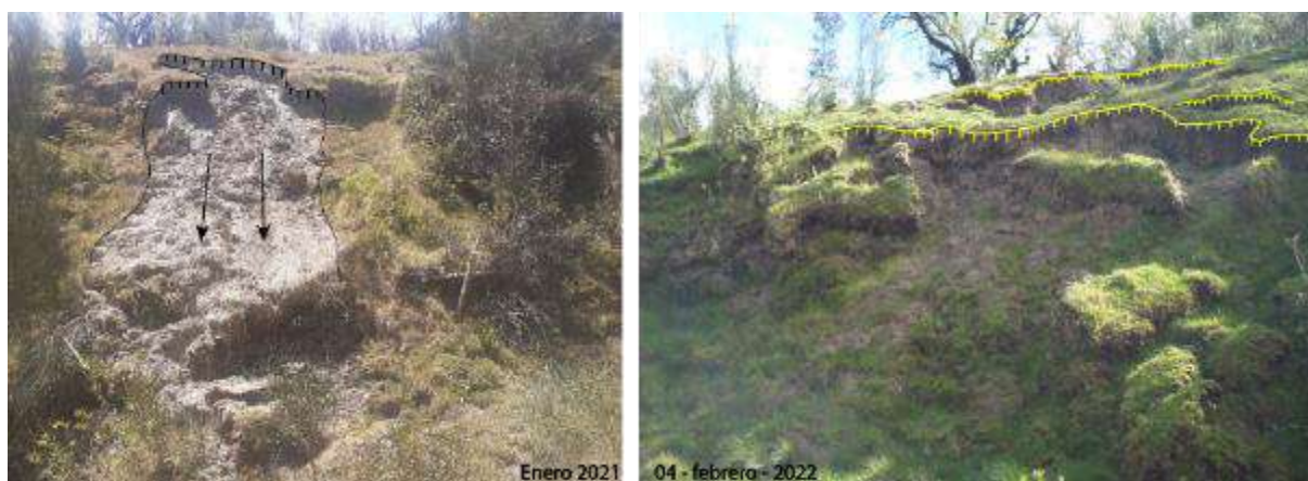
Figura 14. En la imagen de la izquierda se muestra un derrumbe que ocurrió en enero del 2021 y en la imagen de la derecha se muestra procesos de reptación de suelos (febrero 2022).
