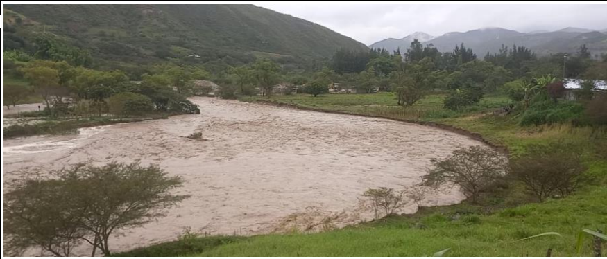
En la columna de fotografía se observa primero: Margen izquierda del Tramo del río erosionado y con vegetación, donde se propone defensa ribereña con material descolmatado y enrocado; .
