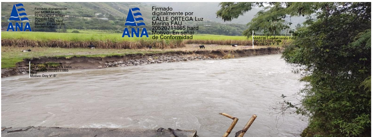
Erosión y daños causados al río Chancay
