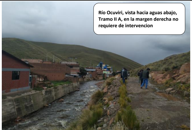
Río Ocuvi, vista hacia aguas abajo, Tramo II A, existe muro deteriorado en la margen izquierda también viviendas
