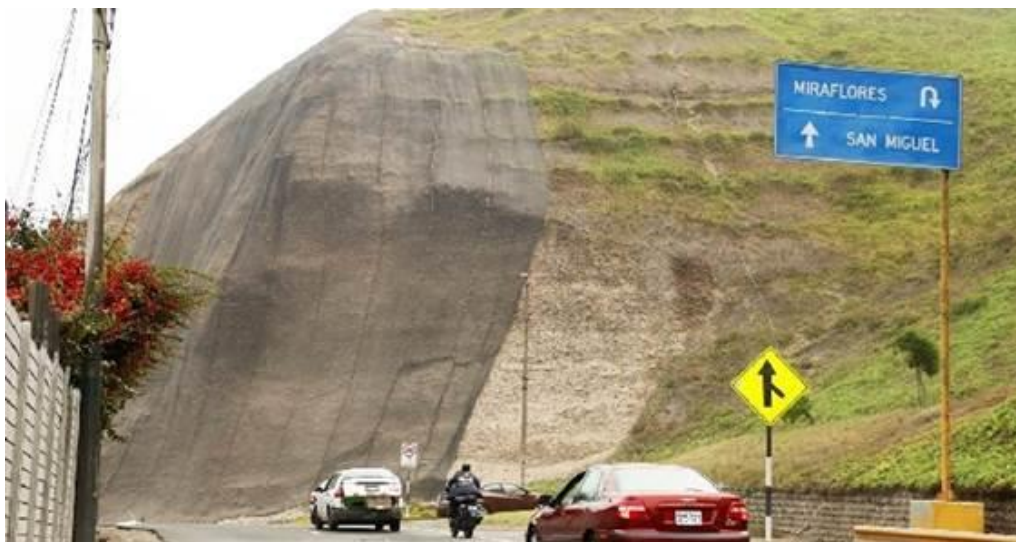
Fotografía 1. Combinación de geomallas y vegetación en los acantilados de la Costa Verde (Lima).
