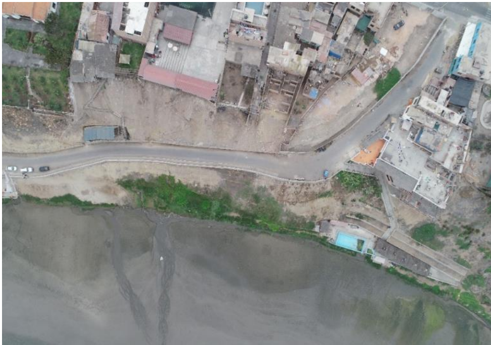
Fotografía 4. Viviendas y carretera que podrían ser afectadas por derrumbes.
