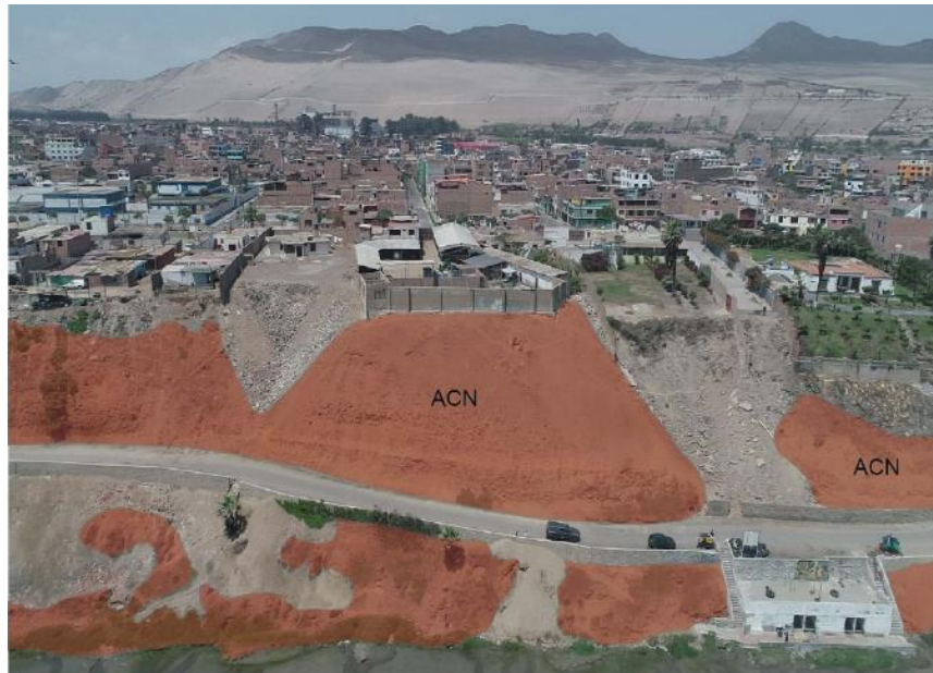
Figura 7. Subunidad acantilado ubicado en el distrito de Chancay.
