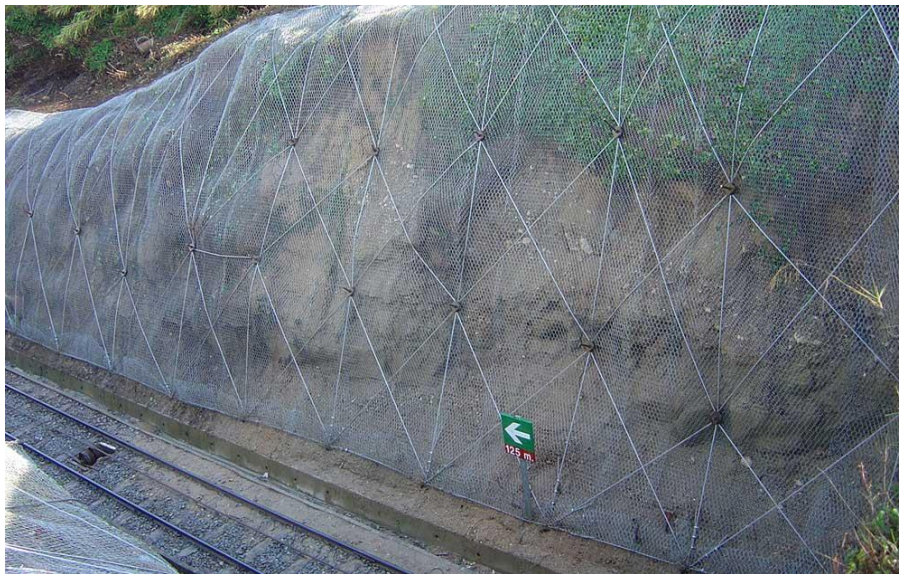
Fotografía 2. Malla metálica de triple torsión.
