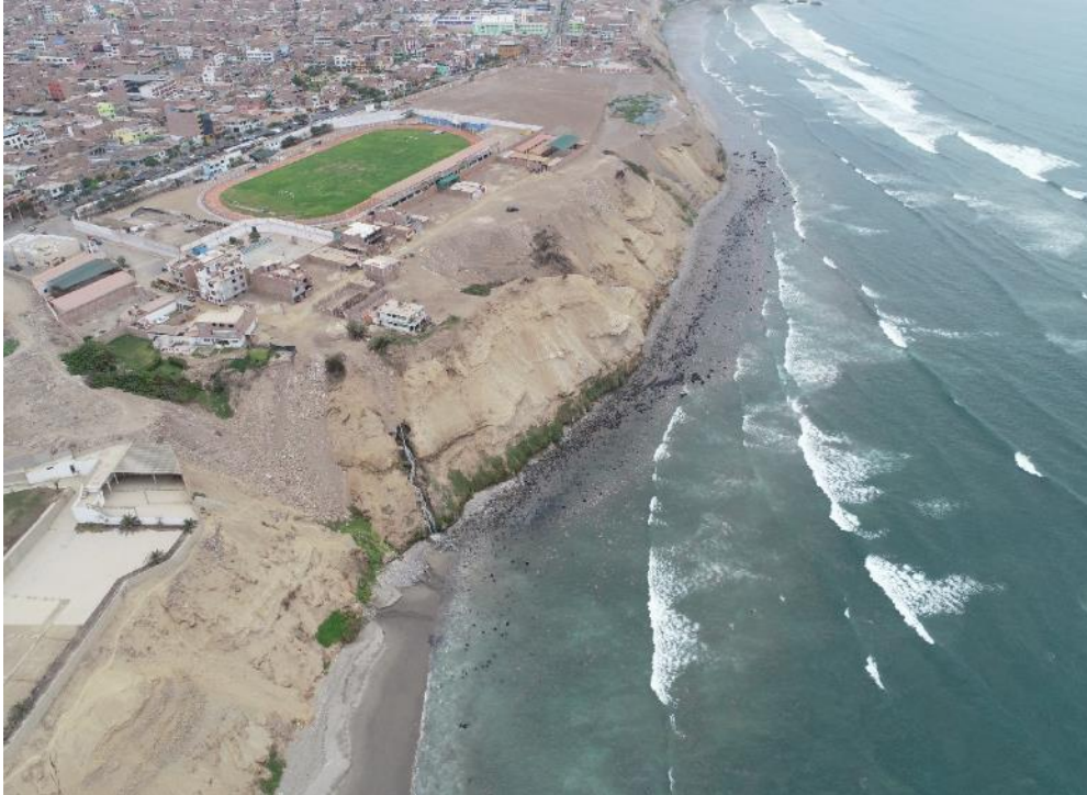
Fotografía 2. Vista frontal y lateral de los derrumbes identificados en el acantilado de la playa Chorrillos.
