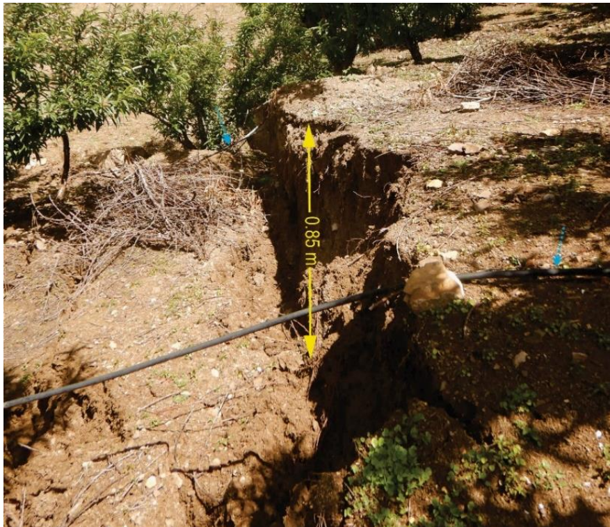
Figura 15. Vista con dirección a noroeste, donde se observa agrietamientos transversales con saltos de hasta 0.85 m. Cabe resaltar que el suelo se encontraba húmedo debido a la afectación de tuberías de riego.
