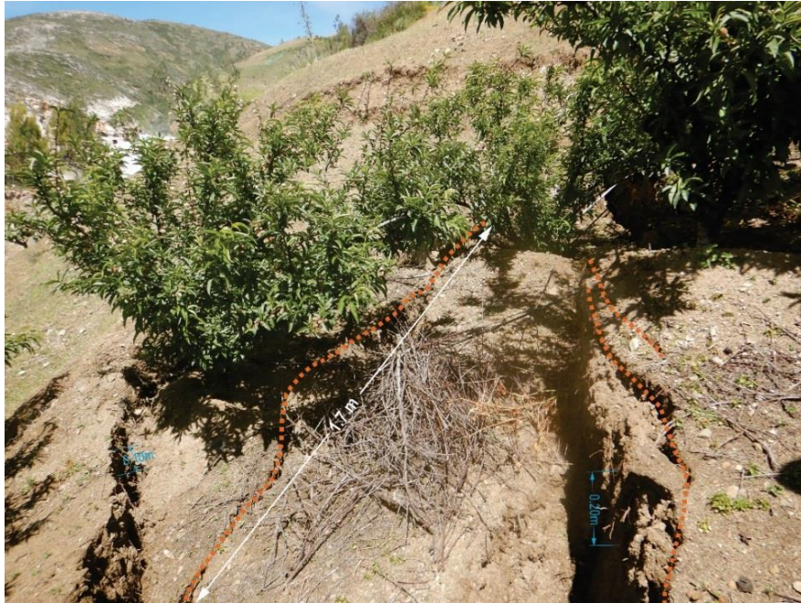
Figura 14. Agrietamientos transversales de hasta 1.7 m con salto de 0.10 a 0.20 cm, con aberturas de 0.10 cm. Ubicado en las coordenadas UTM 8977640 N, 208774 E, con altitud de 2952 m s.n.m.
