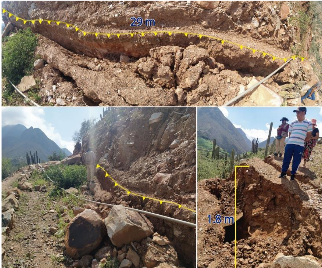
Figura 35. Muestra la corana principal y el salto de escarpe del deslizamiento en proceso de formación
