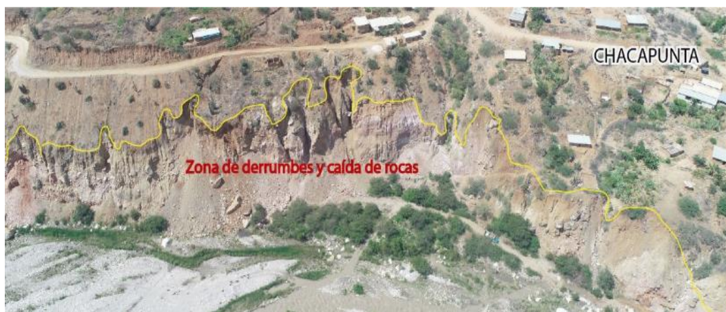
Figura 43. Muestra las zonas de derrumbes y caída de rocas, en el sector Chacapunta.
