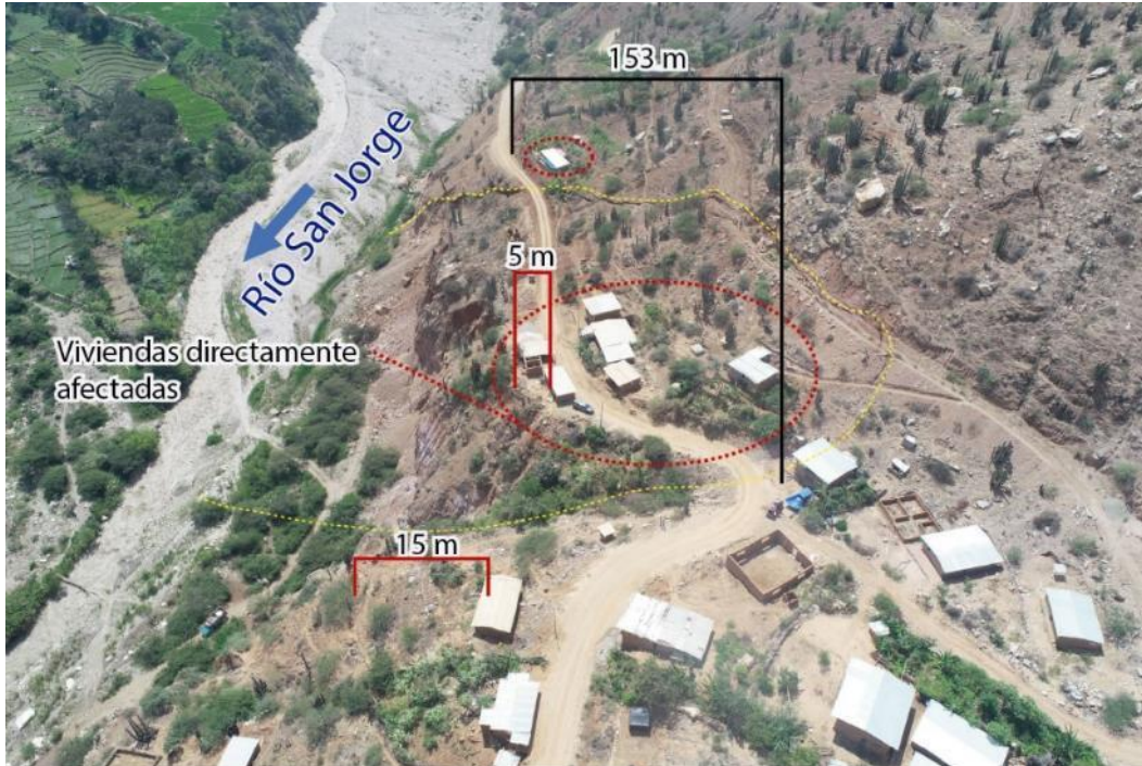
Figura 40. Imagen aérea que muestran las viviendas dentro del cuerpo del deslizamiento, de igual manera se observan viviendas muy próximas al borde de la ladera.
