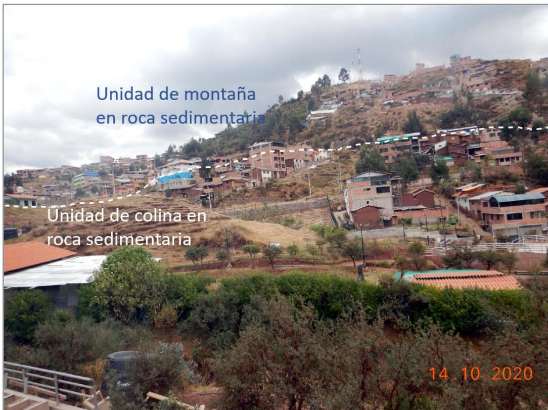
**Figura 6.** Vista al suroeste de la quebrada Saphy, la unidad de montaña en roca sedimentaria y la unidad de colina en roca sedimentaria.
