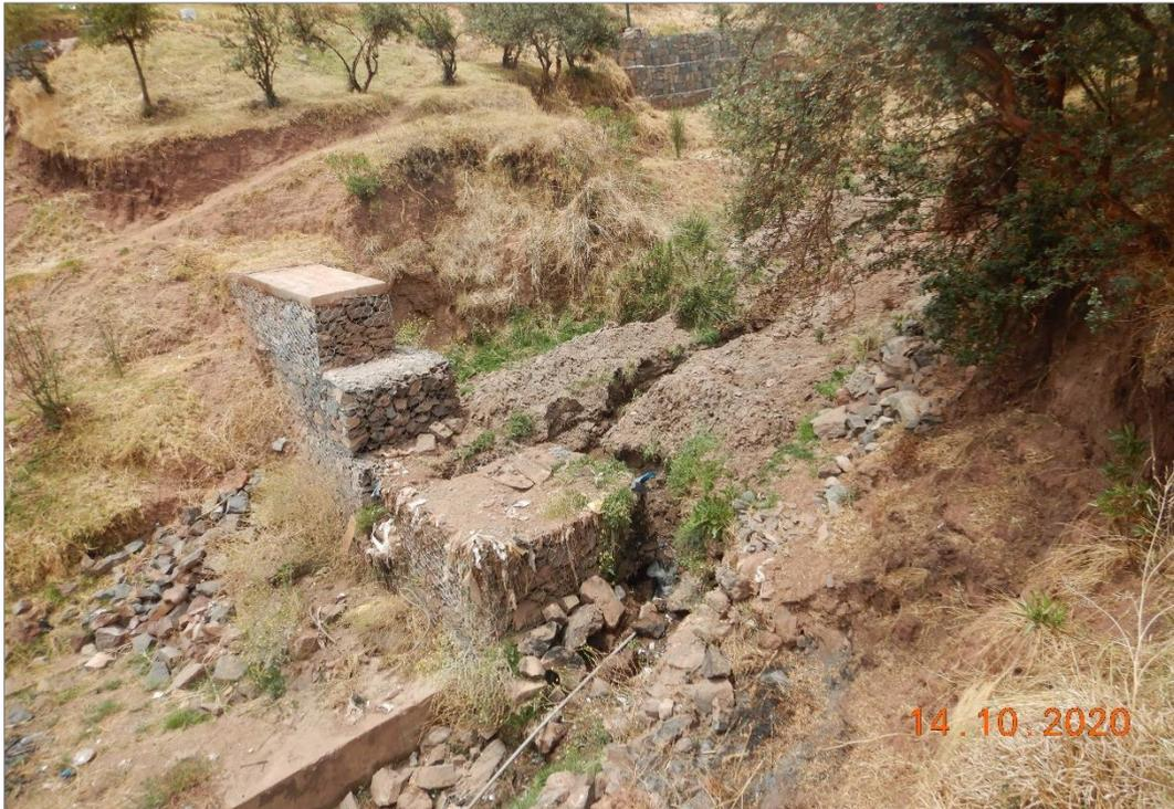
**Fotografía 5.** Vista de diques transversales dañados por la erosión fluvial de la quebrada Huasahuara. Con coordenadas UTM (WGS84): 824714 E, 8504980 N a 3628 m s.n.m.
