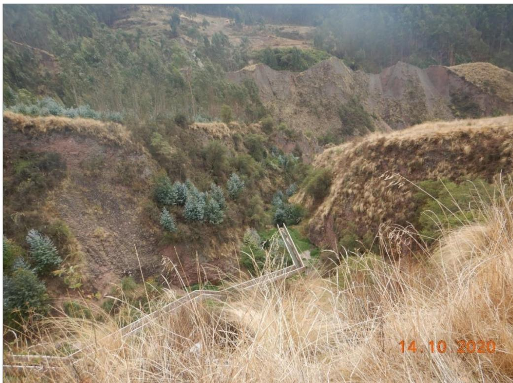
**Fotografía 3.** Vista del cauce canalizado de la cárcava que confluye a la quebrada Muyu Orcco, el cual atenúa y/o reduce la erosión fluvial en las márgenes de la quebrada referida. Con coordenadas UTM (WGS84): 175783 E, 8505419 N a 3544 m s.n.m.
