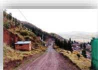
50. Lote I-7 para la construcción de una vivienda se recomienda la remoción del material coluvio – deluvial de la zona, la estabilización del talud con muros de contención tipo andenería y construcción con un proyecto de vivienda.
