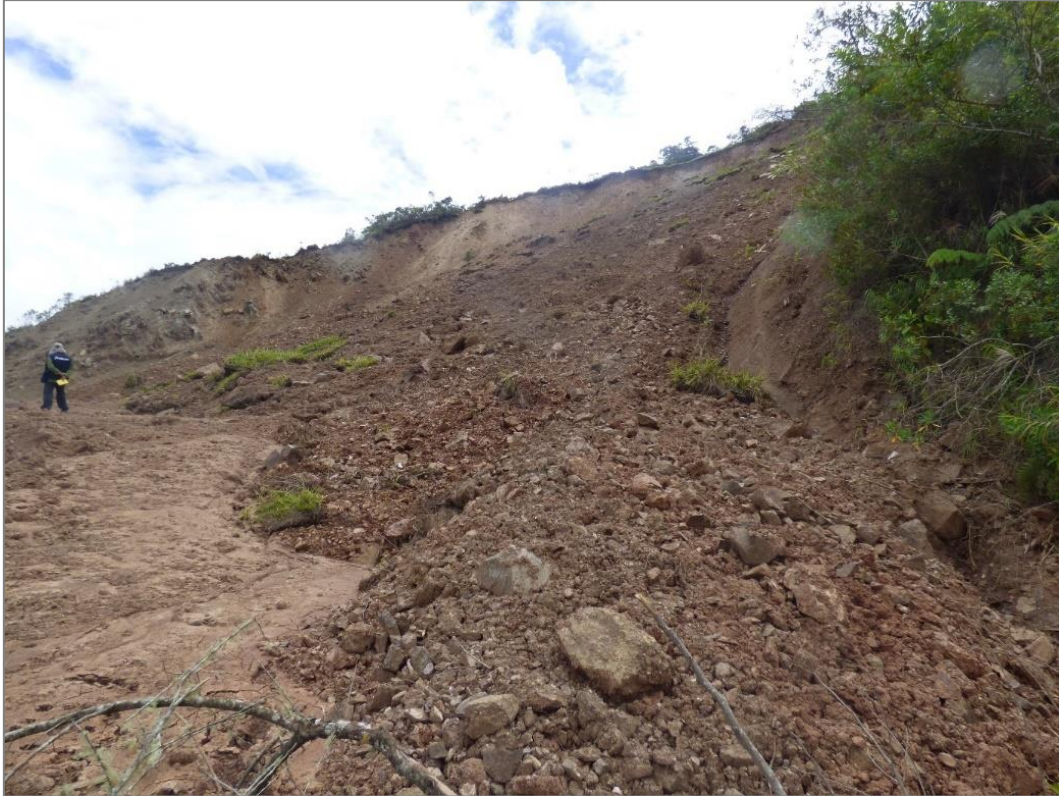
Fotografía 2. El flanco izquierdo del derrumbe está compuesto por bloques de formas angulosas, con diámetro mayor a 1 m, arenas, limos y arcillas inmersos en material lodoso, muy inestable al paso peatonal.
