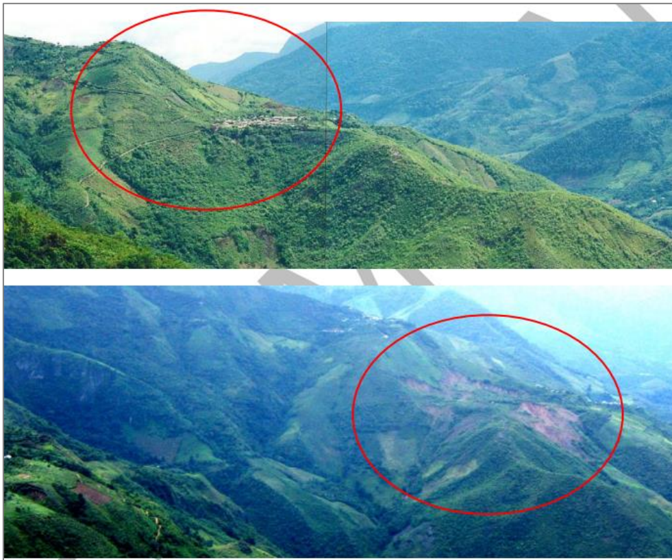
Figura 1. Vistas comparativas de los caseríos Apangoya y Bello Horizonte afectados por un deslizamiento de tierras en la margen derecha del río Chirinos (1998 y 2007). El poblado ha sido reubicado, gracias a la evaluación oportuna del movimiento en masa en 1996.
