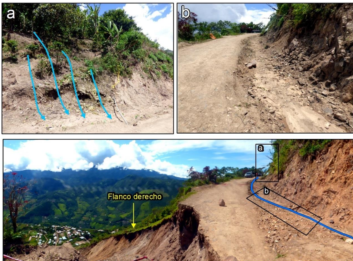
Figura 10. El flanco derecho del derrumbe presenta actividad retrogresiva, debido a la escorrentía e infiltración proveniente del drenaje no canalizado del caserío Bello Horizonte, el cual vierte sus aguas al talud inferior, generando mayor humedecimiento y saturación de agua en esa área del terreno.
