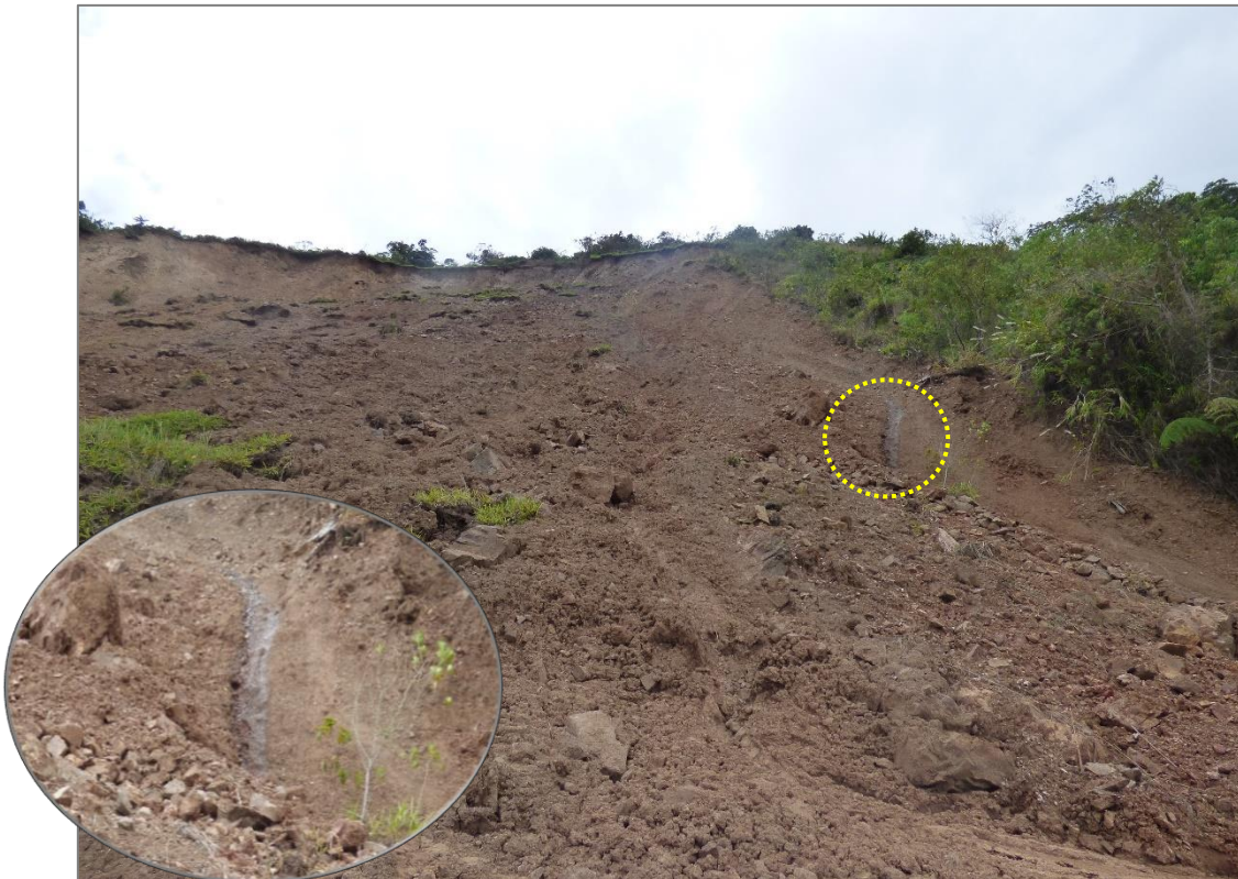
Figura 11. Vista de surgencias de agua, proveniente de la cara del derrumbe, el cual se canalizó, discurriendo cuesta abajo.
