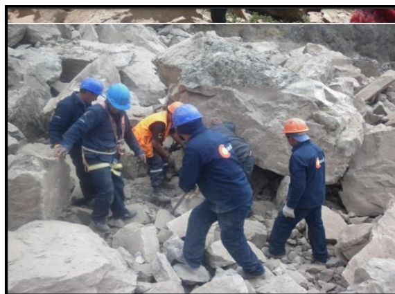
Imagen N° 19: Desquinche y voladura de material suelto, con supervisión de personal técnico calificado.
