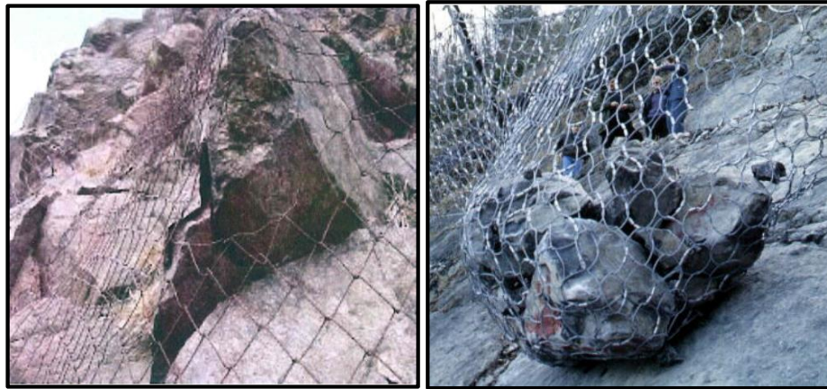
Imagen N° 18: Control de caída de rocas utilizando mallas ancladas.
