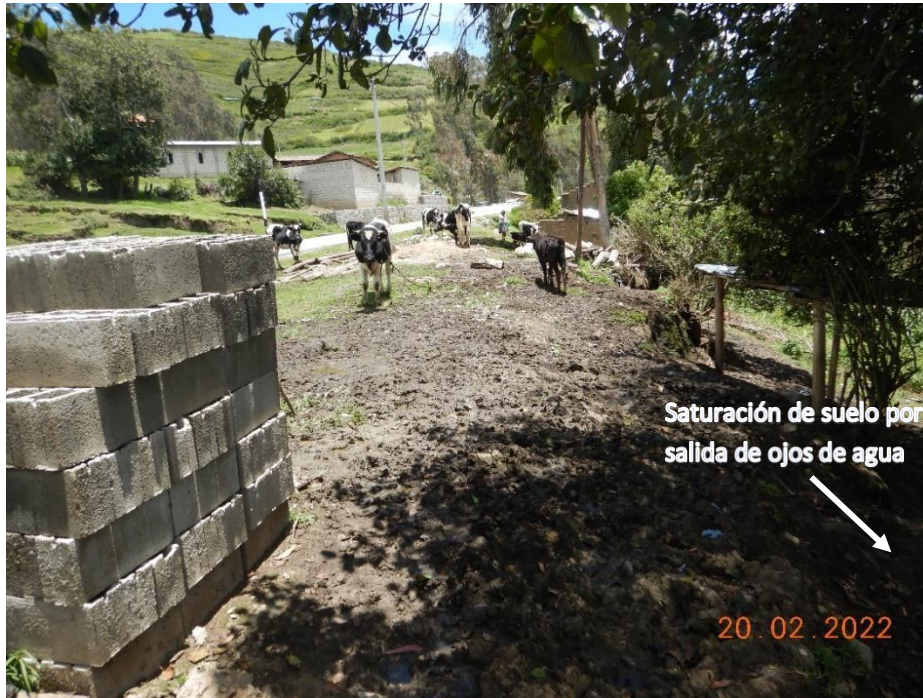
Fotografía 13. Saturación intensa del suelo por salida de ojos de agua
