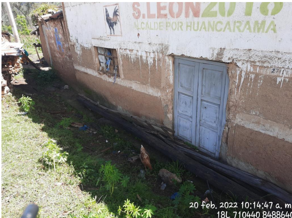
Fotografía 10. Las viviendas encontradas casi al nivel de la carretera, controlan la salida de agua con encausamiento precario. Sin embargo muchas veces la falta de limpieza colmata el cauce con material limo-arcilloso
