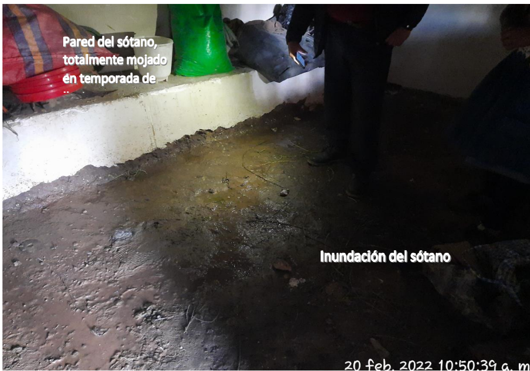
Fotografía 11. Vivienda precaria con estructura en subsuelo 'sótano', es afectada por aguas de escorrentía por la falta de cunetas en ese tramo.
