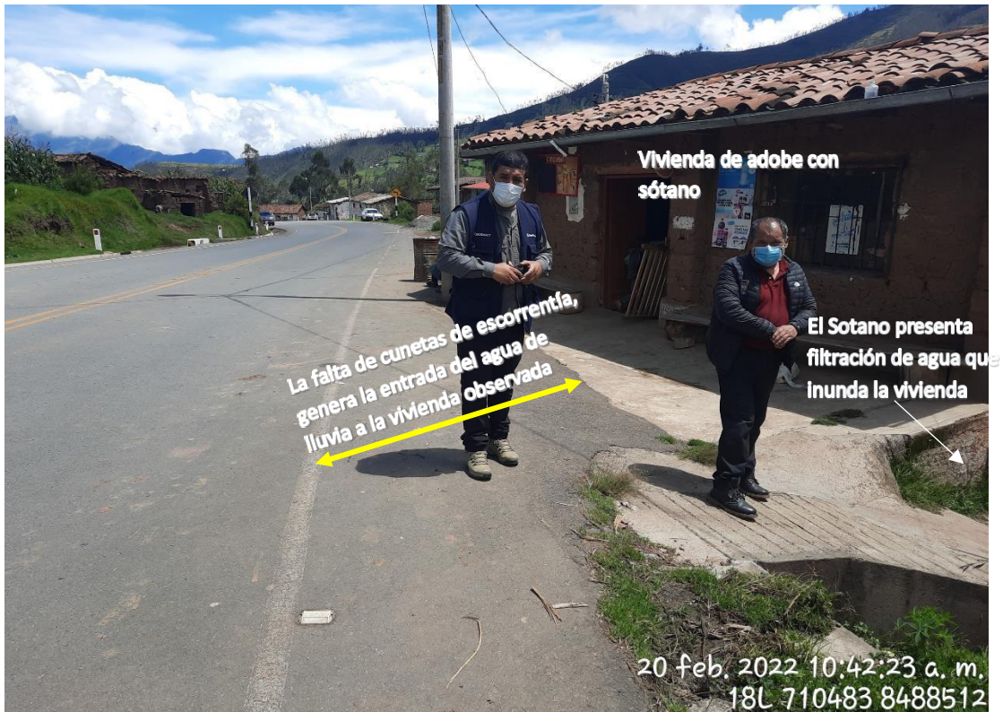
Fotografía 11. Vivienda precaria con estructura en subsuelo 'sótano', es afectada por aguas de escorrentía por la falta de cunetas en ese tramo.
