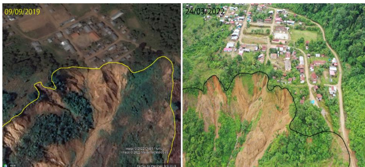
Figura 11. Muestra la comparación del avance retrogresivo de 20 metros aproximadamente del escarpe principal del deslizamiento, setiembre 2019 y marzo 2022. Fuente: Imagen satelital adquirida de Google Earth (setiembre del 2019) y fotografía capturada por el dron el día de inspección en el sector Huaylla (24/03/2022).
