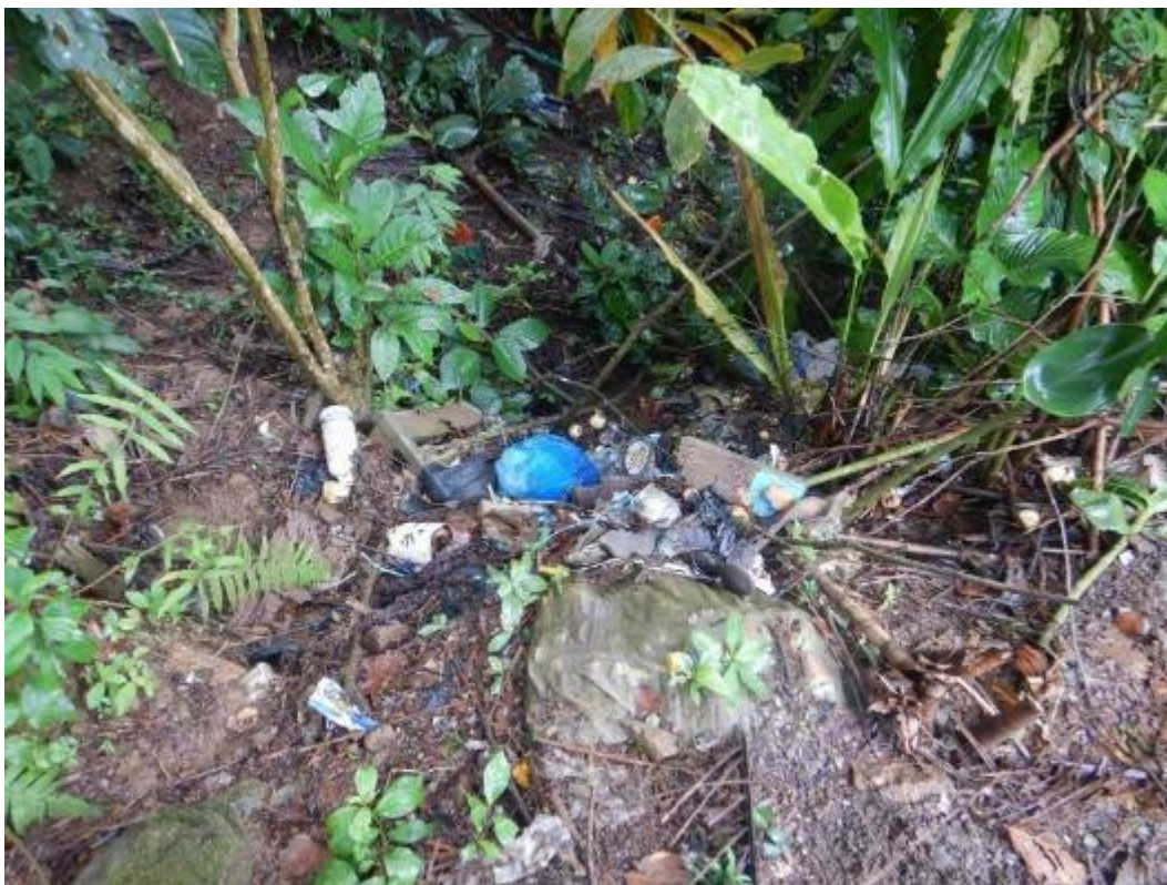
Fotografía 7. Vista de acumulación de desmote y basura, ubicada a solo metros de la corona del deslizamiento, incrementando el peso en el cuerpo.
