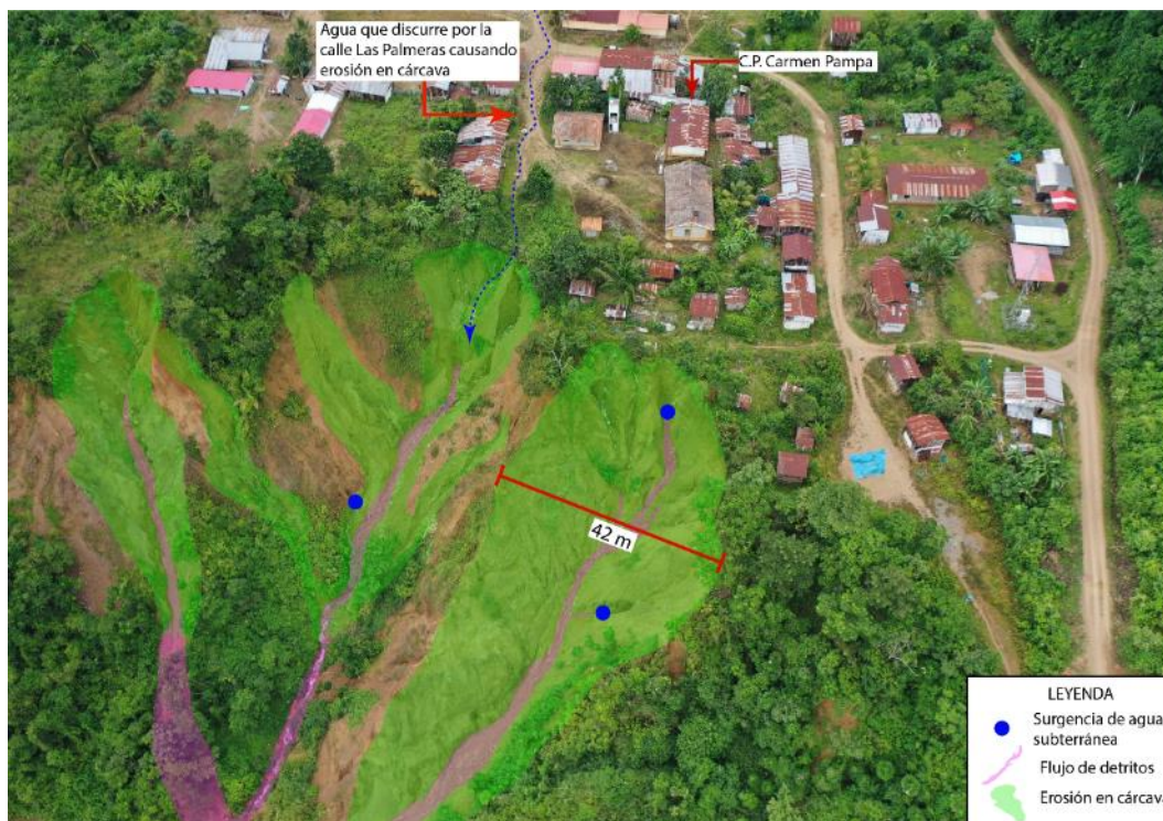
Figura 18. Vista de erosión en cárcava que se desarrollan sobre el cuerpo del deslizamiento, esta erosión avanza con dirección SE, hacia el C.P. Carmen Pampa; cabe mencionar que este proceso se desarrolla por la erosión del agua superficial y surgencias de agua subterránea.
