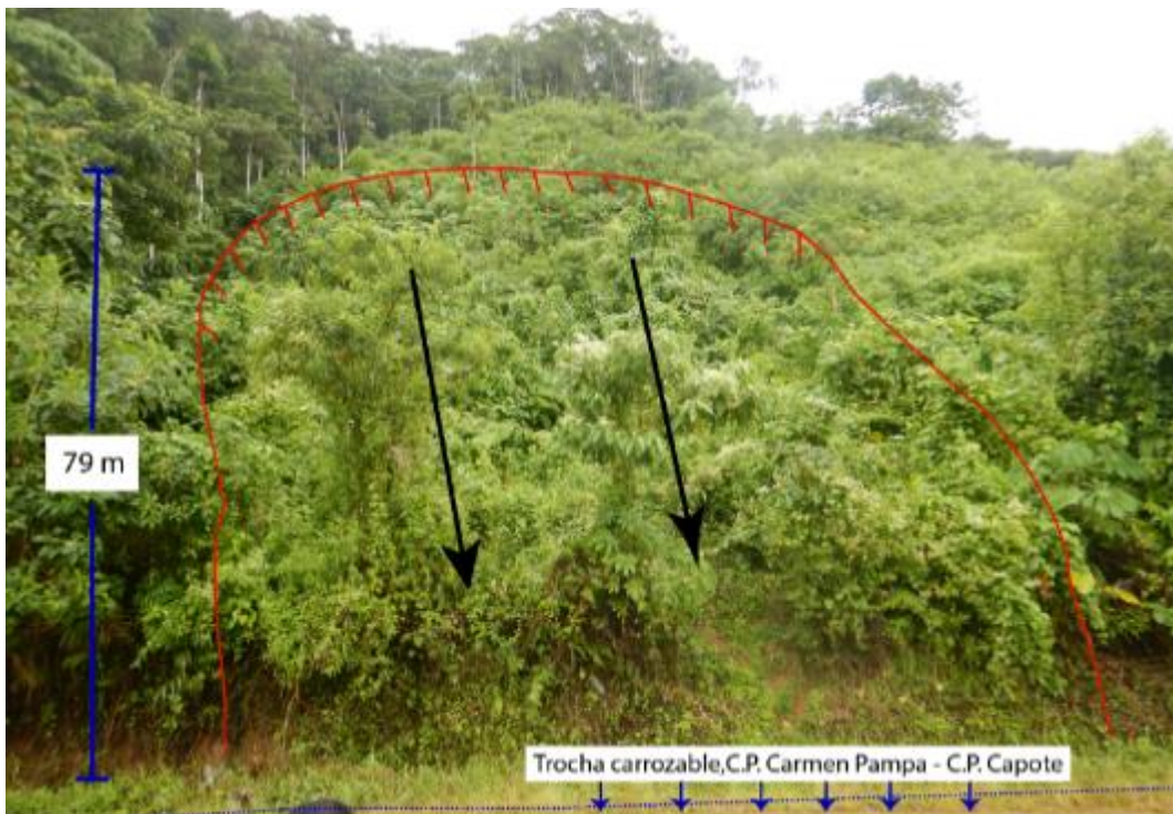
Figura 21. Se delimitó el derrumbe con línea de color rojo, evento que ocurrió el año 2012, abarca 200 m 2 , ubicado en la ladera del cerro al sur del C.P. Carmen Pampa, con coordenadas UTM (WGS 84): 606583 E; 8622666 N.
