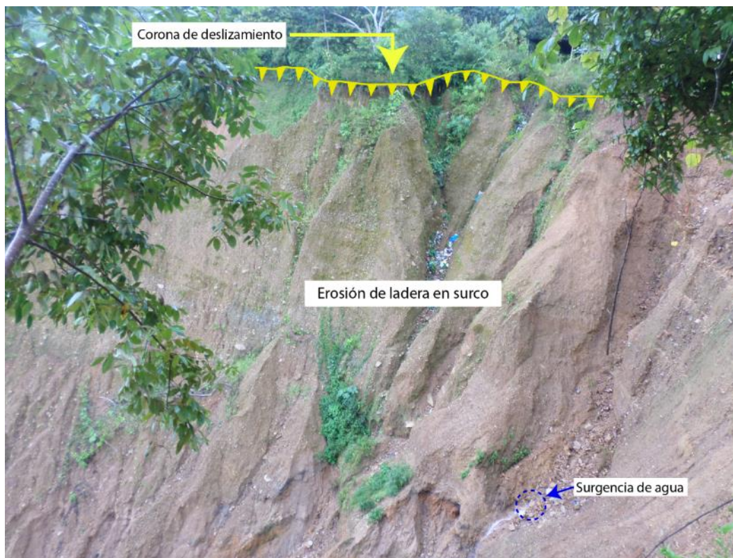
Figura 13. Se observa erosión de ladera en cárcava en el cuerpo del deslizamiento y una surgencia de agua subterránea, con coordenadas UTM (WGS 84): 606758 E; 8622745 N.
