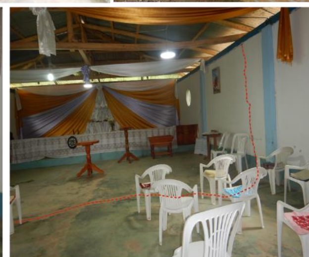
Figura 16. Se observa agrietamientos en la infraestructura de la iglesia evangélica, tanto en las paredes como en el piso que varían desde los 2.5 m a 7 m de longitud con una separación de 2 cm a 4 cm.
