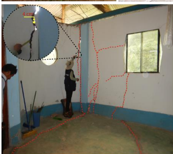
Figura 16. Se observa agrietamientos en la infraestructura de la iglesia evangélica, tanto en las paredes como en el piso que varían desde los 2.5 m a 7 m de longitud con una separación de 2 cm a 4 cm.
