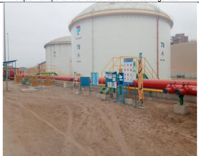
Foto N° 16: Los tanques de almacenamiento cuentan con el sistema contra incendios donde la tubería amarilla es la espuma aérea y la tubería roja es de agua aérea y subterránea.
