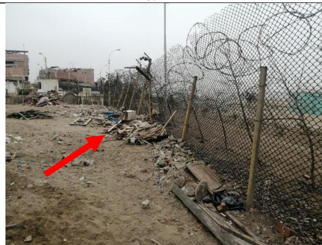
Foto N° 09: Cerco de malla metálica con alambrado en mal estado de conservación y puntos críticos de residuos de construcción
