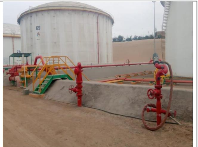
Foto N° 20: Monitor e hidrante que forma parte del sistema contra incendio del área de tanques de almacenamiento – cota alta de la refinería.
