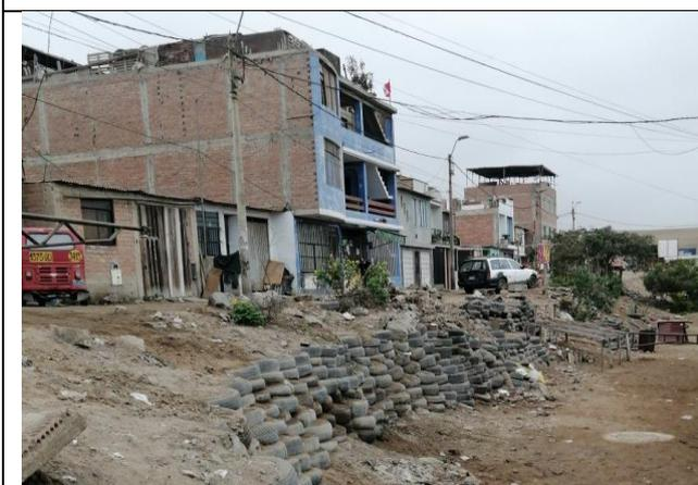
Foto N° 05: En la imagen mostrada se observa un muro de contención de llantas.
