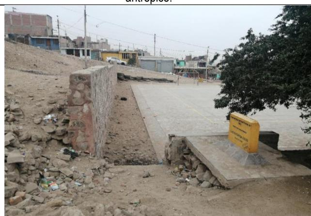
Foto N° 06: También se observan muros de contención de tipo enrocado
