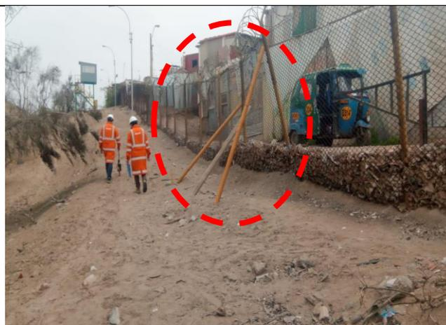
Foto N° 12: Refuerzos de madera y tubos metálicos para sostener la malla en mal estado de conservación de la Refinería Conchán.
