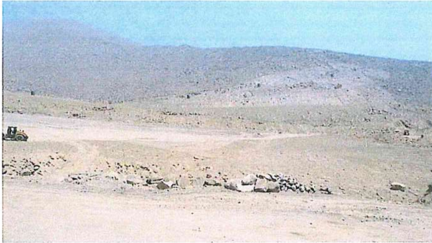
Terrazas logradas con movimiento de tierras (corte y relleno)
