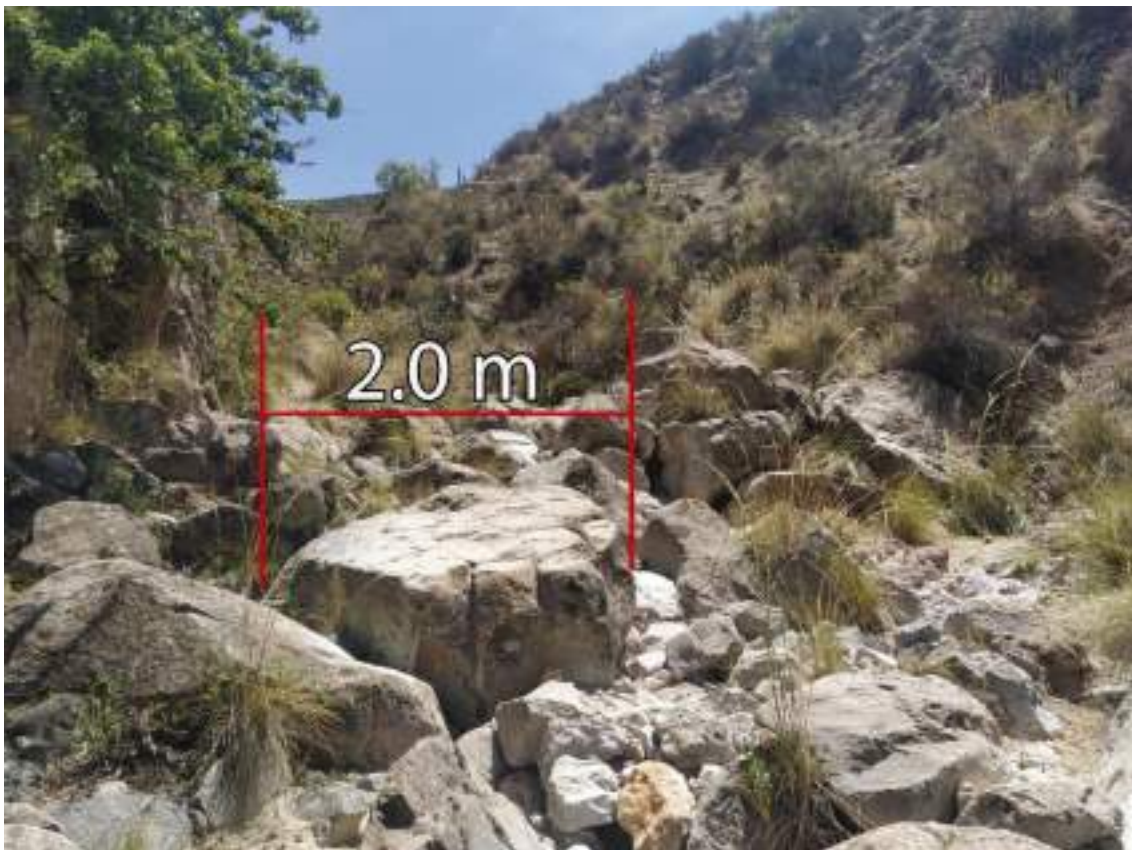
Figura 28. Material detrítico acumulado en la quebrada río Millu Cuchu Macma.
