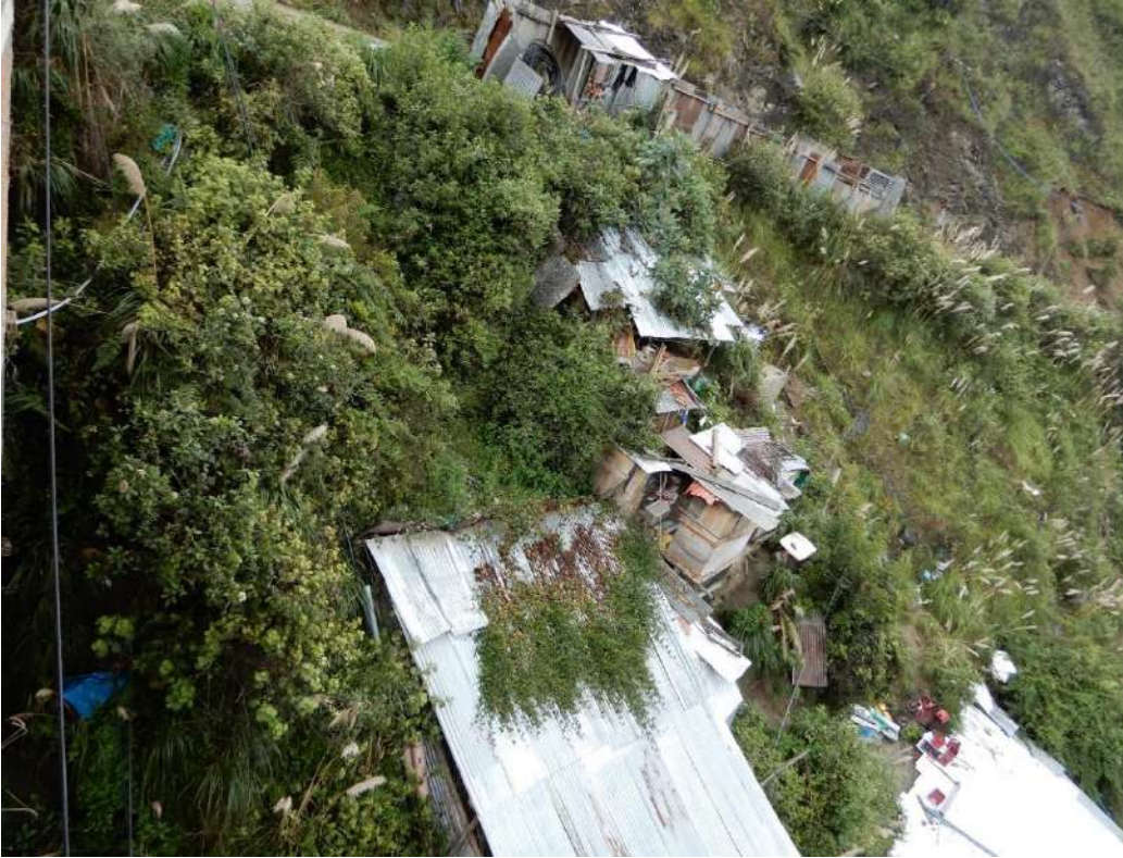
Fotografía 14: Vista del derrumbe que ocurrió el año 2009. Actualmente se encuentra habitado por dos viviendas dispuestas en la ladera y construidas sobre el depósito del derrumbe.
