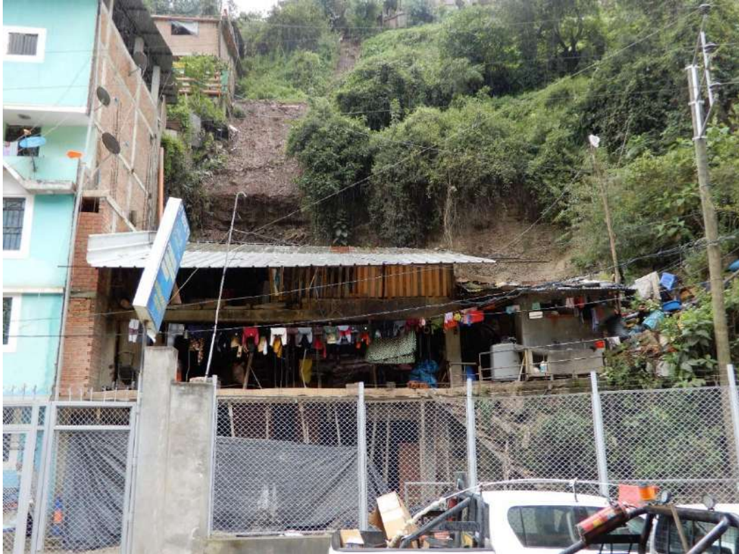
Fotografía 4: Derrumbe activo (PI-2) condicionado por la construcción (corte de talud) de vivienda ubicado al pie de ladera.
