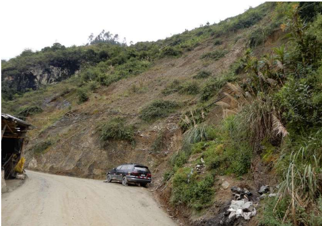
Fotografía 19: Ladera susceptible a la ocurrencia de derrumbes, ubicado en la margen izquierda del río Parcoy (sector Lamas), que pone en peligro viviendas ubicadas al pie de la ladera, tuberías de agua y un tramo de la carretera Lamas-Retamas.
