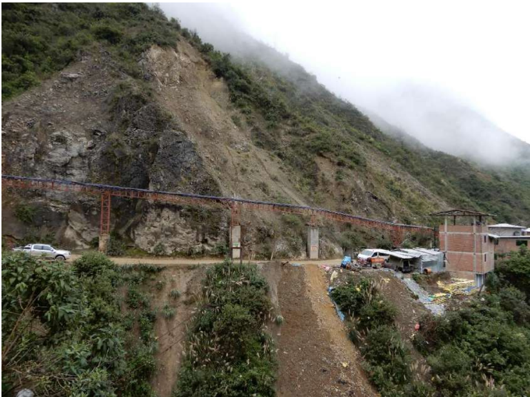
Fotografía 17: Derrumbe activo, que, de acuerdo con testimonios de la población, el año 2021, afectó socavón de entra para la mina Alpamarca.
