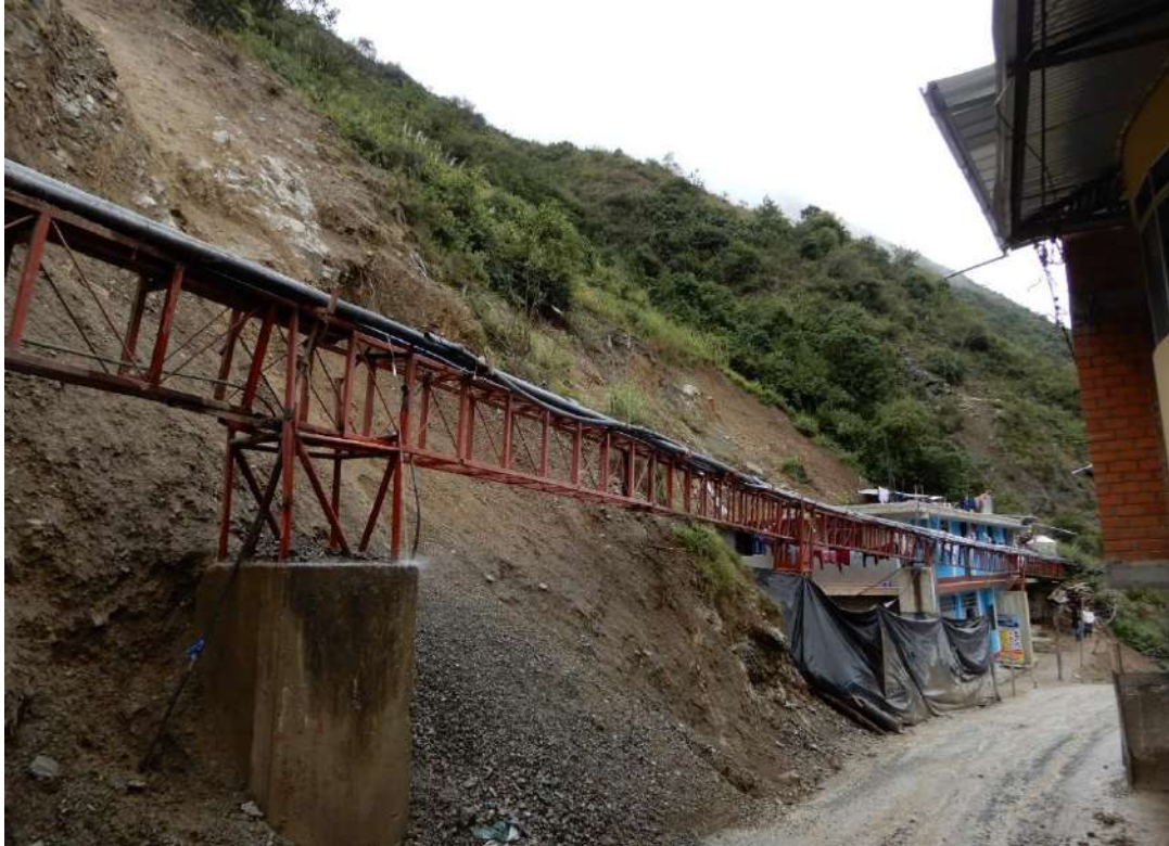
Fotografía 18: Zona de derrumbes antiguos y activos que recientemente, producto del desprendimiento de rocas, dañaron tubería de agua, y a la vez pone en peligro viviendas asentadas al pie del talud.
