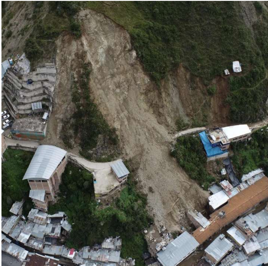
Fotografía 11: Vista panorámica del derrumbe donde se muestra la zona de arranque del derrumbe y el depósito tipo canchal.
