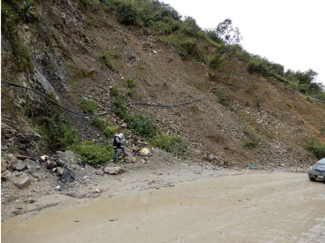
Fotografía 20: Derrumbe activo que según testimonios de los pobladores afectó vivienda ubicada al pie del talud; condición que pone en peligro viviendas aledañas por ser una zona susceptible a estos procesos de movimientos en masa.
