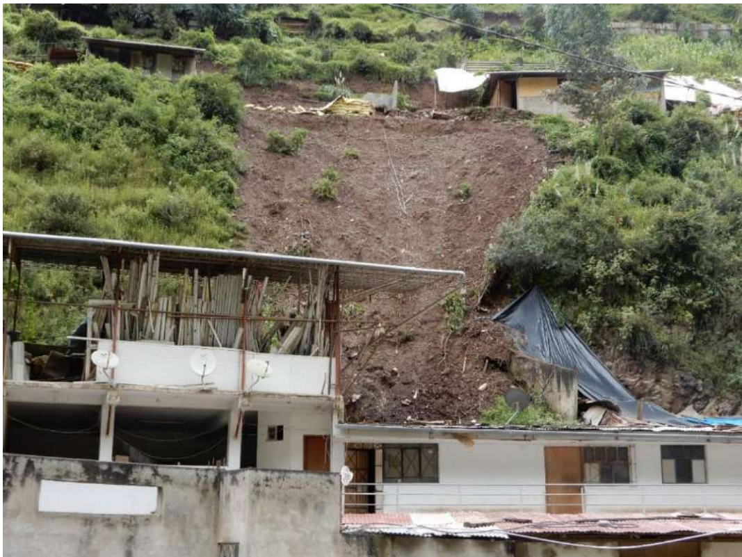
Fotografía 3: Derrumbe activo (PI-1) ubicado a la altura del puente El Encanto, que pone en peligro a dos viviendas ubicadas al pie de la ladera.
