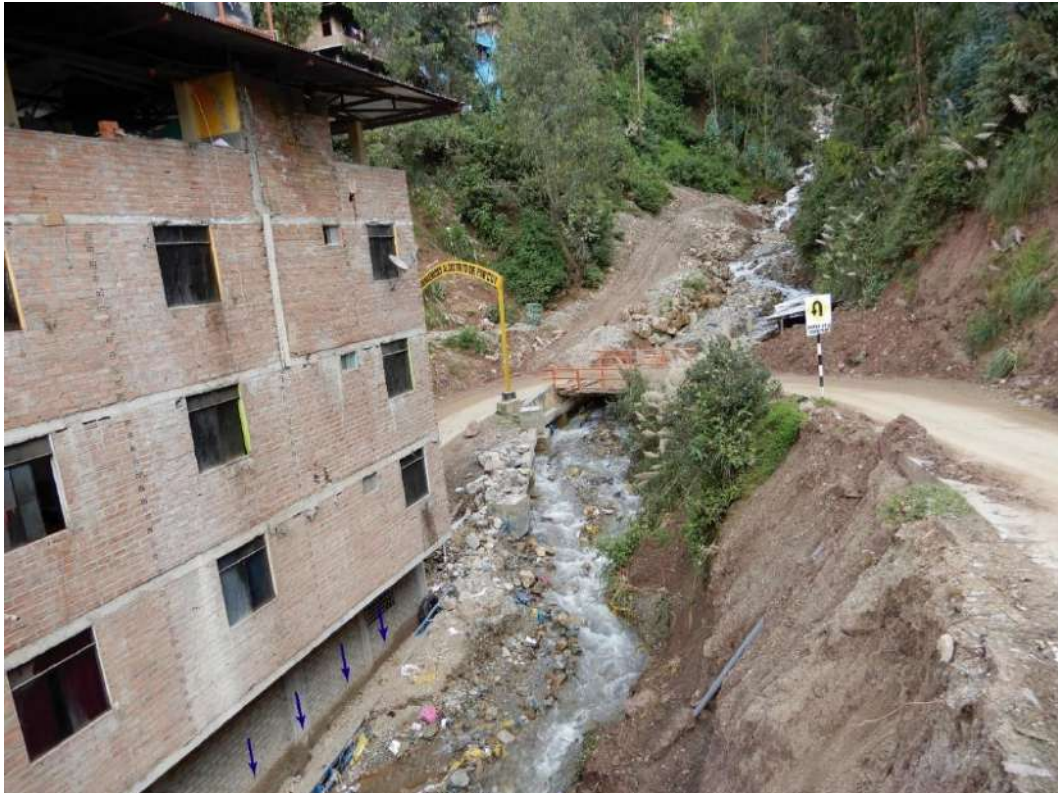
Fotografía 6: Vista en la que se puede observar huellas (marcadas con flechas azules) dejadas por la crecida del río Retamas. Así mismo hacia el fondo del cauce se tiene material proluvial compuesto de bloques de roca de hasta 0.8 m de diámetro.
