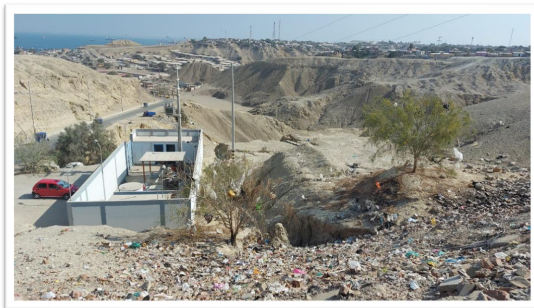
Fotografía 7: Vista de la Caseta de Bombeo N°1 próximo al talud erosionado.
