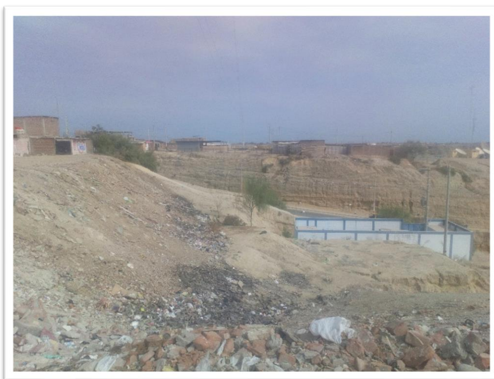
Fotografía 4: Asentamiento humano Keiko Sofía. La escorrentía de aguas de lluvia provenientes de los techos de las casas del centro poblado desciende hacia el abismo atravesando la caseta de bombeo erosionando el suelo en que se apoya la misma. Se ha proyectado la construcción de muros de gravedad con canaleta pluvial para evacuación controlada de aguas pluviales hacia el abismo.
