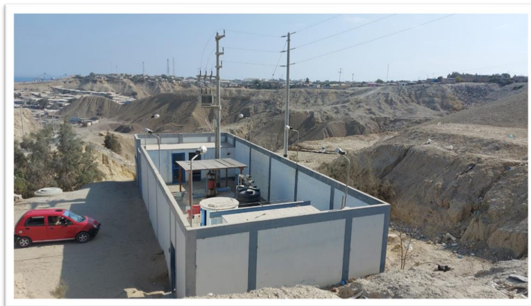
Fotografía 8: Vista de la Caseta de Bombeo N°1 próximo al talud erosionado.
