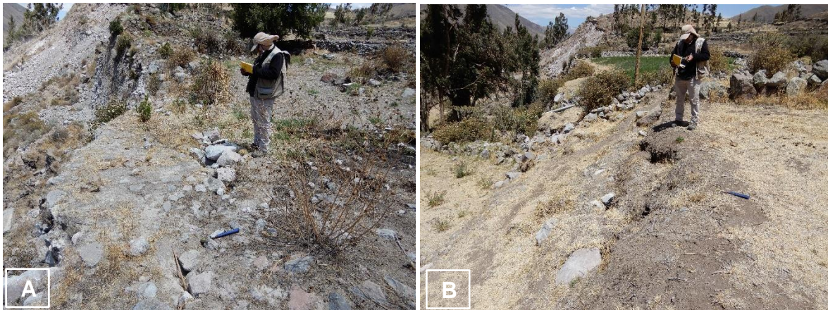
Figura 6. A) Grieta N°12 con tendencial norte 300°, apertura 30cm, distancia desde el eskarpe 2.30 cm, longitud 6.80 m y B) grieta N°13 con tendencia norte 315°, apertura 50 cm, distancia desde el eskarpe principal 3.40 m y longitud 11.10m.
