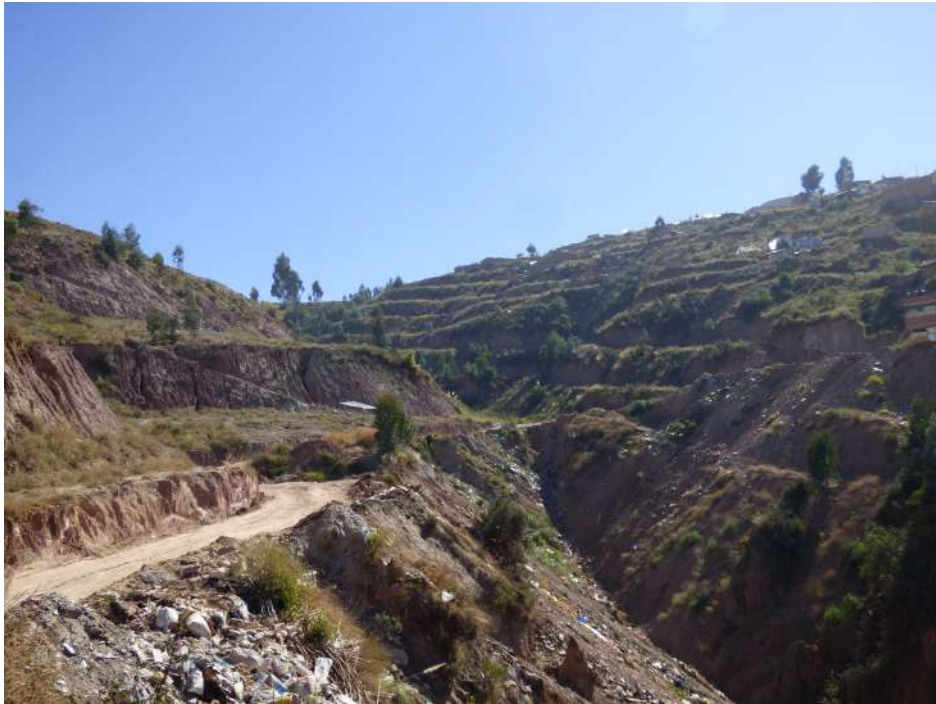
Fotografía 10.11 Cabecera de quebrada S/N, donde se puede observar las terrazas realizadas en las vertientes para poder construir viviendas; también se observa el desmonte y basura arrojada en la quebrada.
