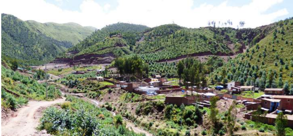
Fotografía 10.1 Viviendas ubicadas en las desembocaduras del cauce de las cárcavas que podría ser afectada por flujos.
