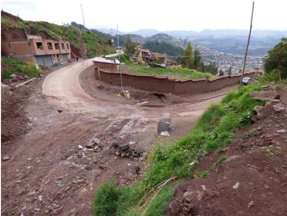
Fotografía 10.42 Quebrada Infiernillo, con obstáculo en su cauce para el libre pase de flujos.
