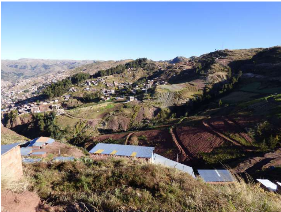
Fotografía 10.36 Parte alta de la quebrada Soltero Huayco afectada por procesos de erosión en cárcava y surcos.
