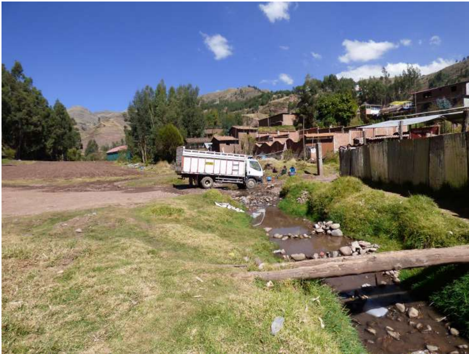
Fotografía 10.3 Vista aguas arriba de la quebrada Huanacahuire en el sector de Mamatunya, las viviendas se han asentado muy cerca al cauce de la quebrada.
