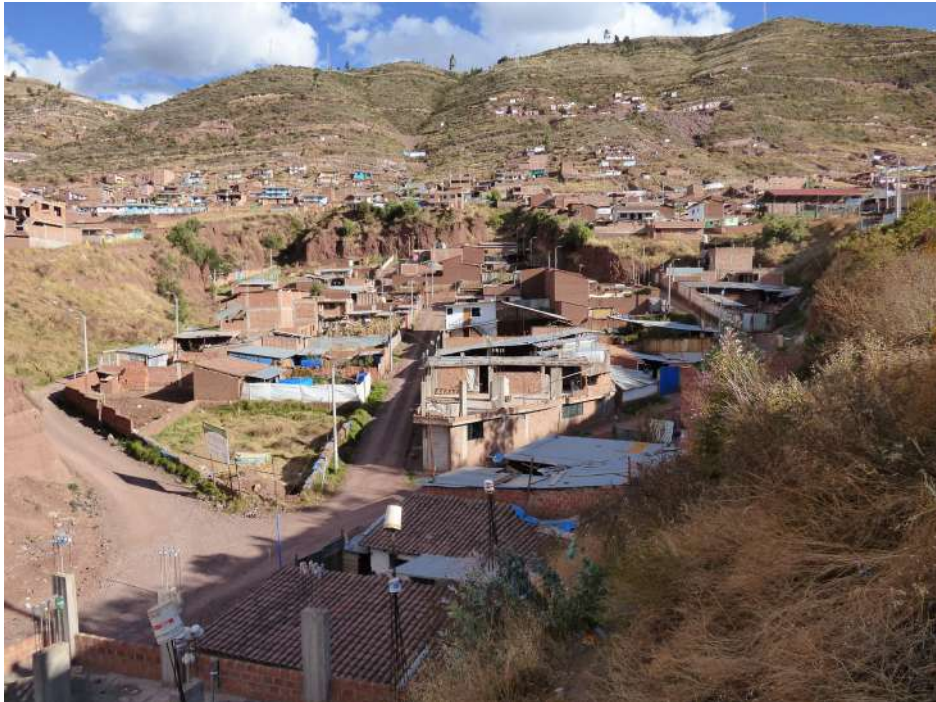
Fotografía 10.19 Vista aguas arriba donde se puede apreciar la ocupación total del cauce de una cárcava con viviendas de material noble.
