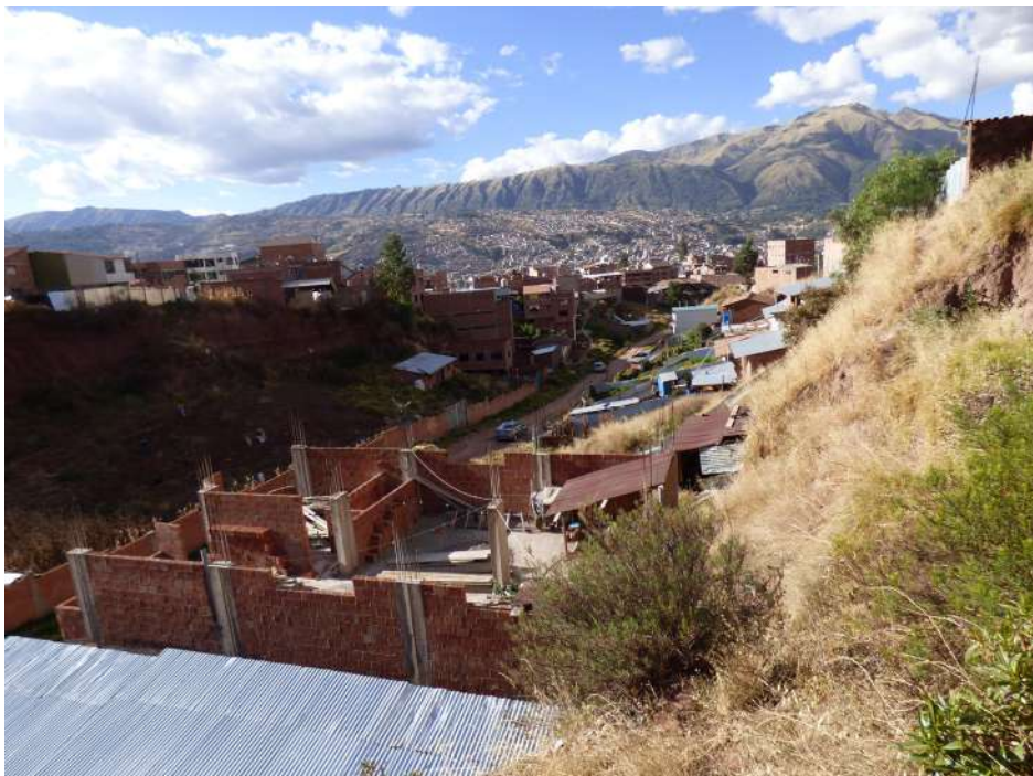
Fotografía 10.20 Toma aguas abajo de cárcava que viene siendo ocupada progresivamente por viviendas de material noble.
