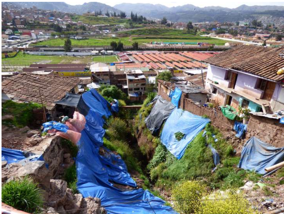
Fotografía 10.49 Viviendas asentadas en los bordes de la erosión en cárcava en el sector de Tinco.
