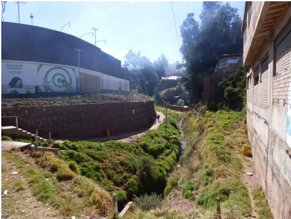
Fotografía 10.12 Vista aguas arriba de la quebrada S/N, tomada desde la avenida Cultura Prolongación; se puede ver los trabajos de encauzamiento realizados con muros de concreto.
