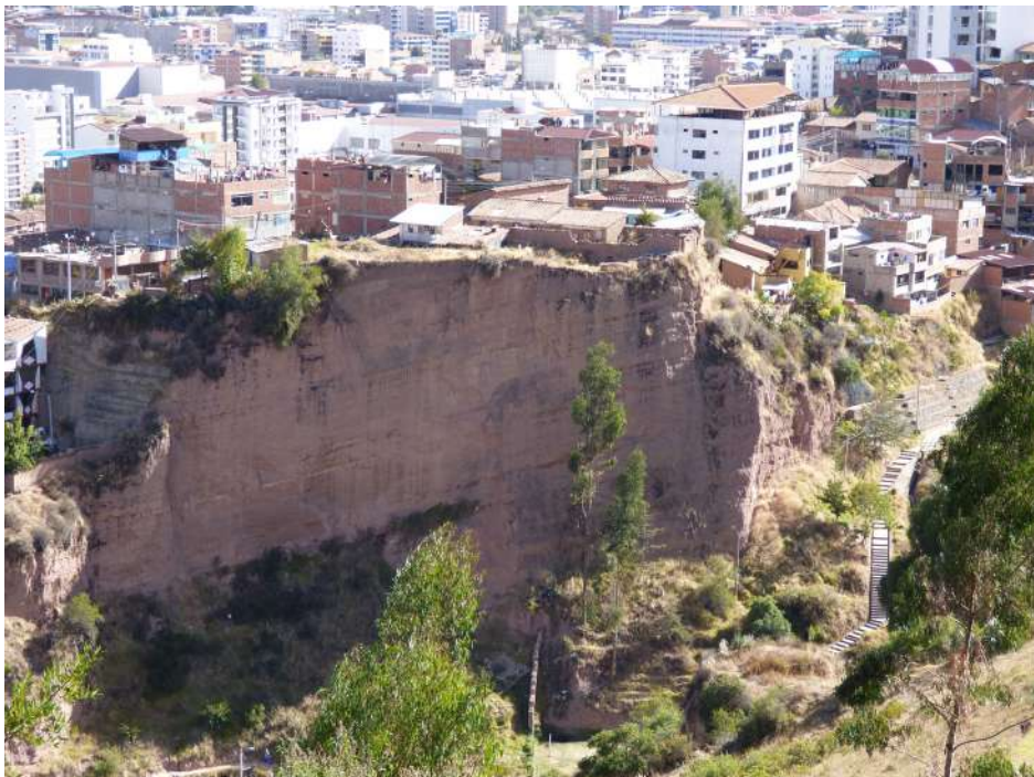
Fotografía 10.24 Acantilado vertical en la margen izquierda de la quebrada Shihuila; se observan viviendas construidas en el borde del acantilado.
