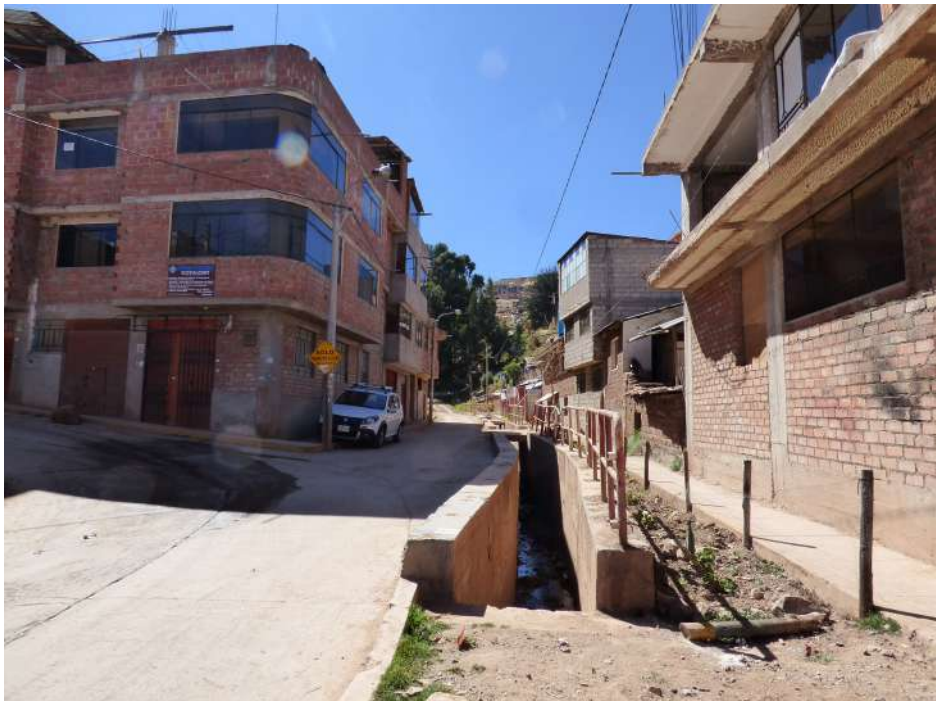
Fotografía 10.8 Cárcava encauzada por la calle San Miguel con un canal revestido de concreto de sección angosta.
