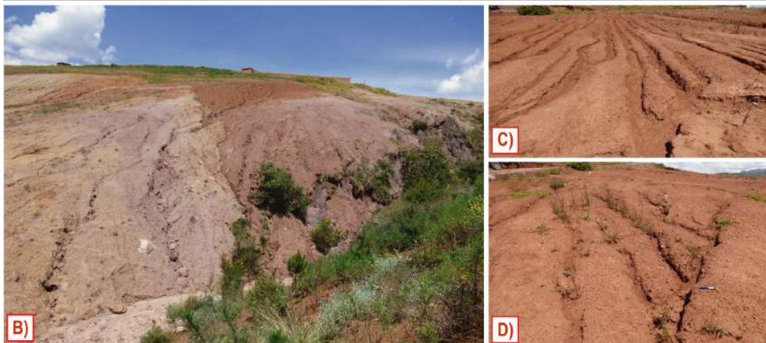
Figura 4.15 a) valor GSI estimado para la subunidad de conglomerados, areniscas y arcillitas; b), c) y d) se observa la estructura del macizo completamente desintegrada, fácilmente disgregable y fuertemente meteorizado.
