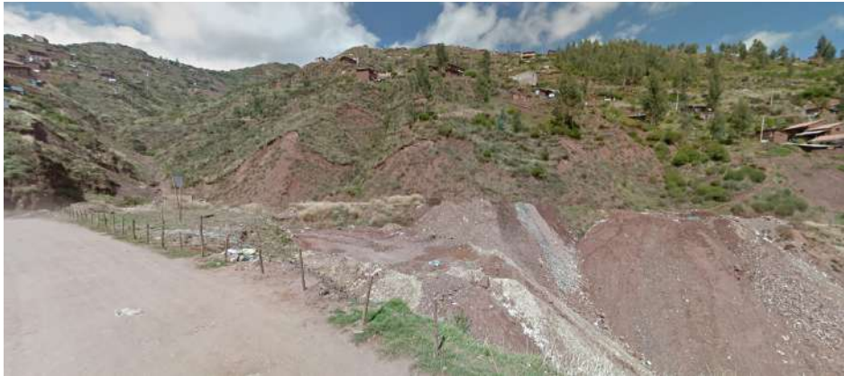
Fotografía 10.46 Depósito de desmonte en la quebrada Ccorimachachuayniyoc donde podría generarse flujos.
