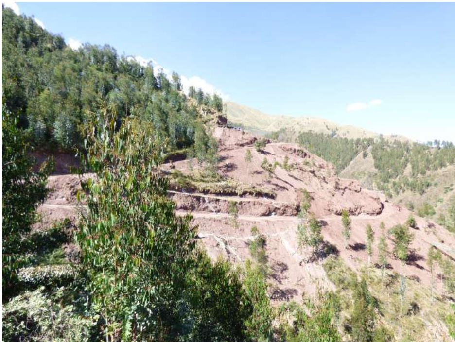
Fotografía 10.2 Ladera de muy fuerte pendiente, deforestada y delimitada en lotes para construcción de viviendas donde pueden generarse derrumbes y flujos de lodo; además, se observa corte de talud escalonado. Se ubica en la margen derecha de la quebrada Huacotomayo.
