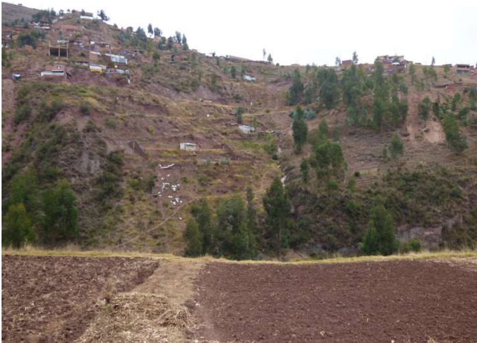
Fotografía 10.17 Asentamiento en rellenos de desmonte y basura colocados en una de las cárcavas; se observa los agrietamientos del terreno y en las paredes de la vivienda.
