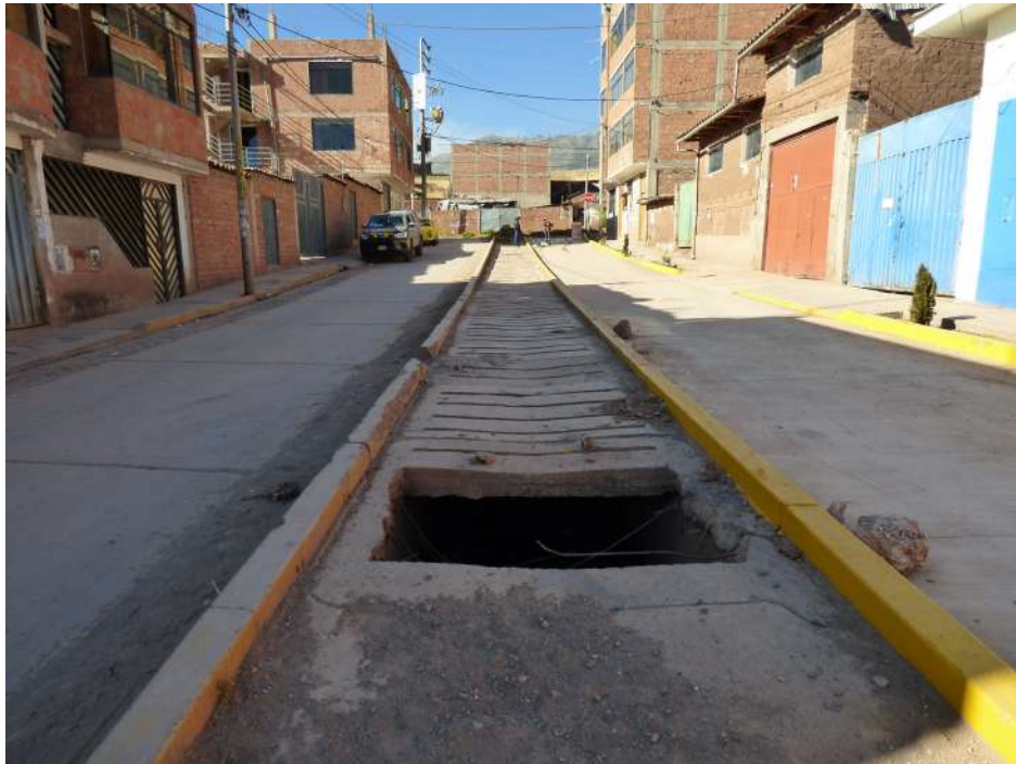
Fotografía 10.13 Vista de parte del tramo encauzado, cubierto y desviado de la quebrada Timpoq.
