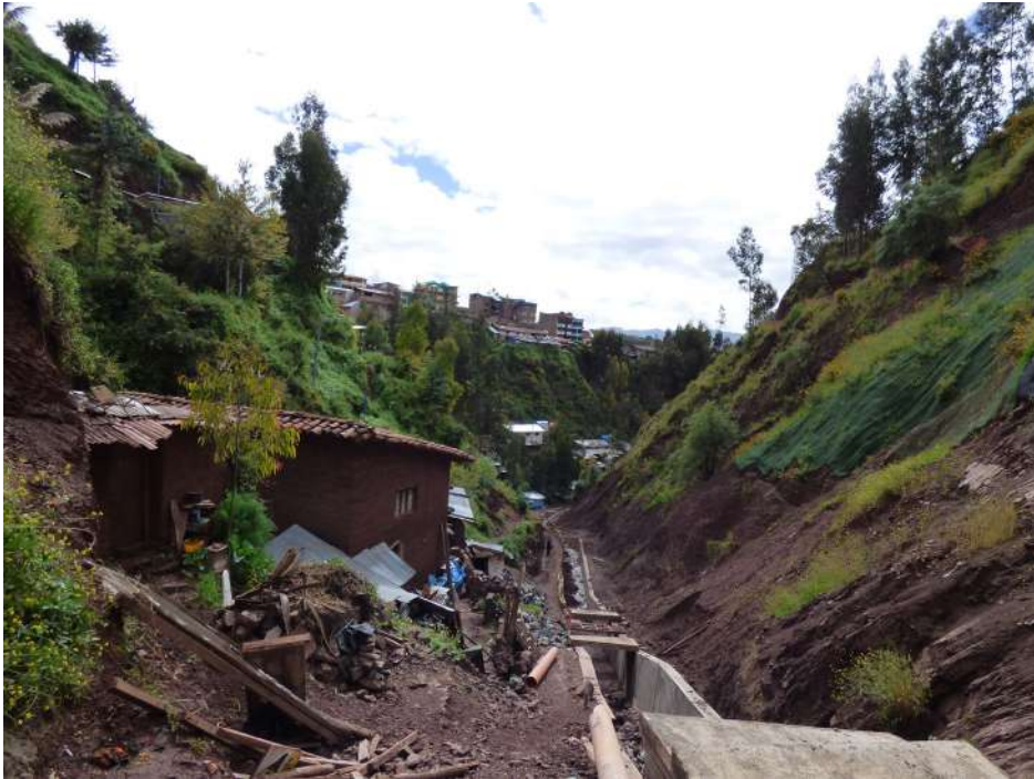
Fotografía 10.33 Laderas inestables ubicadas en la quebrada Ayahuayco.
