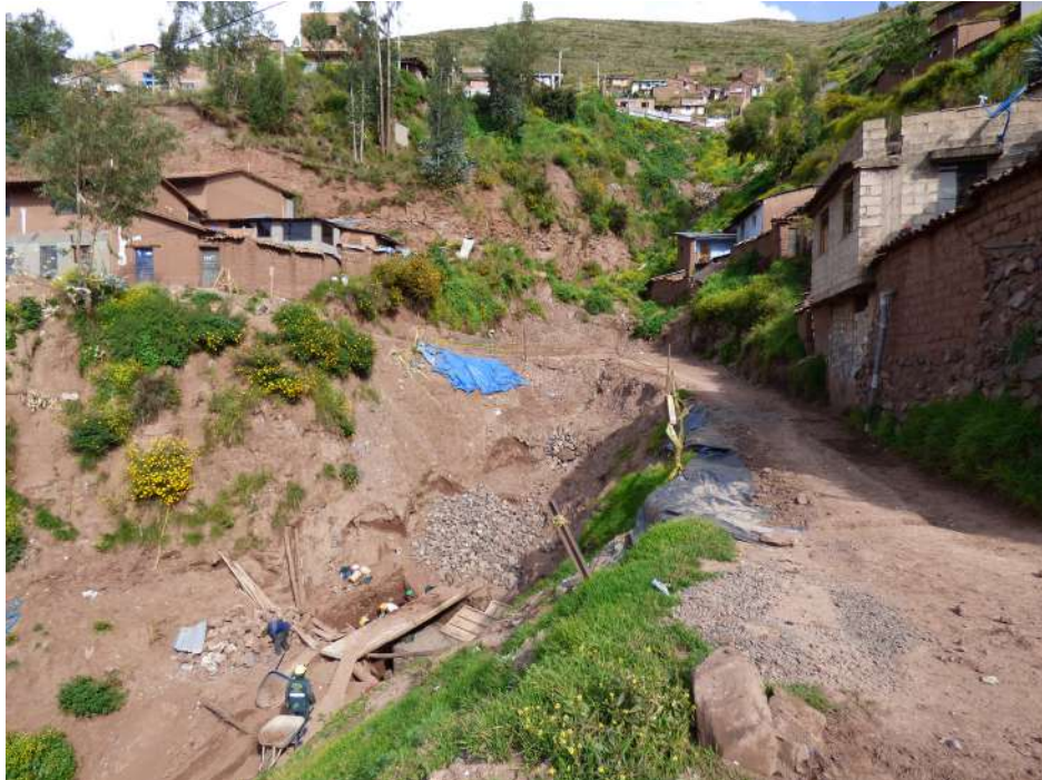
Fotografía 10.48 Proceso de erosión en cárcava en desarrollo ubicado en el sector de Tinco.
