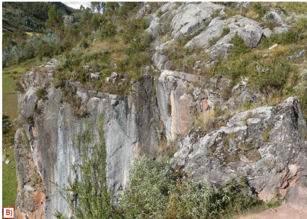
Figura 4.26 Presenta una estructura intacta o masiva, con escasas discontinuidades ampliamente separadas. La condición de superficie es buena, muy resistente y levemente meteorizadas.
