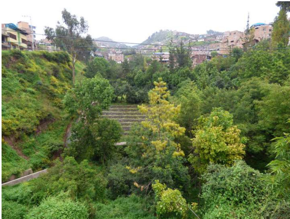
Fotografía 10.43 Vista aguas arriba de la quebrada Saqramayo con trabajos de estabilización.
