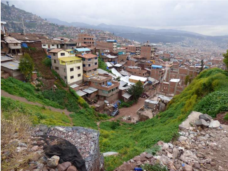
Fotografía 10.44 Viviendas asentadas en la ladera y el cauce de la quebrada.
