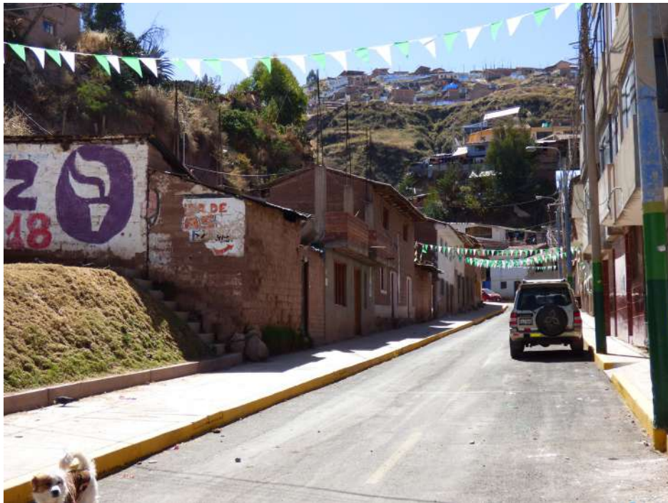
Fotografía 10.9 Cárcava encauzada por la calle Carrizales por un canal revestido de concreto y cubierto por la vereda
