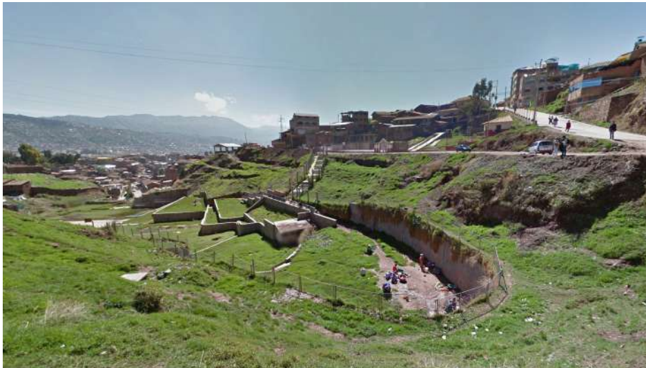
Fotografía 10.47 Cauce de la quebrada Ccorimachachuayniyoc.
