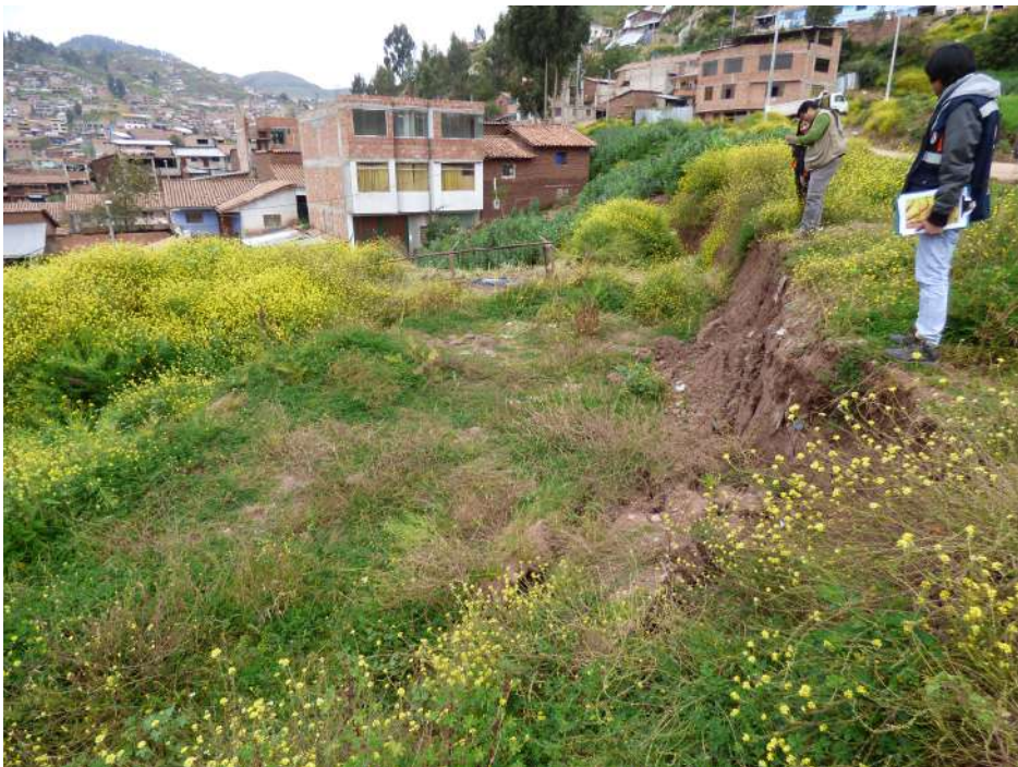
Fotografía 10.30 Escarpa de deslizamiento rotacional activo ubicado en la Asociación Provienda Camino Real.
