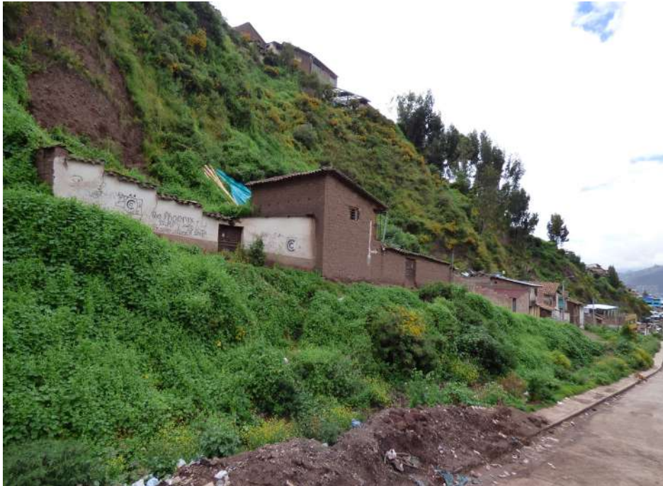
Fotografía 10.35 Viviendas asentadas en el pie y en la cresta de ladera inestable.
