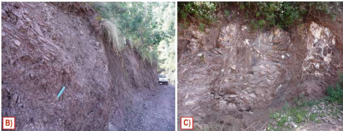
Figura 4.22 a) valores de GSI estimados para la subunidad de areniscas, arcillitas y conglomerados; b) Estación N° 08 presenta macizo desintegrado sin discontinuidades visibles, gran contenido de material fino y fuertemente meteorizado; c) Estación N° 12 formado por macizo de estructura fracturada y perturbada, con numerosas discontinuidades y fuertemente meteorizado.
