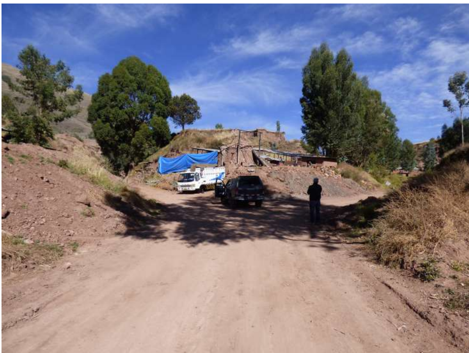
Fotografía 10.4 Confluencia de dos cárcavas por las cuales discurren flujos de lodo que pueden afectar viviendas localizadas aguas abajo.
