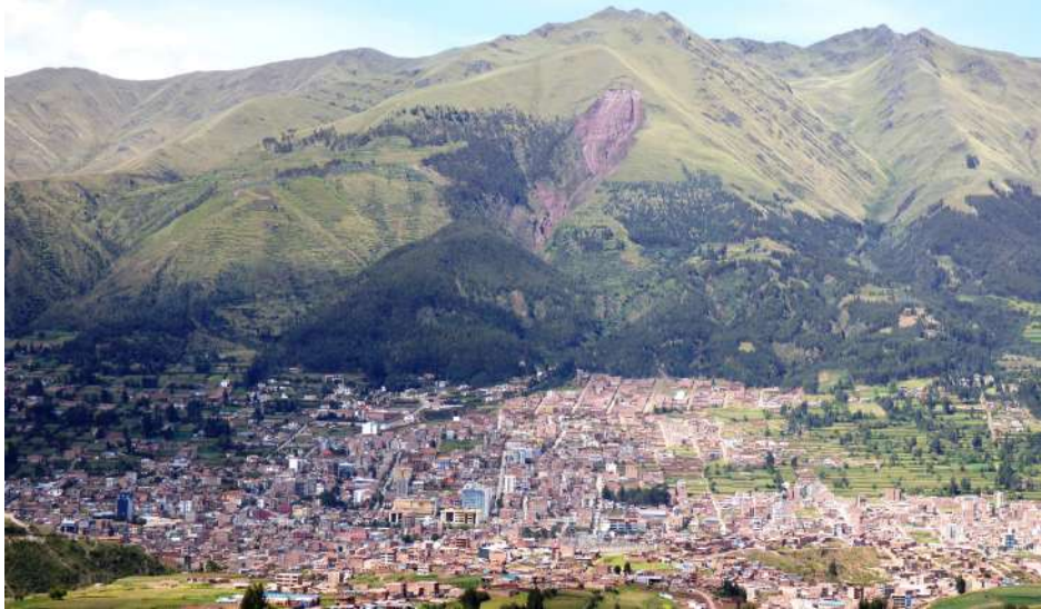
Fotografía 10.7 Viviendas de los sectores de Santa María, Huaynapicol y Larapa que podrían ser afectadas en caso de ocurrencia de flujos de detritos por deslizamiento.
