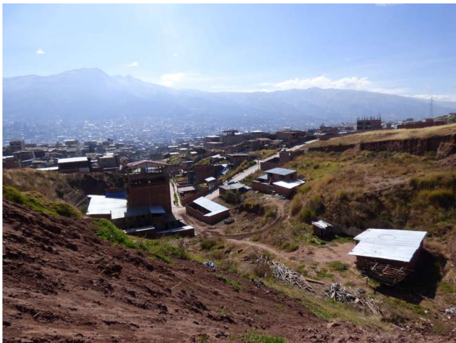
Fotografía 10.14 Vista de aguas abajo de cárcava ocupada por viviendas de la A.P.V. El Chaparral; se observan pequeños derrumbes en la parte alta de la cárcava.
