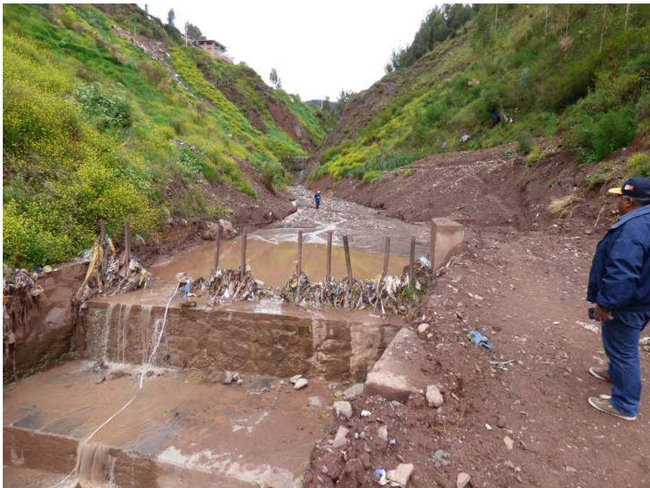
Fotografía 10.28 Flujos de detrito y lodo que se generan producto de derrumbes detonados en temporada de lluvias.
