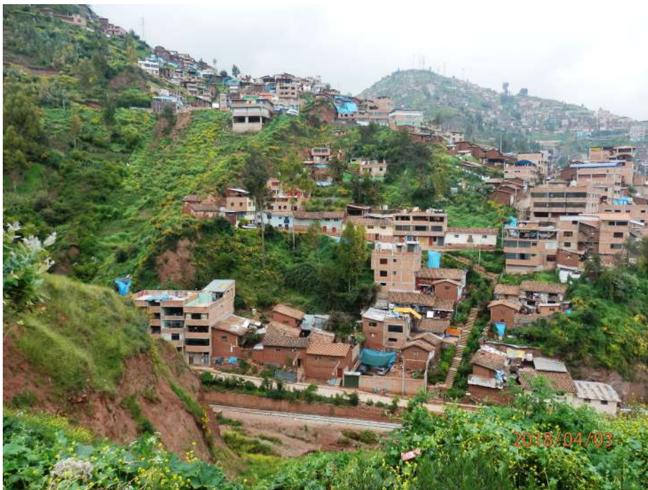
Fotografía 10.40 Viviendas asentadas en ladera de la quebrada Sipaspujo.
