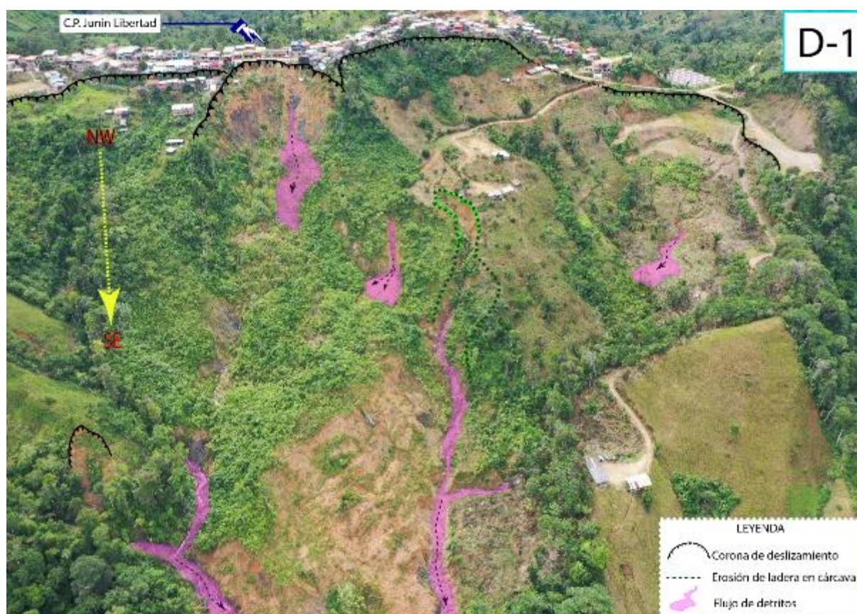
Figura 11. Vista del deslizamiento rotacional (D-1), con dirección de desplazamiento NW-SE. Fuente: Fotografía capturada por el dron el día de inspección en el C.P. Junín Libertad (26/03/2022).
