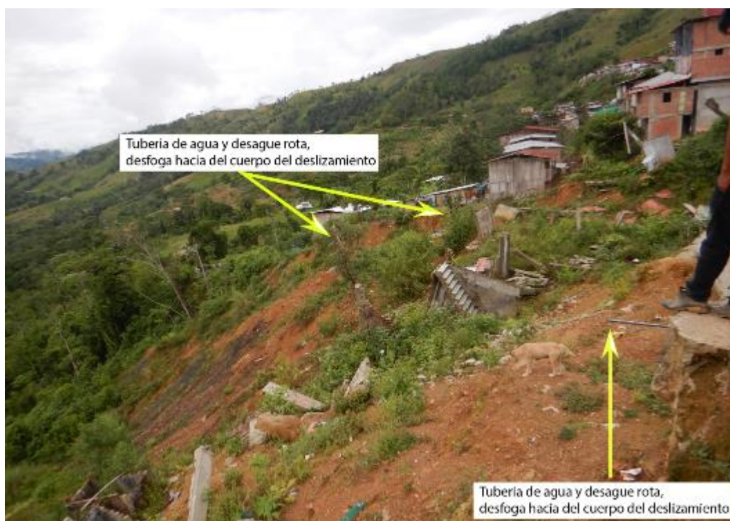
Figura 14. Vista de tuberías de agua y desagüe rota que desfoga directamente sobre el cuerpo del deslizamiento
