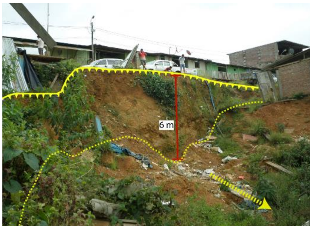
Figura 13. Vista del escarpe principal con un salto de 6 m, ubicada con coordenadas UTM (WGS 84): 607214 E; 8630446 N.
