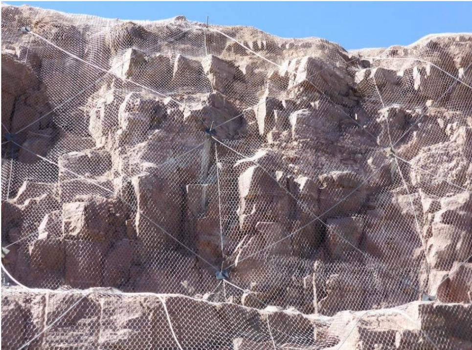
**Fotografía 2.** Control de caída de rocas utilizando mallas ancladas.
