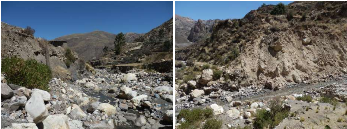
Foto 18: Derrumbes en terrazas aluviales, en ambas márgenes de la quebrada Yunga.
