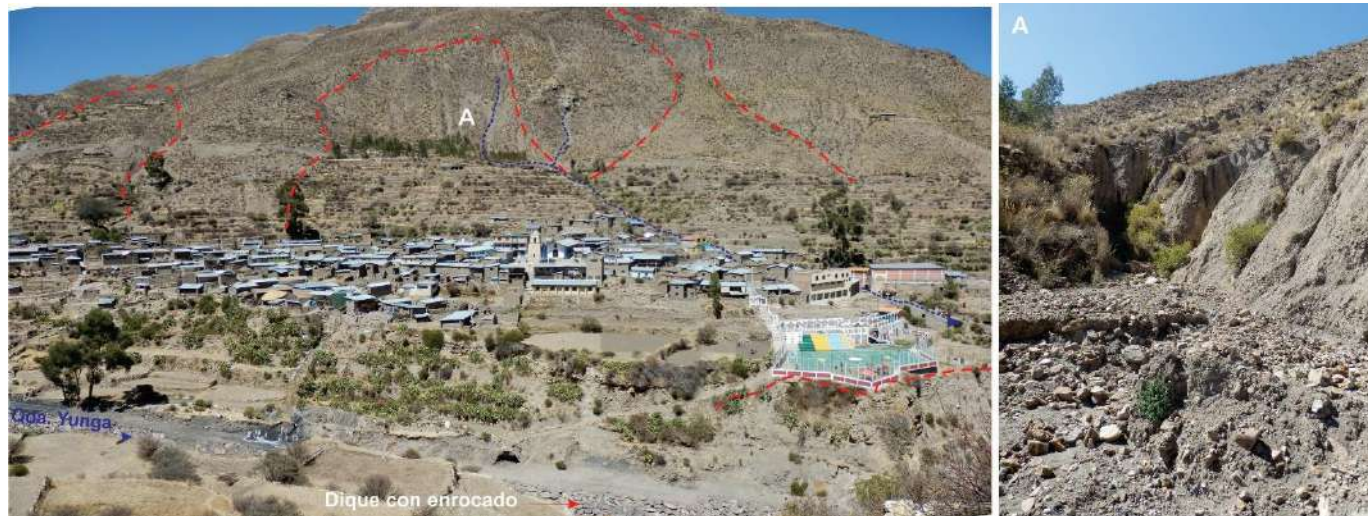
Foto 3. El poblado de Yunga asentado sobre depósitos antiguos de remoción en masa, algunos se reactivaron en forma de cárcavas por donde discurren huaicos como se puede apreciar en la ampliación (A) debido al abundante material suelto en las laderas del cerro Machapata. En líneas de color azul se observa la trayectoria del huaico del 16 de diciembre del 2012 que afectó al poblado de Yunga. También presenta erosión fluvial en la margen izquierda de la quebrada Yunga, con presencia de derrumbes reactivados por socavamiento del pie del talud de la ladera o terraza, infiltraciones naturales y de riego.
