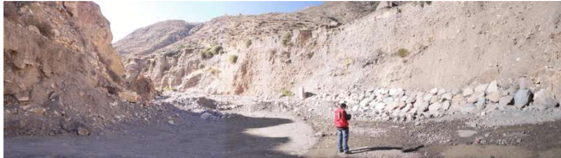
Foto 2. Quebrada Yunga, cauce colmatado debido a los derrumbes y erosión de laderas en ambas márgenes en el cruce de la carretera Yunga-Ichuña.
