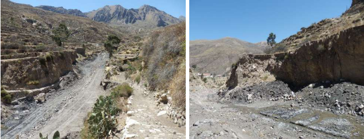
Foto 23: Erosión fluvial genera derrumbes en ambas márgenes (foto izquierda), derrumbe al pie de un depósito de remoción en masa antigua en la margen derecha de la quebrada Yunga (foto derecha)
