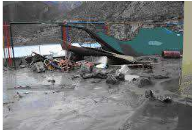
Foto 13: Vistas de los daños causados del huaico ocurrido el 18 de diciembre del 2012 donde se muestra las características del flujo de lodo y piedras en la quebrada sin nombre. La falta de encauzamiento de la quebrada originó la inundación de viviendas en todo su recorrido. Fuente: La República
