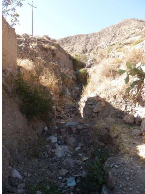
Foto 10: Vista aguas arriba de la quebrada que se encuentra en la prolongación de la calle 3, por donde discurrió un huaico el 16 de diciembre del 2012, el cual afectó muchas viviendas en el poblado de Yunga.
