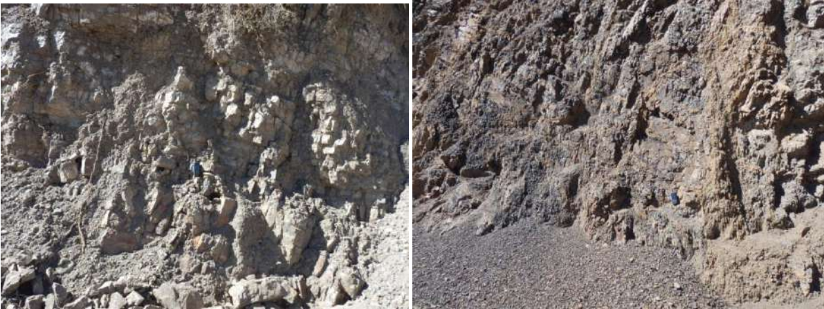
Fotos 04 y 05: Afloramiento de areniscas grises muy fracturadas (arriba), intercalación de lutitas grises y negras muy deleznable, y fracturadas, con presencia de alteración (abajo).
