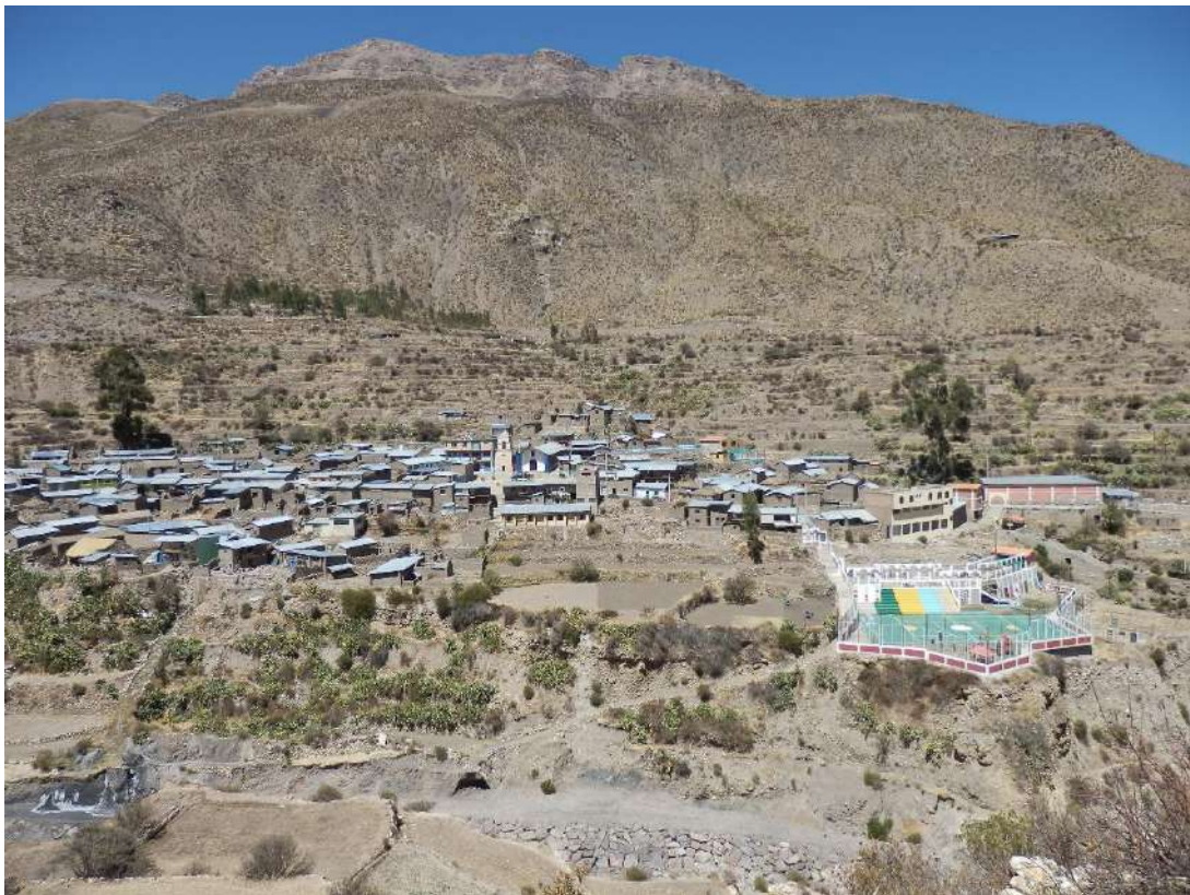
Foto 1. Vista del poblado de Yunga. Encima del poblado se observa erosión en cárcavas que época de lluvias intensas o excepcionales acarrear huacos debido al material acumulado en las laderas, al pie del poblado es afectado por erosión fluvial (foto tomada el 6 de setiembre del 2013 por G. Luque).
