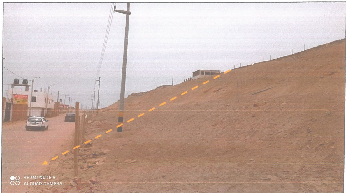
Evidencia de desnivel de 8 a 10 m de la terraza aluvial con respecto a la parte baja que comprende la terraza marina inconsolidada, frente a la Av. Aviación dentro del sector de Huanchaquito Bajo
