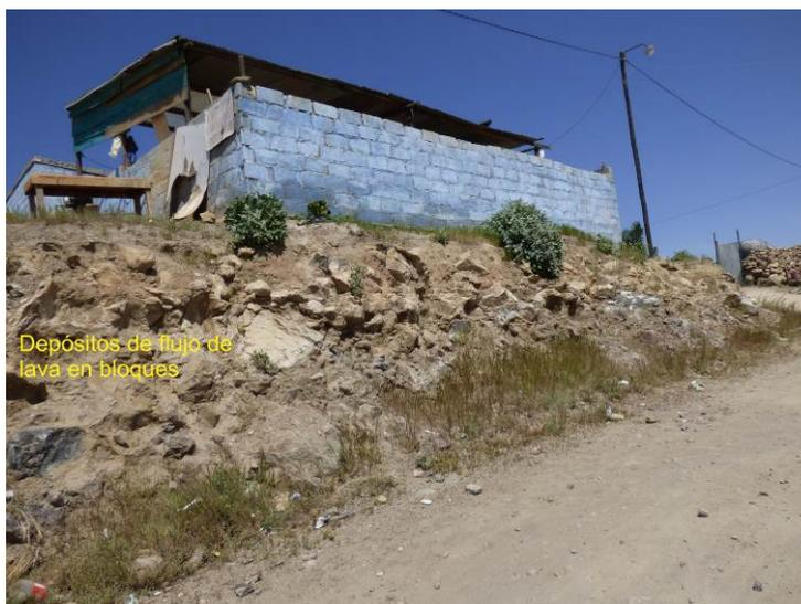
*Fig. 5 Flujo de lava en bloques con material removido y suelto donde se encuentran asentadas algunas viviendas, las cuales están vulnerable a un eventual desprendimiento de rocas.*
