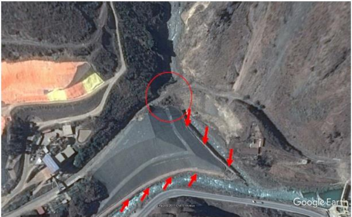
Figura 4: Relavera Triana, obsérvese los frentes de erosión (flechas rojas) y el terraplén o dique (alcantarilla) que sirve como puente para el FFCC. Se considera de alto riesgo, ya que se puede “taponear” y luego colapsar.
