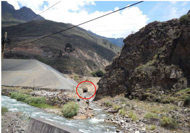
Figura 6: Desembocadura de la quebrada Parac /Aruri en la margen izquierda del río Rímac. Obsérvese la alcantarilla y el dique que sirve como puente para el FFCC. Foto: mkMariofx (Panoramio)
