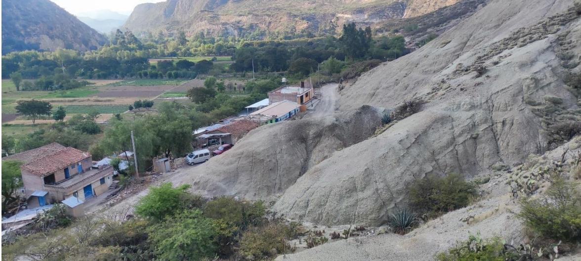
FOTO 01: Vista de la zona en evaluación del peligro por movimiento en masa.
