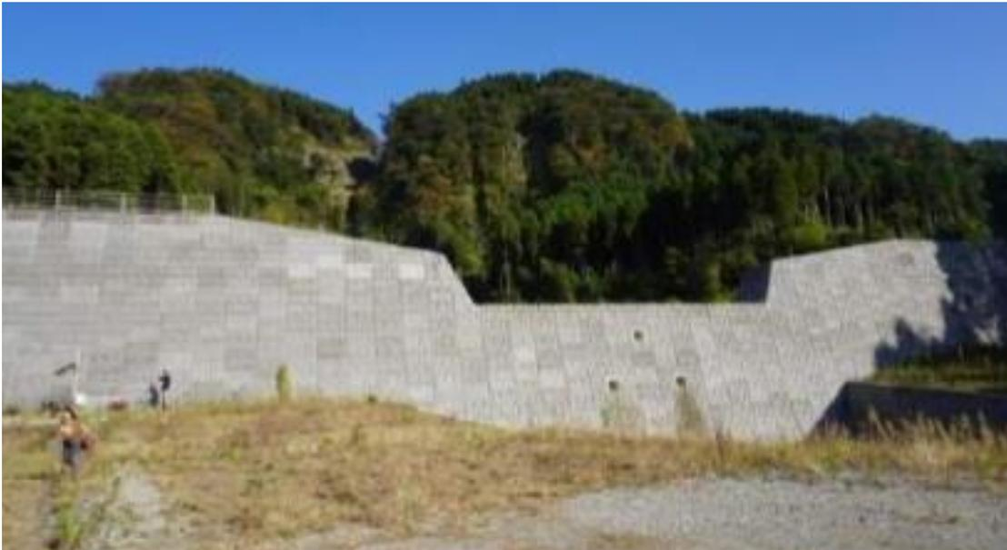
**Figura 30.** Represa SABO para el control de flujos de detritos en Minami-Aso Village (Kumamoto). Nótese el gran tamaño de la misma (Foto: S. Villacorta, 2015).
