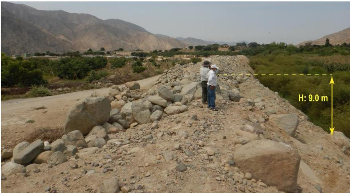
**Figura 17.** Material acarreado por el evento de 1993 que sirve como muro protección y construido de manera artesanal con el fin de proteger a la población.
