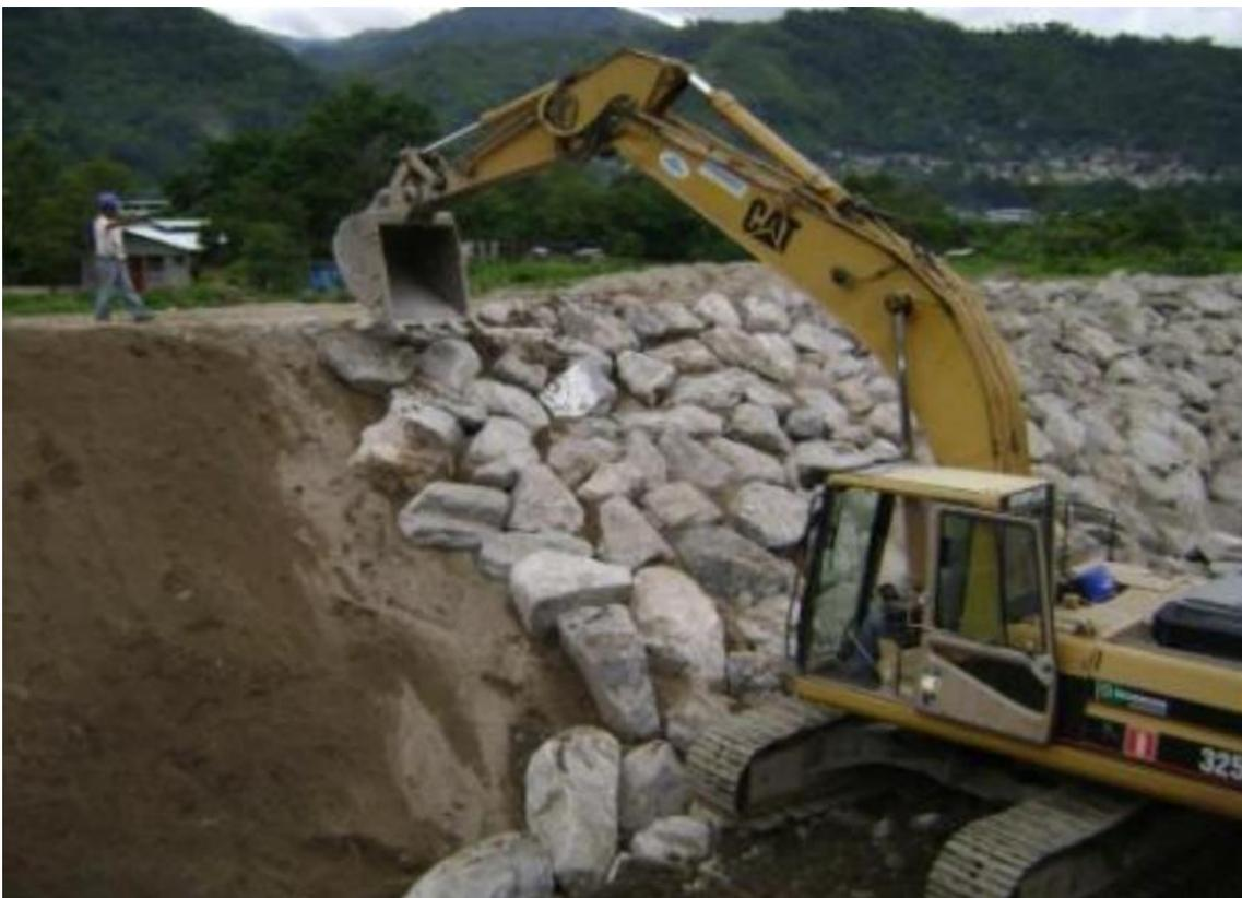
**Fotografía 4.** Protección de riberas mediante enrocados
