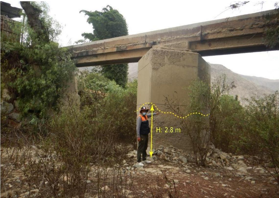
**Figura 19.** Huellas o marcas en los estribos de un canal de agua que según reportan los pobladores corresponde a las dejadas por el evento del año de 1997, donde se evidencia alturas de flujo de 2.8 m.
