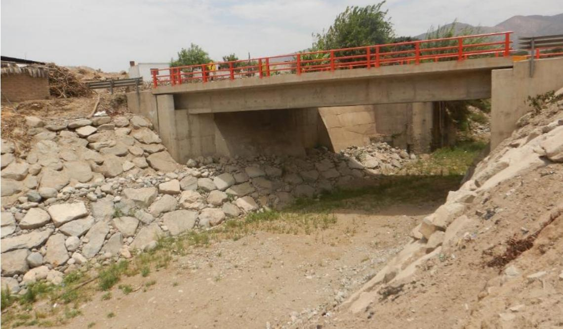
**Fotografía 3.** Vista del puente Lumbra, el cual fue reconstruido debido al fenómeno de El Niño del año 1983; ahora presenta enrocados que lo protegen ante posibles reactivaciones de flujos.
