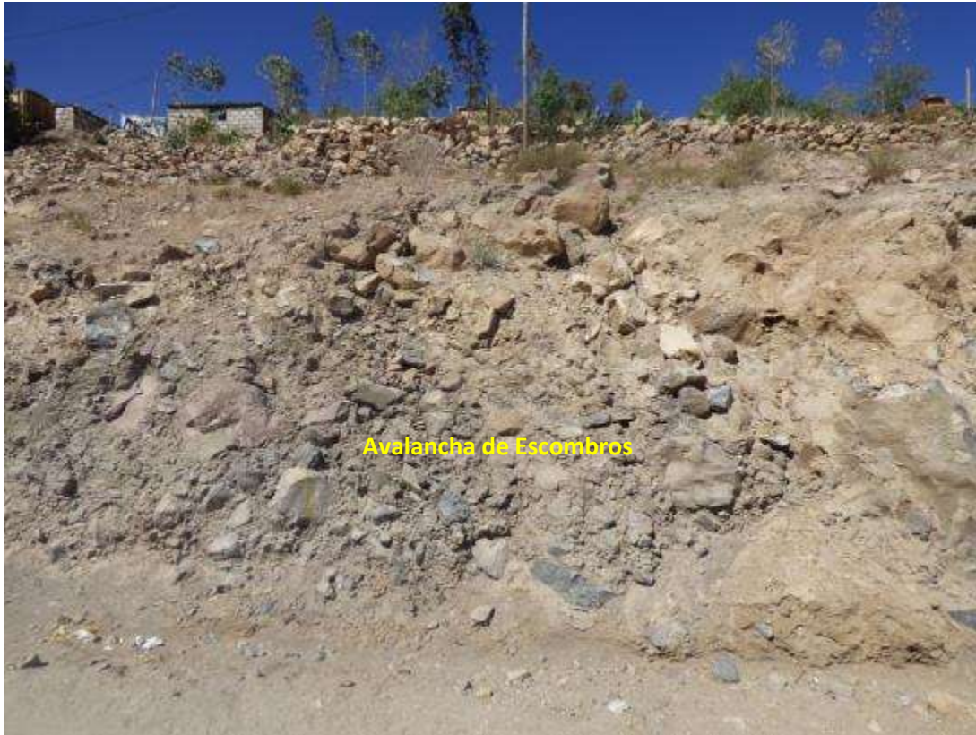
Figura 5: Depósitos de avalancha del escombros sobre la cual están asentadas las viviendas de Villa Ecológica del distrito de Alto Selva Alegre.
