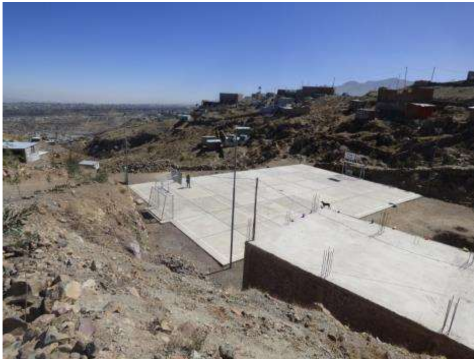
Figura 13: Cancha en la Asociación de Vivienda Nueva Villa Ecológica, construida en la misma quebrada.
