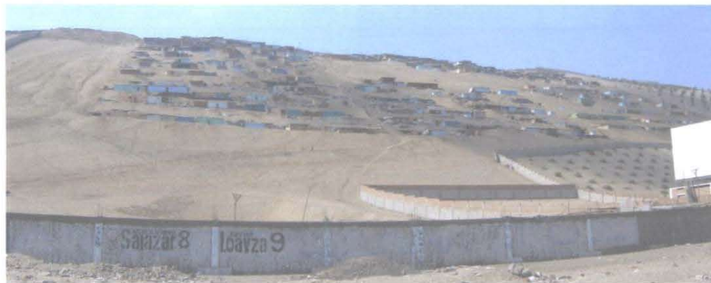
Algunas de las vistas tomadas en los trabajos de campo muestran viviendas rústicas en un mayor porcentaje de un piso, algunas infraestructuras principales (colegios y otras en la parte superior), donde la pendiente es menor a sub-horizontal, construidas de material noble.
