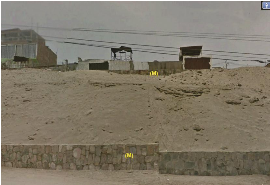
Foto 26. Muros de contención (M), frente a la manzana "E"
