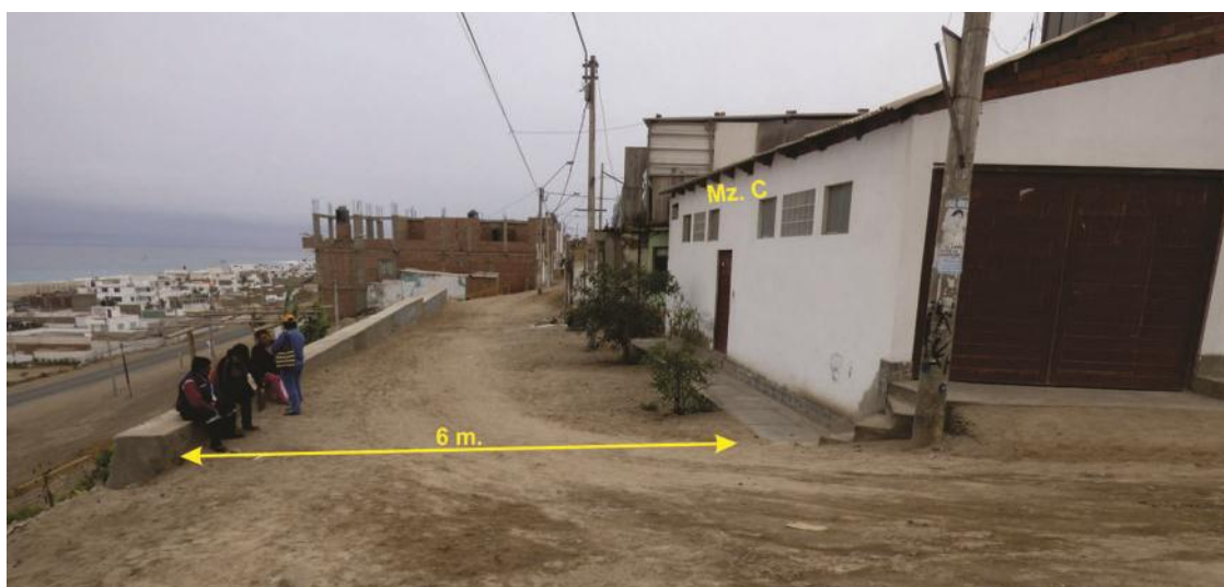
Foto 24. Muro de contención y la manzana "C".
