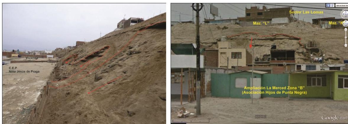
Fotos 16a y 16b. Derrumbes locales (líneas color rojo), generados por la inestabilidad del talud. La vista de la izquierda corresponde a las inmediaciones del centro educativo Niño Jesús de Praga, la derecha corresponde al contorno de la manzana “L” (tomada del Google Earth).
