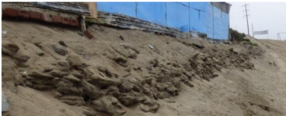
Foto 7. La sal ha envuelto parte de los fragmentos de roca de la pirca.
