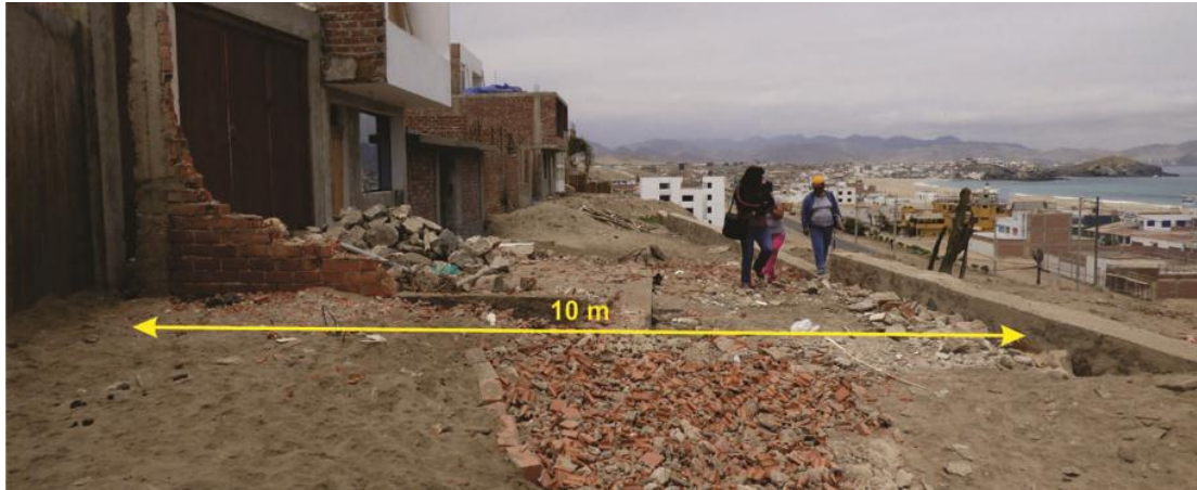
Foto 27. Distancia dispuesta de separación entre el muro de contención y viviendas.
