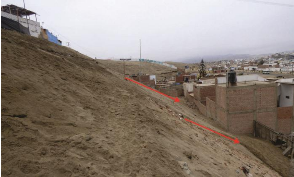
Foto 17. Talud relleno por arena.
