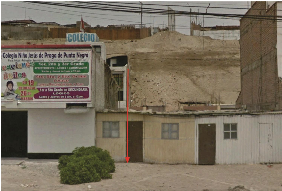
Foto 18. Se muestra la altura del corte de talud (foto extraída del Google Earth).
