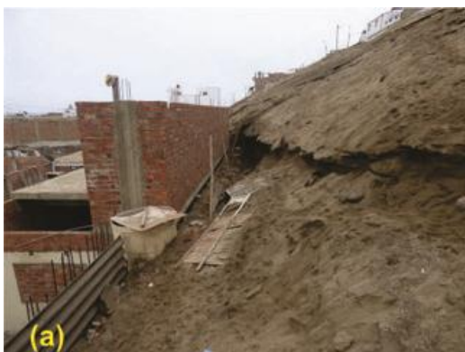
Fotos 11a y 11b. Se aprecian cortes de talud, donde se generan derrumbes localizados, dando la apariencia de techos.
